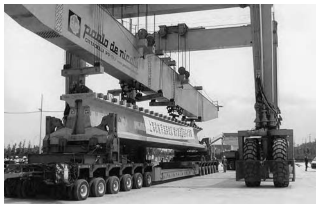
obr. 73 - Přeprava nosníků pro vodící dráhu rychlovlaku Maglev
