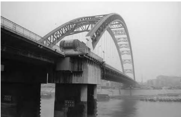
obr. 24, 25 - Most přes řeku Chan-Suej ve Wuhanu byl dokončen v roce 2000
