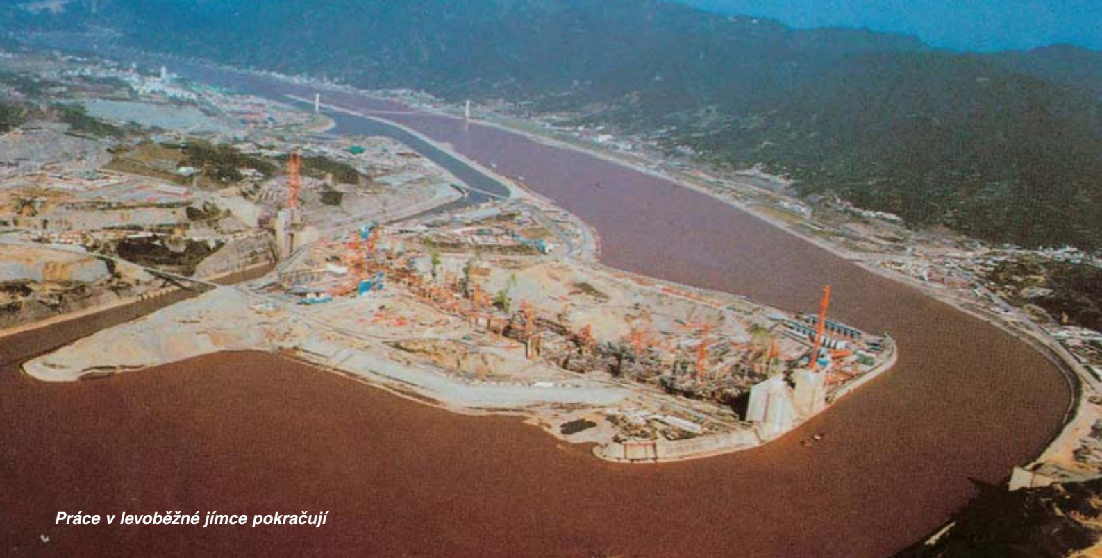
Levobřežní část hráze s hydroelektrárnou a plavební komory se dokončují. Plavba je zajišťována „volnou řekou“.
