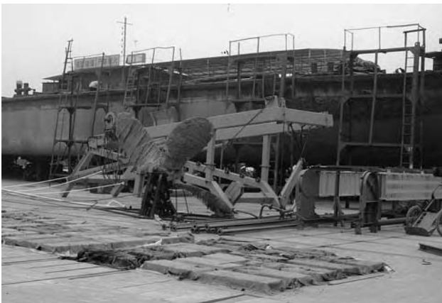
obr.47 – 48 - Opuštěná loděnice v Yichangu
