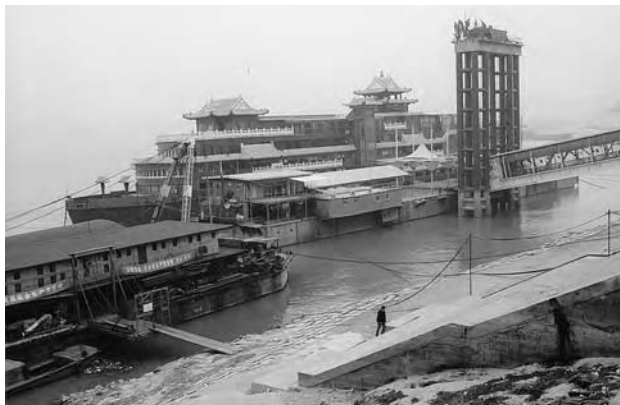
obr. 31 - Mohutný přístavní můstek pro hotelovou loď zcela kopíruje kolísání hladin
