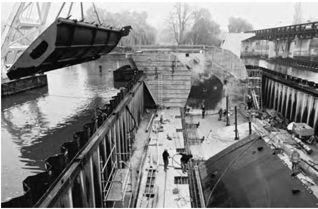
obr. 7 - Výstavba průplavu Seina-Sever – stavba nového jezu Isle Adam na řece Oise
