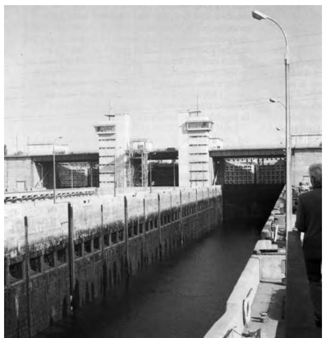
obr.13 - Dvojitě dvojstupňové plavební komory ve Volgogradu na Volze
