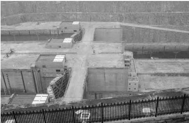
obr. 58 - Spodní ohlavi stupnice plavebních komor na VD Tři soutěsky
