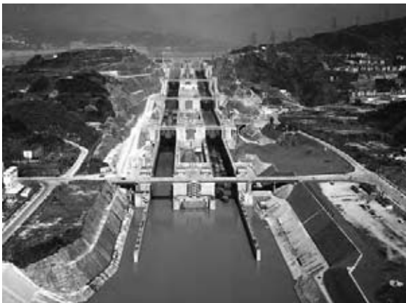
obr. 62 - Největší stupnice plavebních komor na světě
