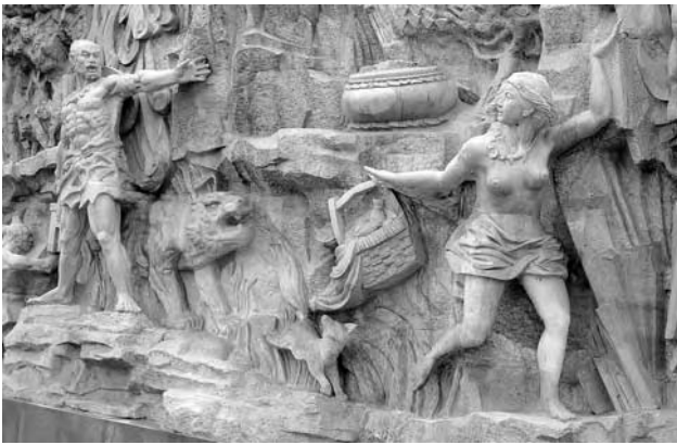
obr. 40 - Protipovodňová zeď ve Wuhanu
