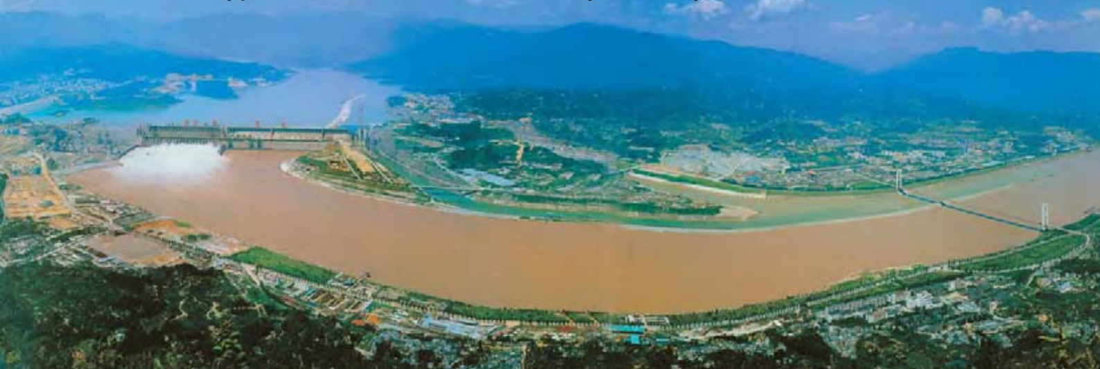
Stavba VD Tři soutěsky před dokončením levobřežní části hráze a hydroelektrárny
