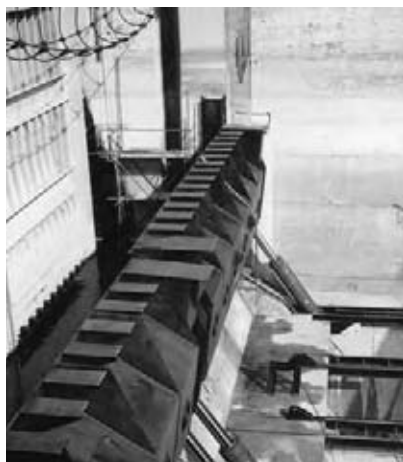
Ing. František Čihák v roce 1994 při výrobě unikátní podpírané jezové klapky pro VD Gabčíkovo
