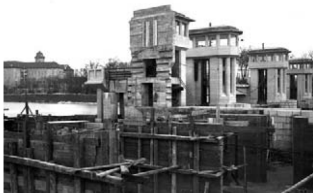
Výstavba pohyblivého jezu v Poděbradech
