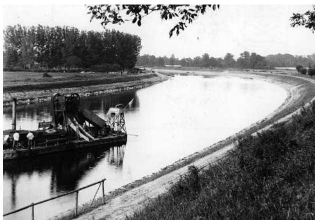
Úprava koryta Labe nad Hradcem Králové
