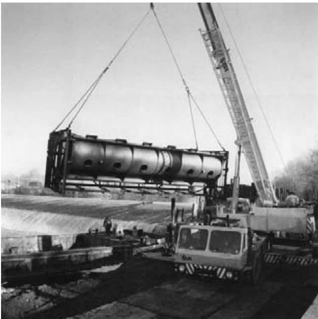
Umísťování moderní prefabrikované jezové klapky při rekonstrukci pevného jezu ve Veletově na Labi
