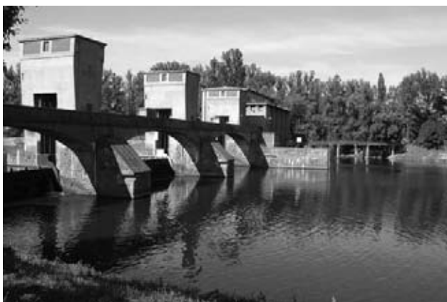
Pohyblivý jez v Lobkovicích s přilehlou vodní elektrárnou
