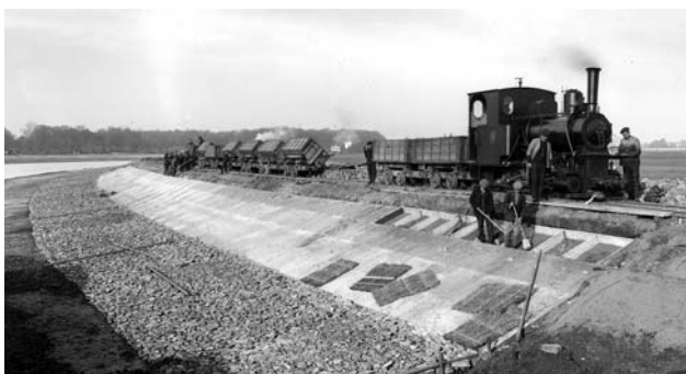
Úprava koryta Labe u Nymburka
