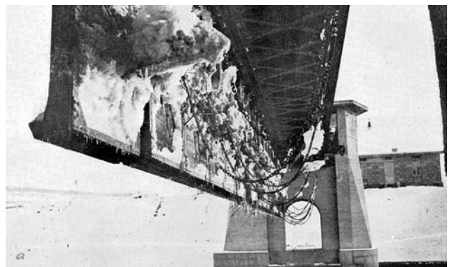
Bývalý pohyblivý jez u Mělníka (Hadík) – pohled na vyhrazené prací pole se stavítkovým uzávěrem zavěšeným na zdvižném mostě
