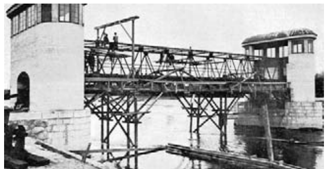
Bývalý pohyblivý jez u Obříství – výstavba levého jezového pole se zdvižným mostem
