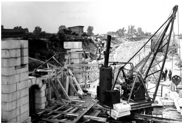
Výstavba plavební komory v Lobkovicích v roce 1922
