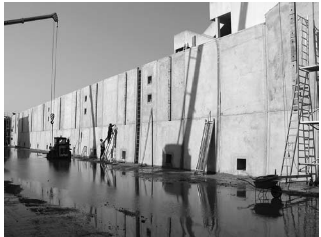
Plavební komora v Lysé nad Labem po rekonstrukci
