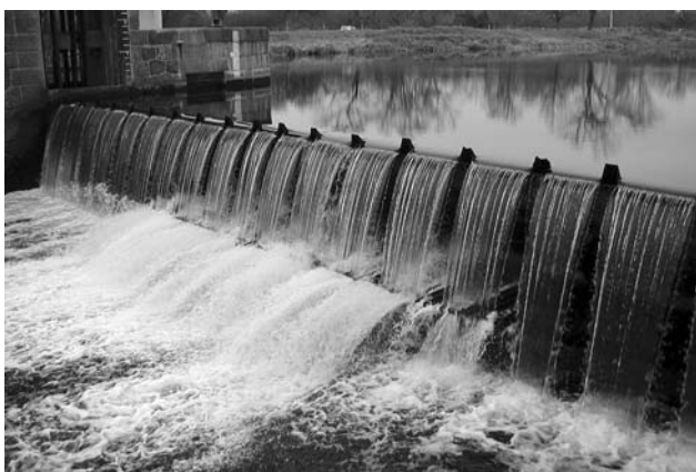
Stavidlový uzávěr typu Stoney s nasazenou klapkou v Čelákovících
