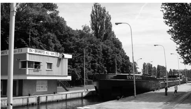
Plavební komora Brandýs nad Labem
