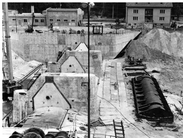
Výstavba nového pohyblivého jezu v Týnci nad Labem
