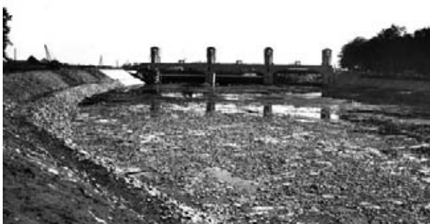
Výstavba pohyblivého jezu a úpravy koryta Labe v Nymburce
