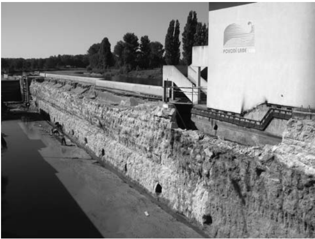
Rekonstrukce plavební komory v Lysé nad Labem
