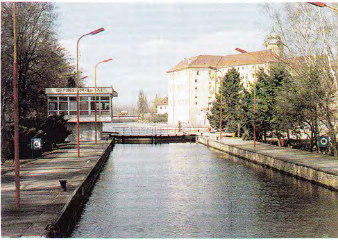
Obr. 1: Plavební komora v Poděbradech
