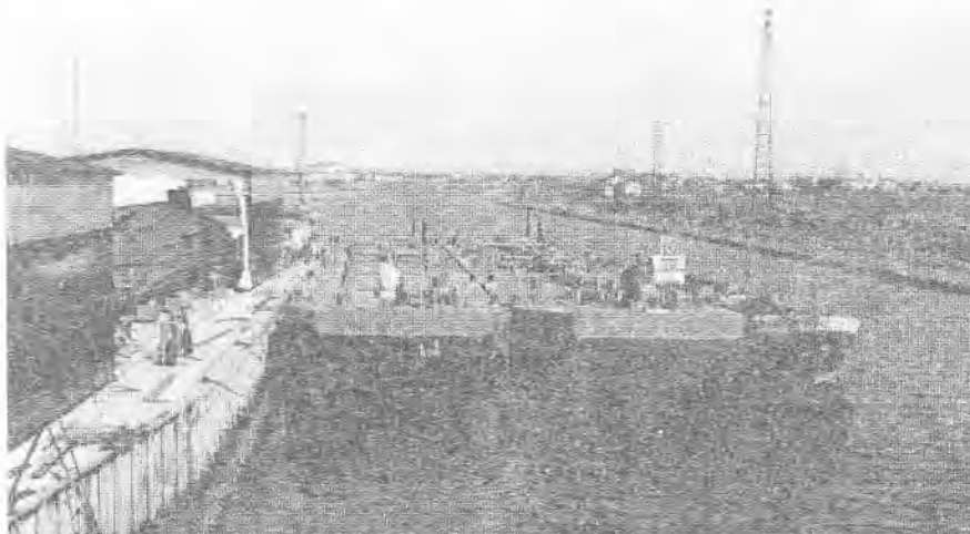
Obr. 6 Speciální čluny na zkapalněný plyn (v loděnici na vodní cestě Canal Bianco)
