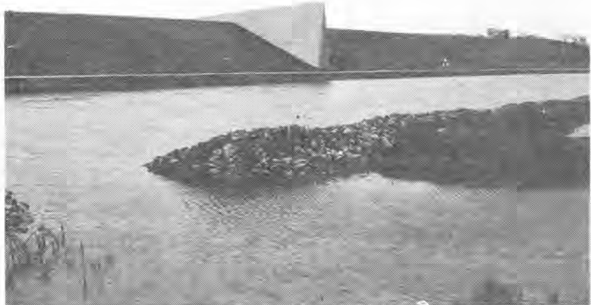
Bild 2: Monument am Main-Donau-Kanal an der Wasserscheide Zwischen Rhein und Donau (MDK - km 102,10). Blick zum Westufer. Im Vordergrund Verbreiterung des Kanals mit Flachwasserzone (künstlicher Biotop)
