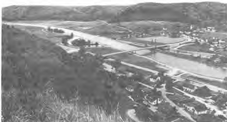
Bild 6: Straßenbrücke bei Meihern im Altmühltal (Main-Donau-Kanal, km 142,3). Blick zu Berg (Richtung Nürnberg)
