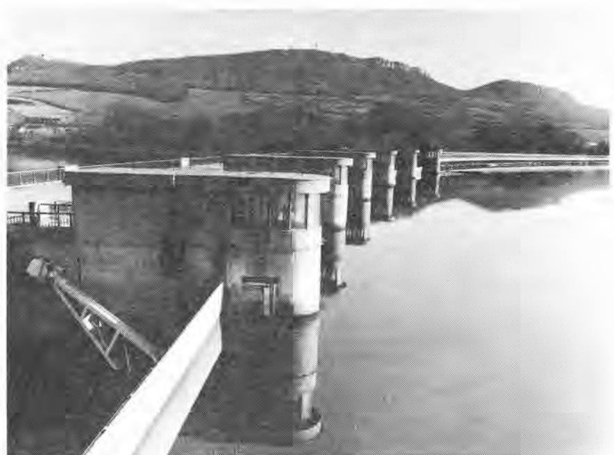
Obr. 2 – Přelivný objekt střední nádrže
