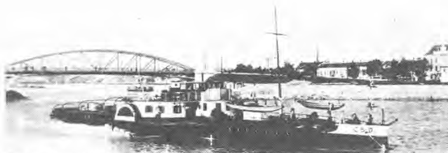
Obr. 4 – Motorový kolesový remorkér Generál M. R. Štefánik, vzniklý v roce 1935 přestavbou vlečného parníku Morava, o výkonu 1050 k a délce 62 m. Lod', přezvaná později na Bradlo, sloužila především k vleku člunů v Kataraktech
