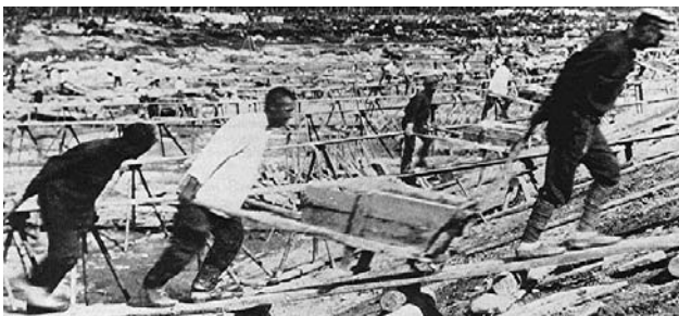
Výstavba Bělomořsko-baltského průplavu vězni prvního sovětského gulagu
