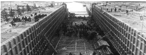
Výstavba dřevěné plavební komory
