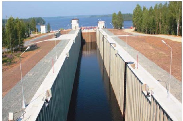
Plavební komora č. 11 po provedené přestavbě – dřevěné stěny nahradily ocelové štětovnice
