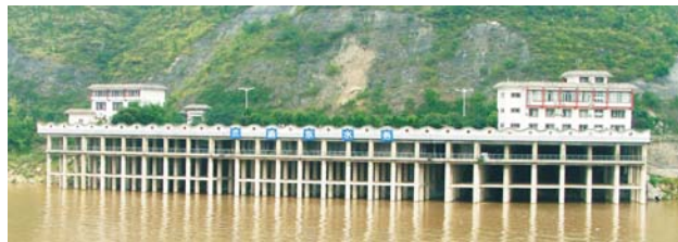
Čistírny odpadních vod ve městě Baotaping. Pro nedostatek místa jsou čistírny stavěny na vysokých pilotách
