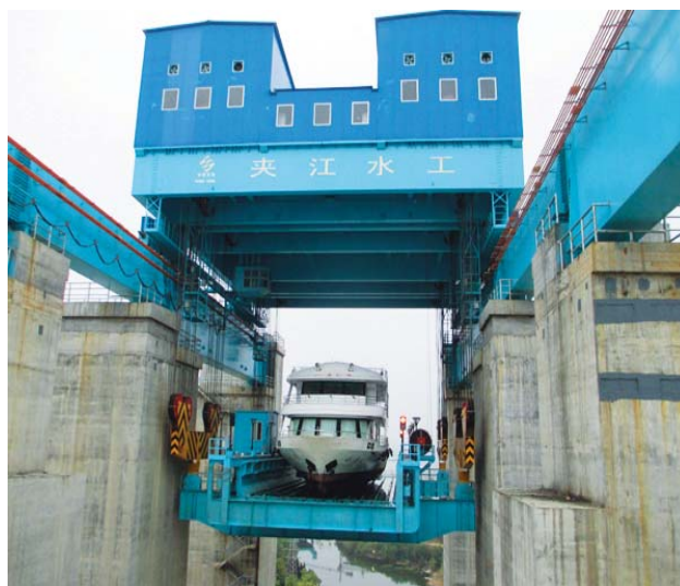
Vertikální lodní zdvihadlo na přehradě Danjiangkou přesouvá až 300tunové lodě do přechodového bazénu. Lodě jsou přesouvány „na sucho“. Přehrada Danjiangkou slouží k odvádění vody z povodí Dlouhé řeky do Pekingu
