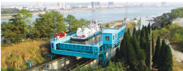
Loď pokračuje „mokrou“ vanou šikmého lodního zdvihadla do dolní vody pod přehradou Danjiangkou
