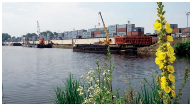
Výstavba 2. etapy nábrežní zdi v přístavu Mělník
