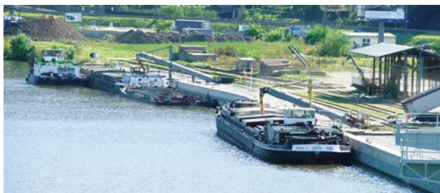
Přístav Ústí nad Labem, překladiště ve Vaňově s dokončenou překladištní hranou
