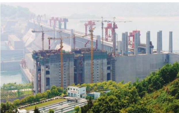
Rozestavěné nejvyšší (svislé) lodní zdvihadlo světa na přehradě Tři soutěsky
