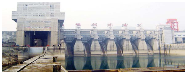
Vertikální lodní zdvihadlo pro lodě do 300 tun na přehradě Hubei Gaobazhou
