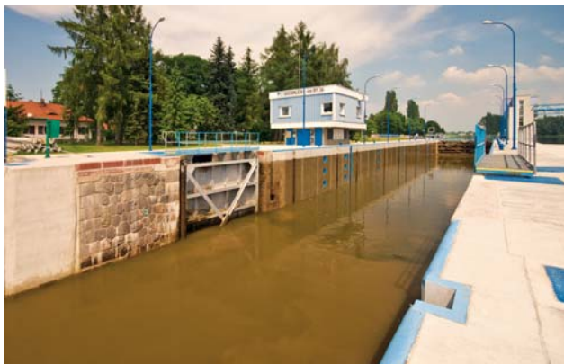
Plavební komora Kostomlátky po rekonstrukci zdí
