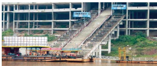
Aby obyvatelé města Badong překonali alespoň výškové převýšení mezi přístavem a centrem města, je zde lanovka, která se musí vyrovnat s kolísající hladinou přehrady
