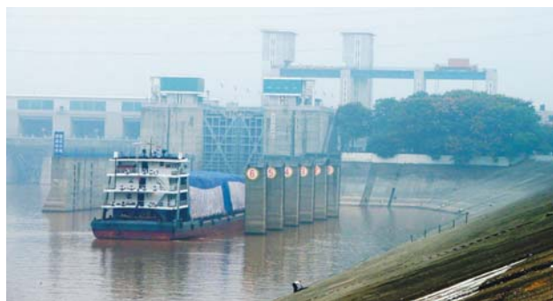
Nákladní loď v dolní rejdě plavební komory přehrady Gezhouba
