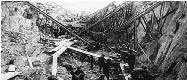
Plavební komora č. 11 ještě s dřevěnou konstrukcí před přestavbou
