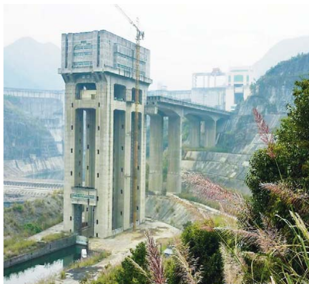
Impozantní dvojité vertikální lodní zdvihadlo pro 300 tunové lodě na přehradě Geheyan
