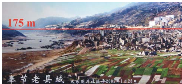
Dnes již historický pohled na staré město s vyznačenou max. hladinou přehrady
