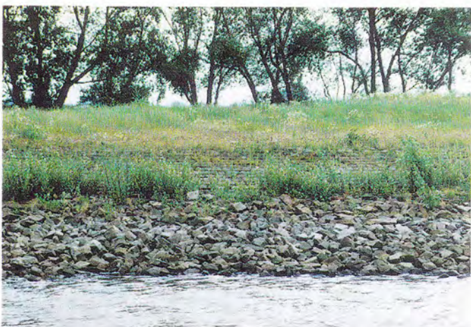
Břehové opevnění Labe u Magdeburku
