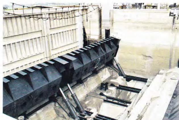
Nové podpírané klapky v horním zhlaví levé plavební komory v Gabčíkově, které budou sloužit jako nouzový uzávěr při případné poruše vrat plavební komory, předaly Vodní cesty s.r.o. investorovi v říjnu 1994
