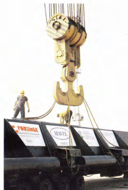
V době Plavebních dnů vrcholila příprava na montáž klapkových vrat v horním zhlaví levé plavební komory v Gabčíkově
