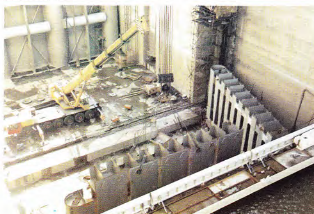
Na podzim 1994 také již probíhala montáž nových opěrných vrat v dolním zhlaví levé plavební komory Gabčíkovo
