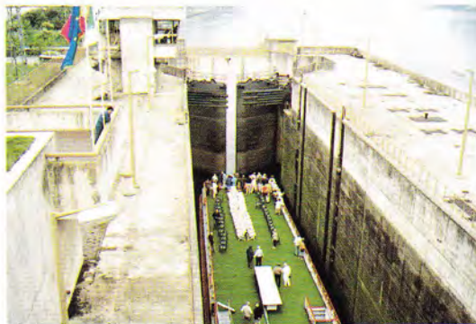
Plavební komora stupně Crestuma-Lever. Současně se zavíráním dolních vzpěrných vrat přechází do pracovní polohy i dynamická ochrana
