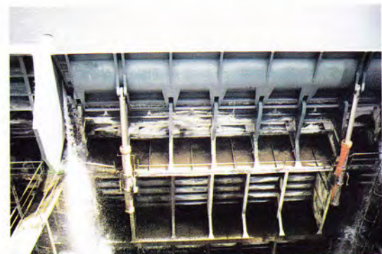
Carrapatelo - detail podpírané, hydraulicky ovládané klapky nasazené na segmentu
