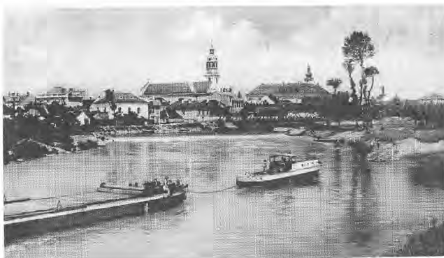
Remorkér a vlečný člun s nákladem lignitu fy Baťa, a.s., Zlín na vod- ní cestě Otrokovice-Rohatec u Uher. Ostrohu (pohlednice z r. 1939)
