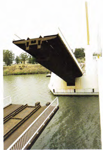
Sklápění železničního mostu přístavní vlečky
