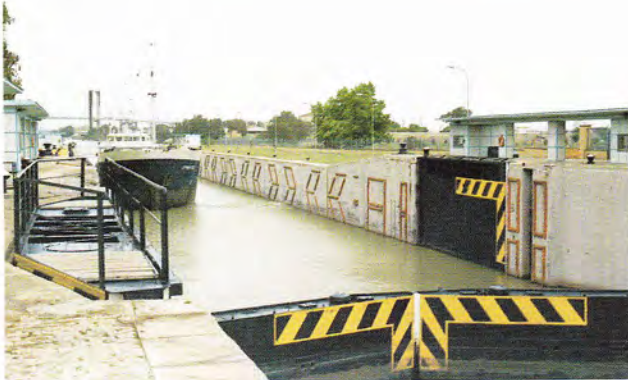
Plavební komora oddělující bazény přístavu u Seville od řeky Guadalquivir
