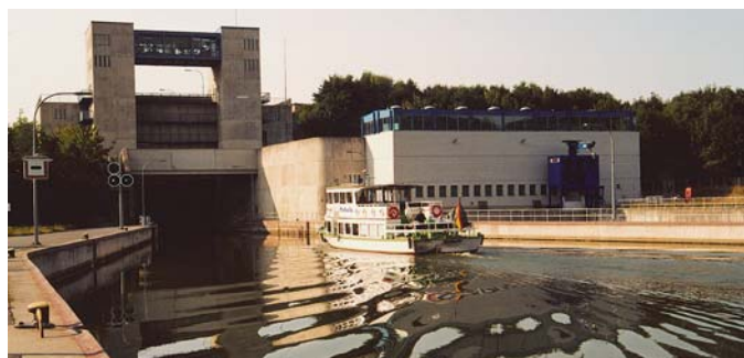
Přecherpací stanice na plavebním stupni Berching na průplavu Mohan-Dunaj
