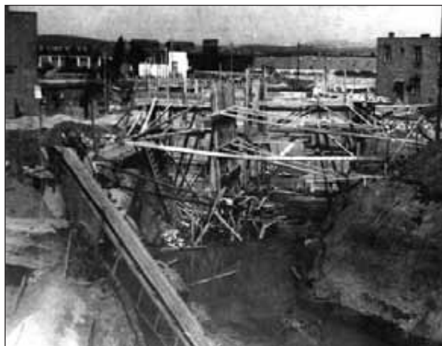
Stavba závlahového a plavebního kanálu Baťov-Rohatec. Stavba plavební komory v závodech - Baťov, foto Selinger 1935, Státní okresní archiv Zlín.
