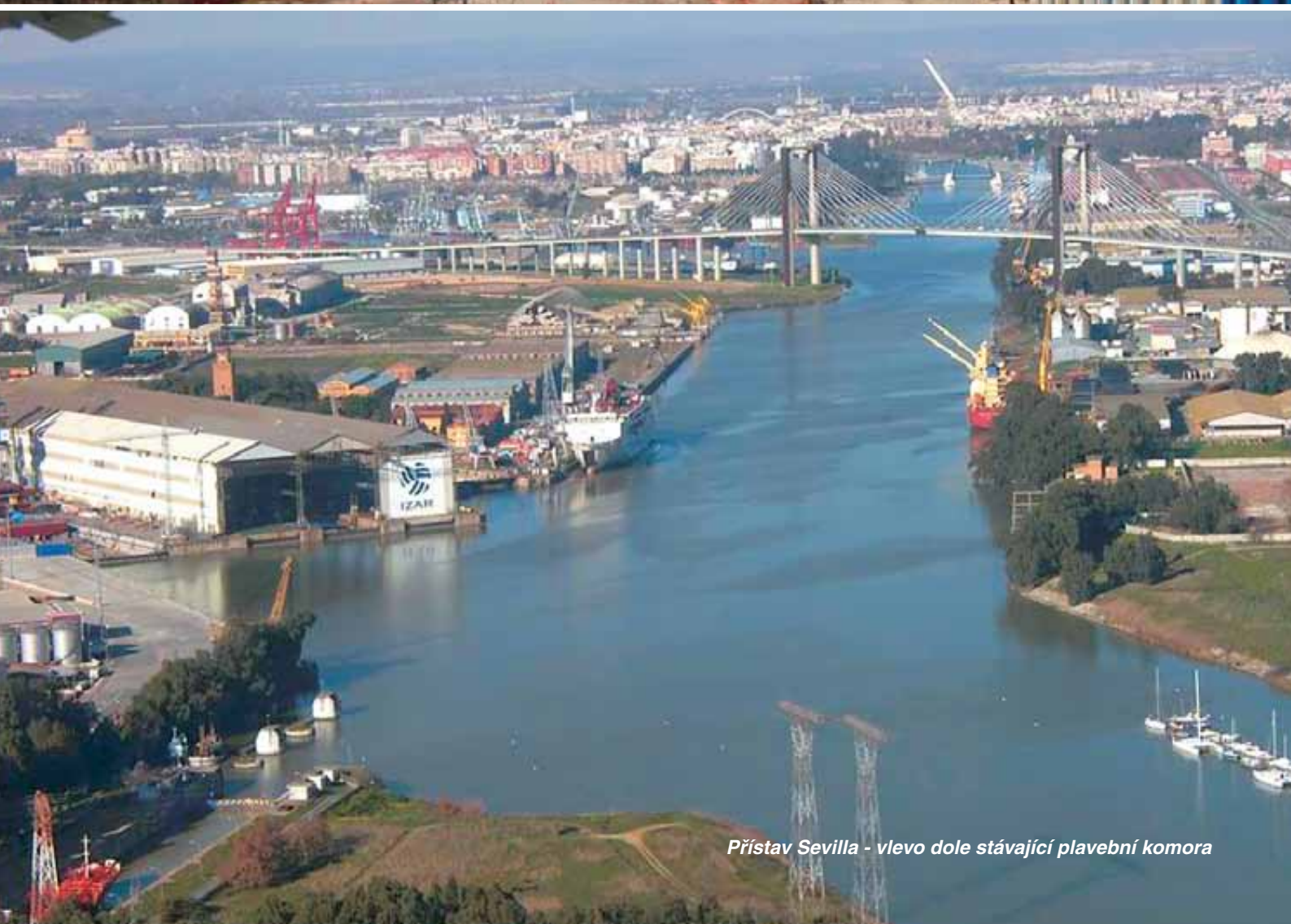
Nová plavební komora Sevilla ve výstavbě
