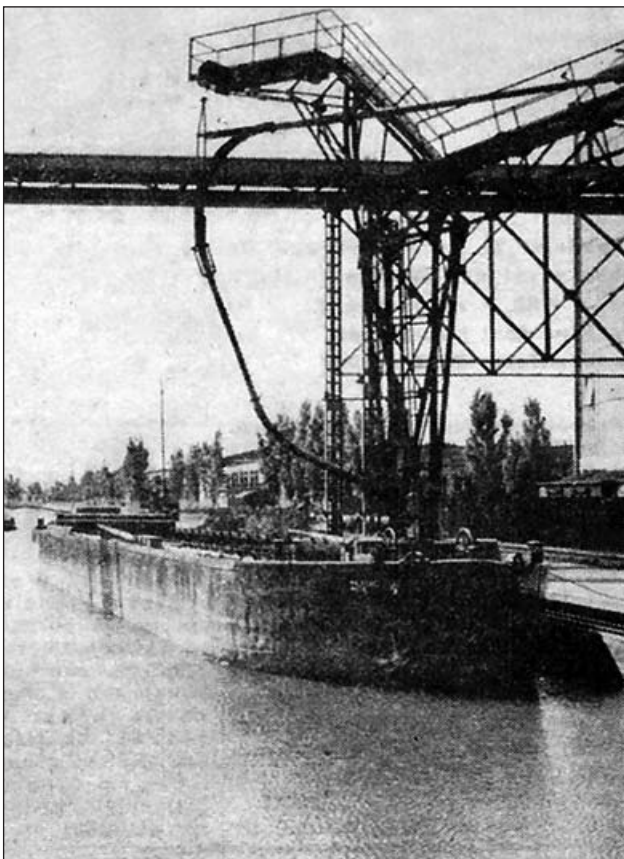
Vykládka lodí s nákladem hnědého uhlí odsávacím zařízením u elektrárny v Baťově 1946, Moravský zemský archiv v Brně, pracoviště Zlín
