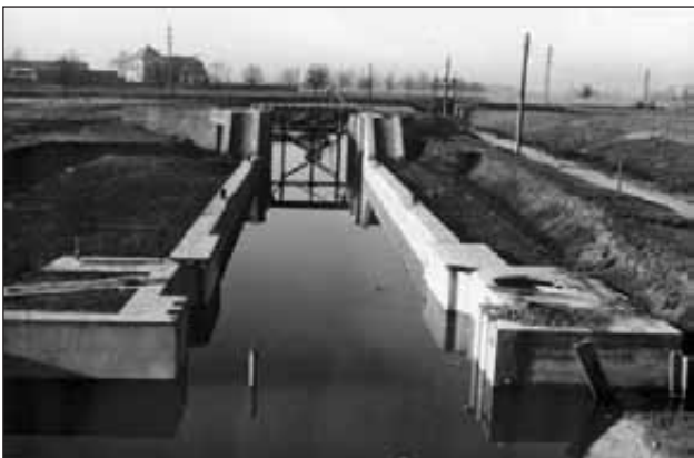
Plavební komora u Starého Města ve výstavbě, foto J. Vaňhara 1936, Státní okresní archiv Zlín
