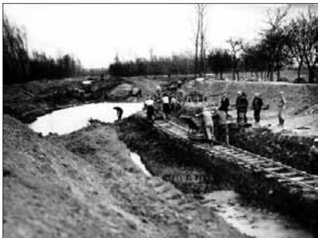
Stavba plavebního kanálu u Strážnice, foto J. Vaňhara 1935, Státní okresní archiv Zlín
