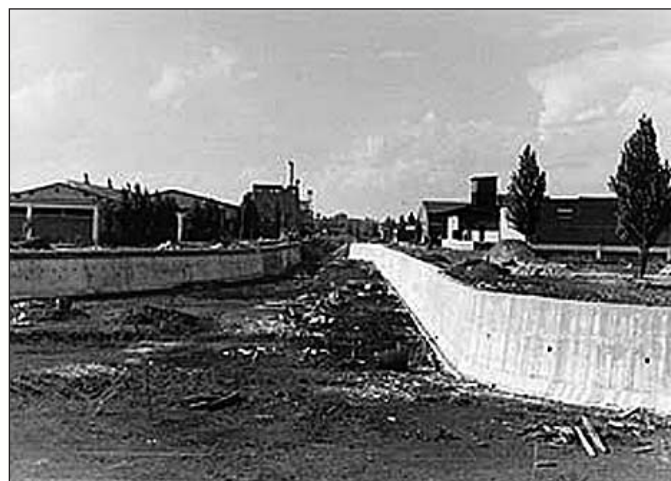
Výstavba přístavu v Batově, Moravský zemský archiv v Brně, pracoviště Zlín
