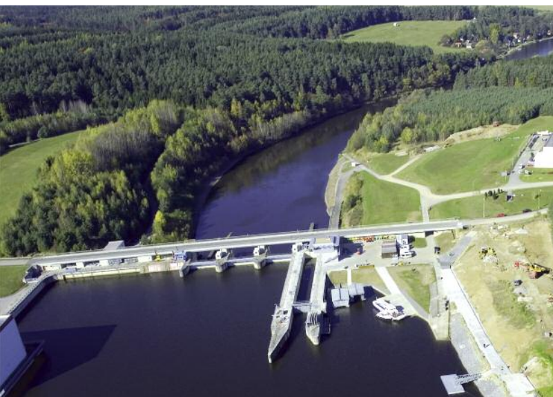
Přehrada Hněvkovice s plavební komorou.
