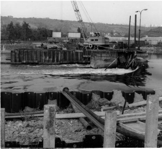
Obr. 2. Výstavba dolní nasazené jímky s výplní z předem připravených krabic z ocelových štětovic, osazovaných do podjezí pravého pole těžkým jeřábem
