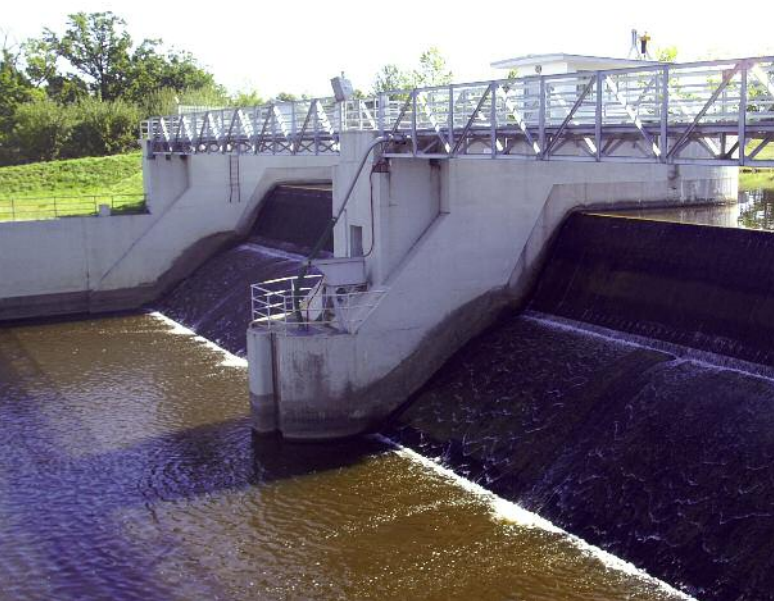
Původní hydrostatický jez v Českém Vrbném.
