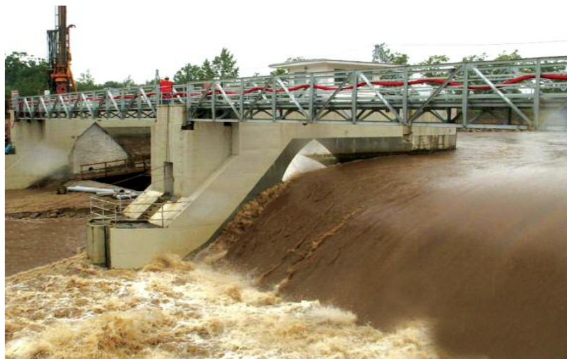
Převádění povodně /25.6.2009/ přes jezovou klapku v Českém Vrbném.
