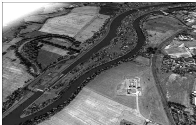
Plavební stupeň Přelouč II po realizaci investiční akce.
