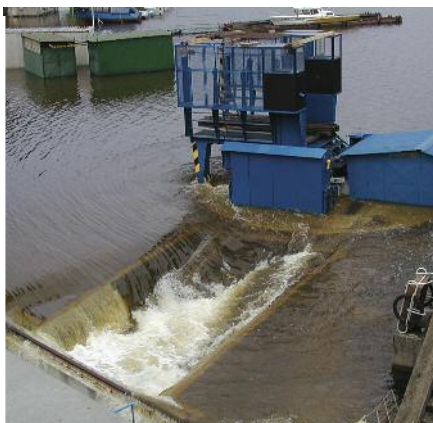
Horní stanice nedokončeného lodního zdvihadla, strojovna sportovního výtahu.
