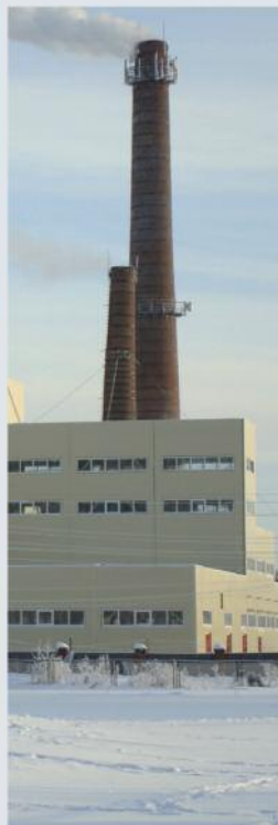
Paroplynová elektrárna Krasavino, Ruská federace
