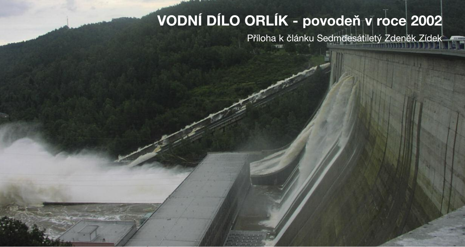
Při katastrofální povodni v roce 2002 přepadala voda přes přelivy, mimo ně i žlabem lodního výtahu.
