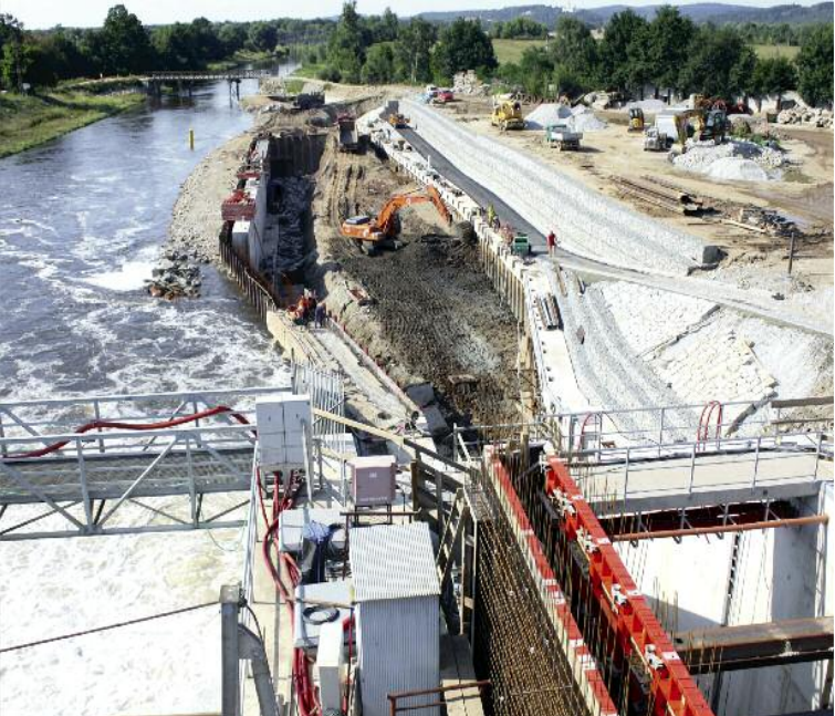
Výstavba plavební komory České Vrbné 2010.
