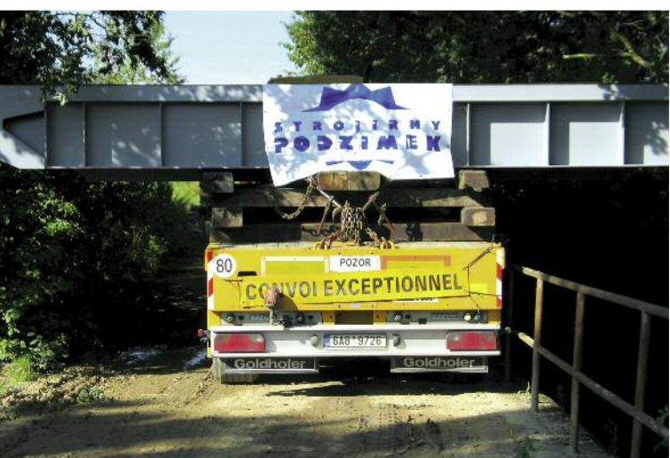
Přeprava dolních vrat plavební komory České Vrbné.
