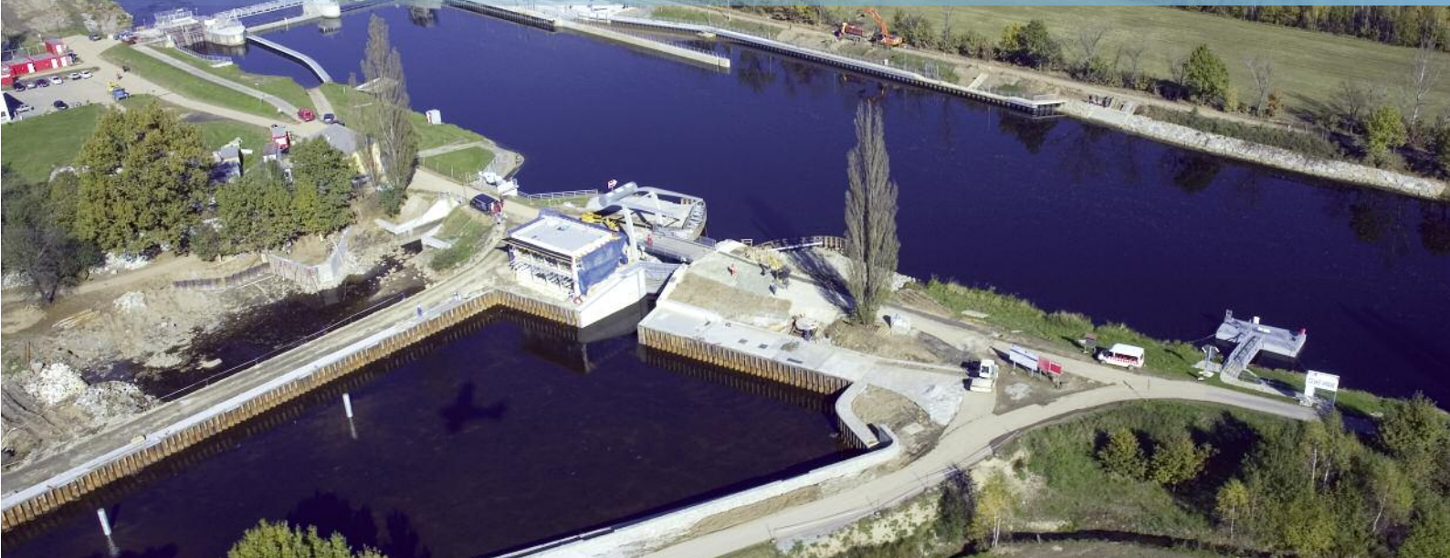
Vodní dílo České Vrbné na Vltavě po dokončení. Nahoře vlevo malá vodní elektrárna a klapkový jez, vpravo plavební komora a dole sportovní přístav se zvedacím mostem a protipovodňovými vraty.
