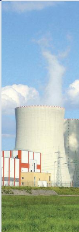
Mezisklad vyhořelého jaderného paliva Temelín, Česká republika
