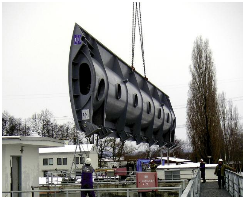
Osazování ocelové jezové klapky.
