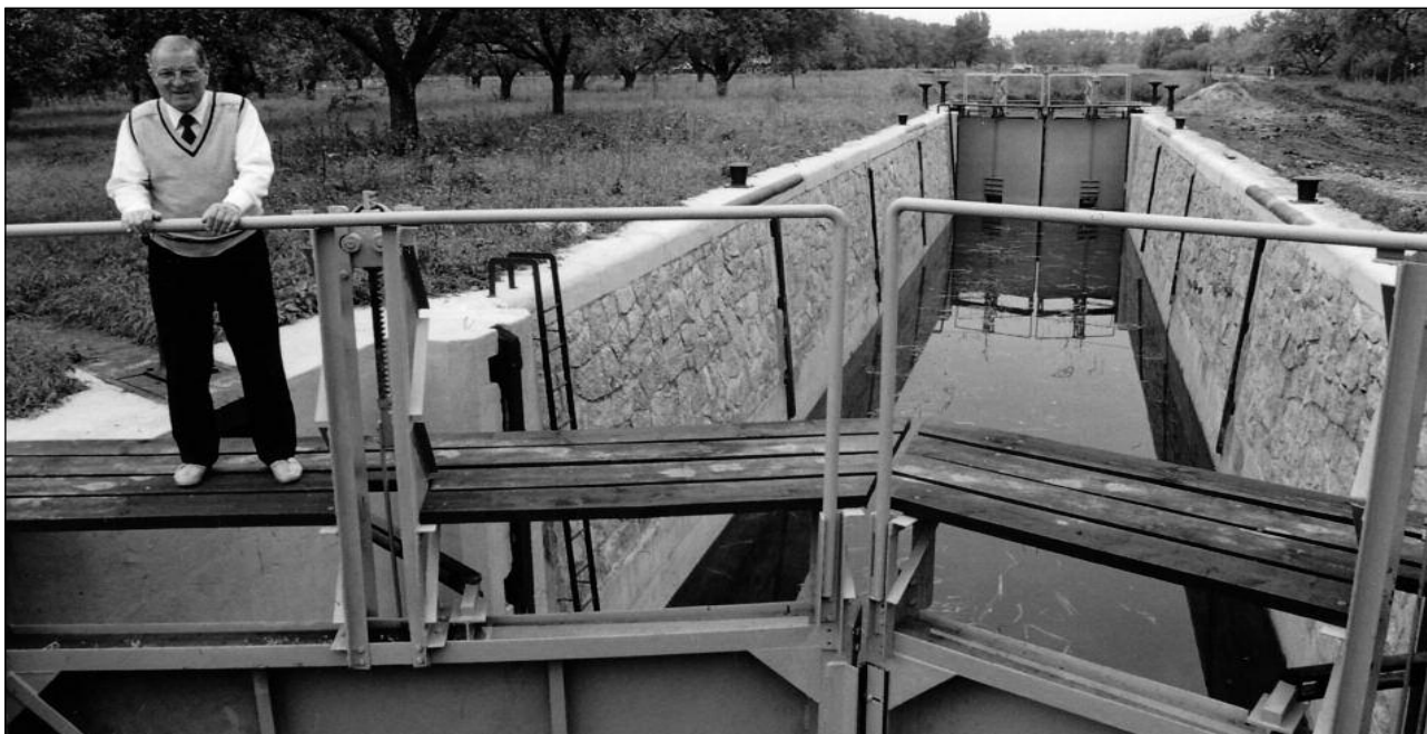
Ing. Jaromír Šlachta na zrekonstruované plavební komoře Strážnice na Bařově kanálu.
