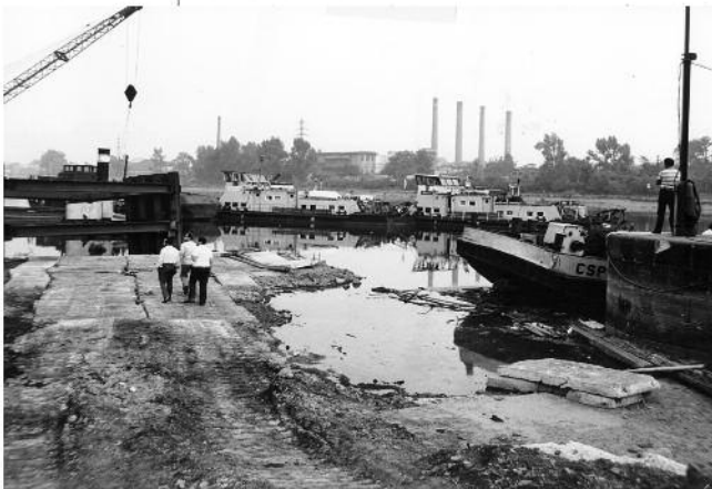
Po uzavření průtoku pravým polem a vyrovnání hladiny byl nákladní člun odtažen dvěma těžkými remorkéry.
