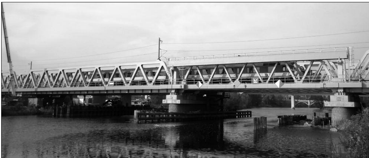
Nový železniční most v Kolíně.
