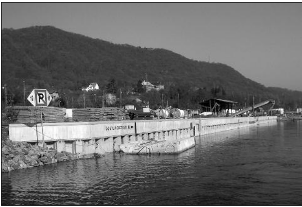
Přístav Ústí nad Labem – Vaňov s novou přístavní hranou.
