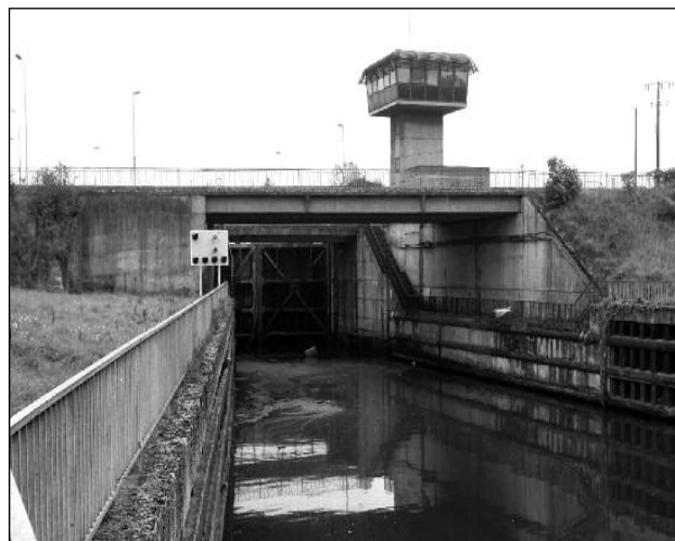
Nejvýše položená plavební komora Neuves Maisons na řece Mosele.
