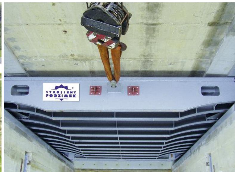
Dolní vrata plavební komory Hněvkovice.
