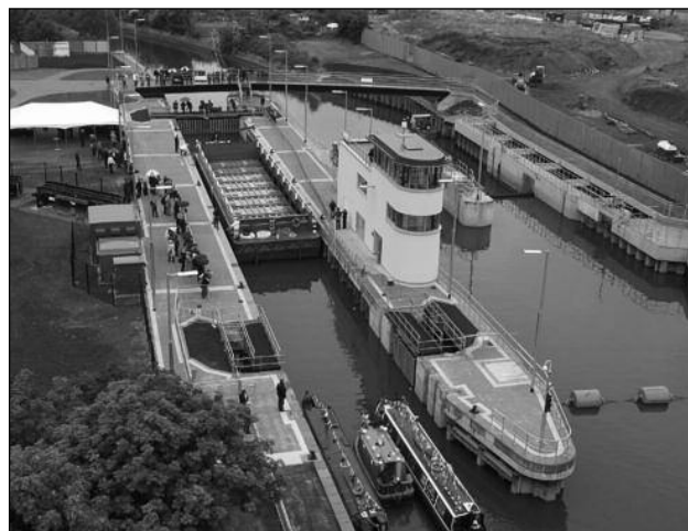
Nová plavební komora a jez Three Mills Lock v Londýně byly dokončeny v roce 2009.
