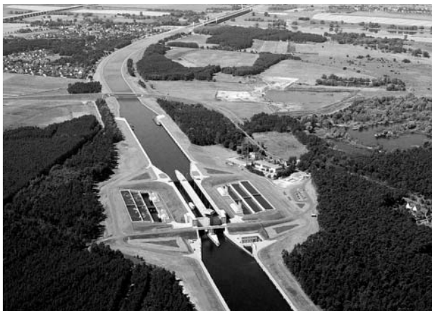
Lodní zdvihadlo Rothense vybudované v roce 1938 bylo v roce 2001 doplněno novou plavební komorou s úspornými nádržemi (obr. vlevo). Průplavní most na Středozemním průplavu přes Labe u Magdeburku byl uveden do provozu v roce 2003.
