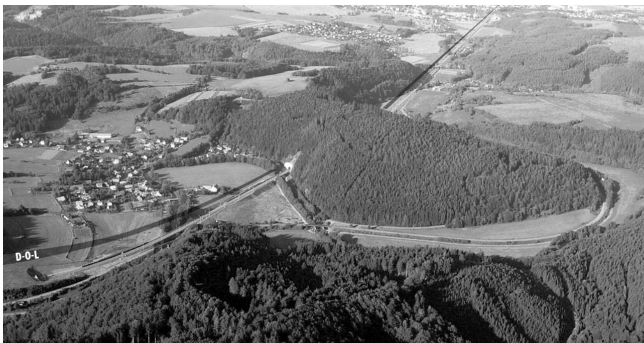
V rámci modernizace druhého železničního koridoru byly nevyhovující oblouky eliminovány tunelem, který protíná meandr, resp. vrch Hejnice. Krátkým tunelem pod tímto vrchem může být vedena i trasa vodního koridoru D-O-L, která v tomto úseku prochází paralelně s železniční tratí
