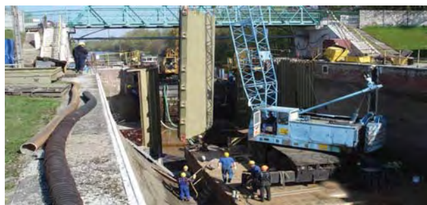
Modernizace plavební komory Bartosowice na Odře
