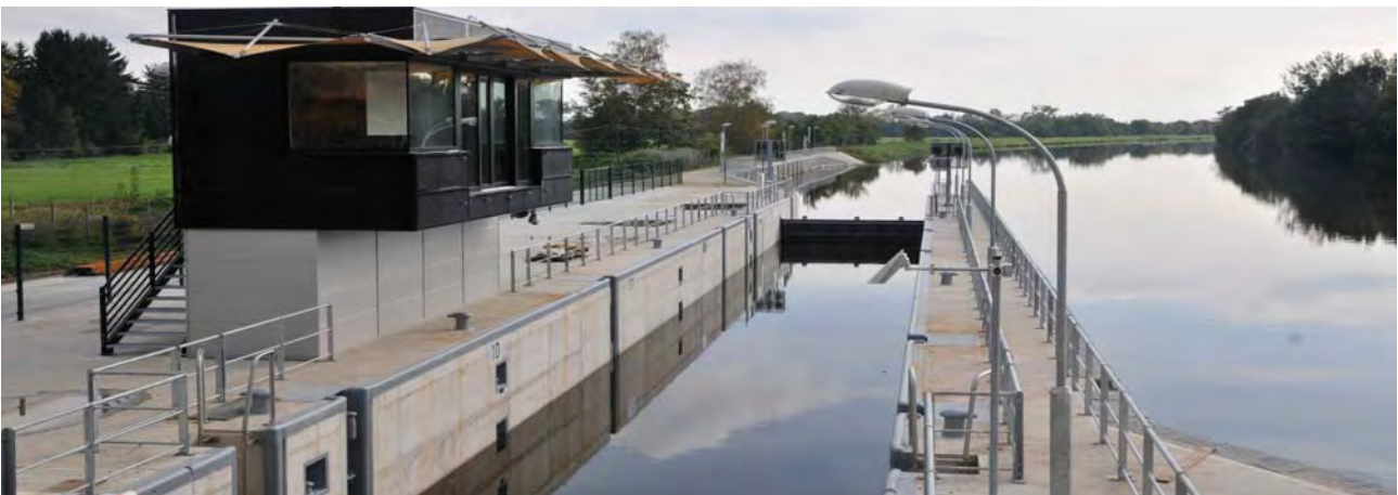
Během akce Vltava Open 2013 si budou moci návštěvníci prohlédnout i nedávno dokončenou plavební komoru Hluboká nad Vltavou
