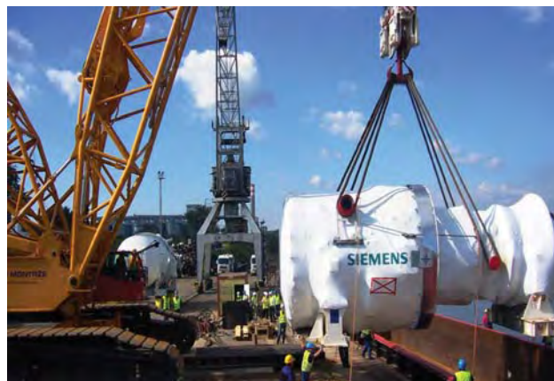
Parní turbína pro elektrárnu v Počeradech byla s hmotností 320 tun nejtěžším přeloženým zbožím historie přístavu Lovosice
