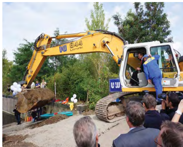
Slavnostní zahájení výstavby propojky mezi Karl-Heine-Kanal a přístavem Lindenauer Hafen
