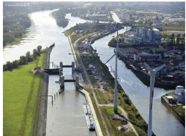
Nová plavební komora Niedrigwasserschleuse Magdeburg
