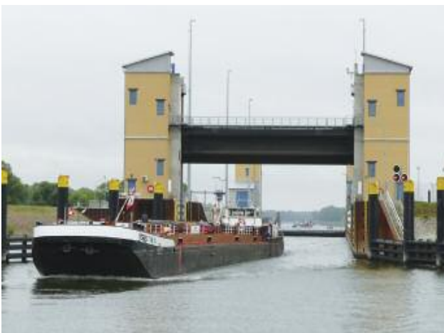
Nová plavební komora Niedrigwasserschleuse Magdeburg oddělující nákladní přístav od řeky Labe
