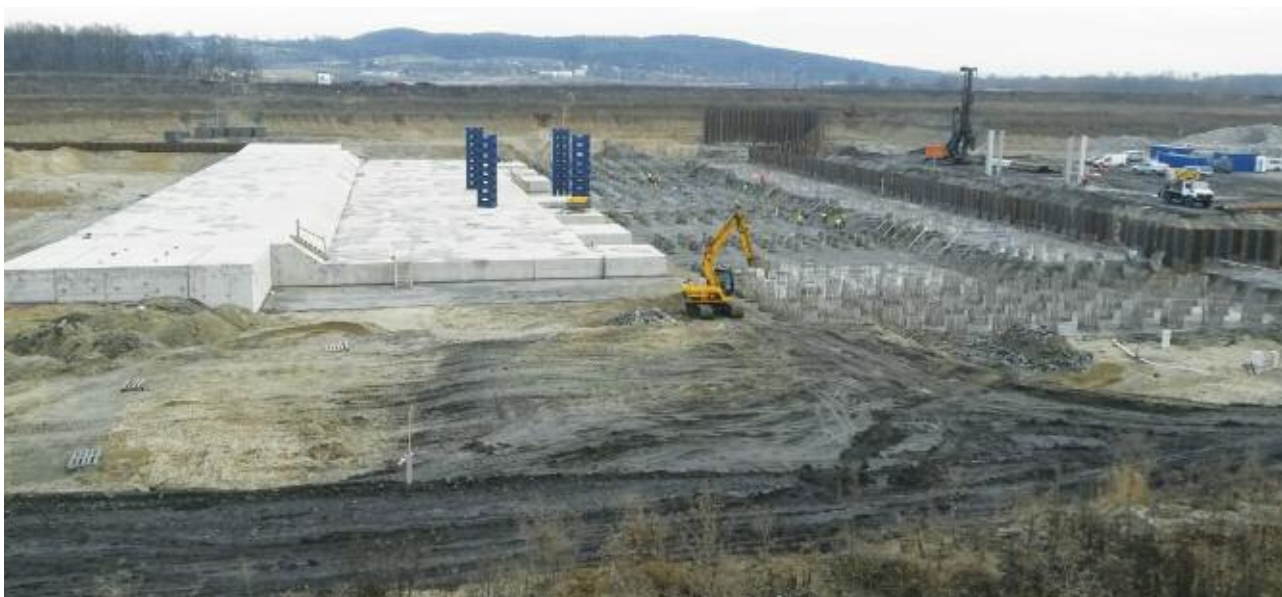
Výstavba vypouštěcího objektu poldru Raciborz Dolny s provizorním proplavovacím zařízením (modré dalby)
