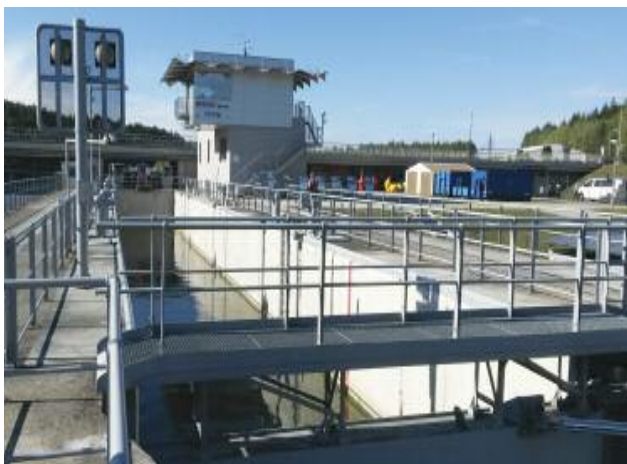
Exkurze na plavební komoru na přehradě Hněvkovice
