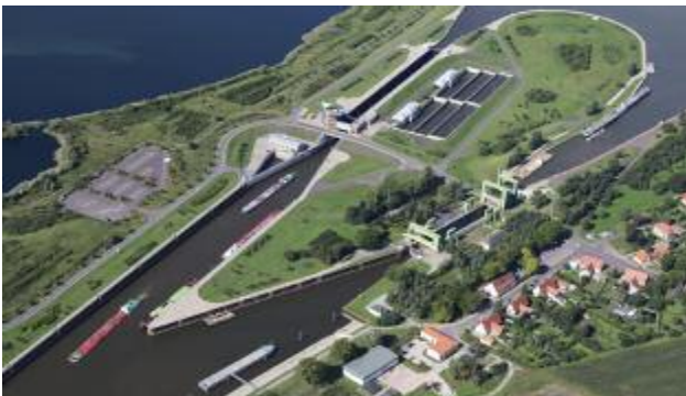
Letecký pohled na zdvihadlo a novou plavební komoru Rothensee. @Luftbildverlag-Peine.de
