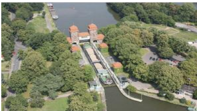
Plavební komora v Mindenu a výstavba nové PK
