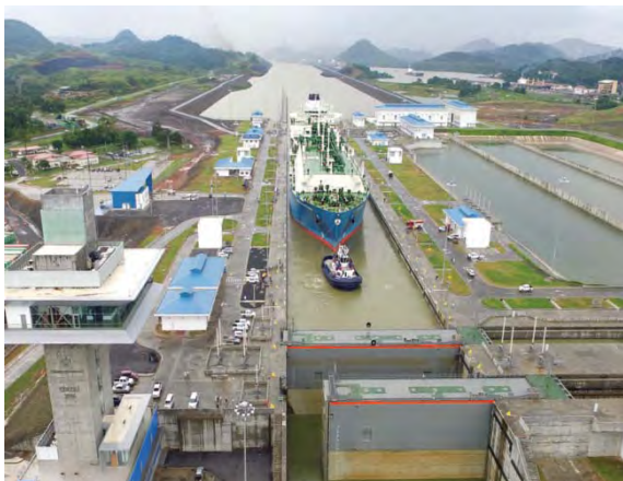
LNG tankery v plavební komoře Cocoli
