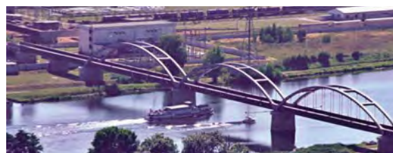
Celkový pohled na zmodernizovaný most
