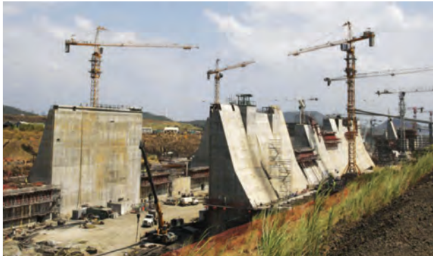
Výstavba nových plavebních komor
