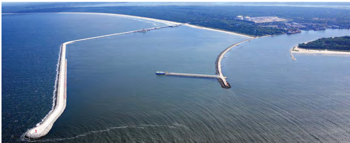
Celkový pohled na nový LNG terminál ve Svinoústí
