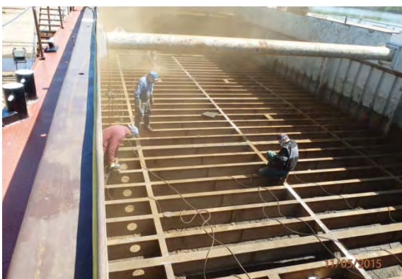
Výměna obšívky Silja 2 v loděnici Chvaletice
