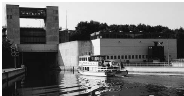
Obr. 1: Přečerpávací stanice na plavebním stupni Berching průplavu Mohan - Dunaj
