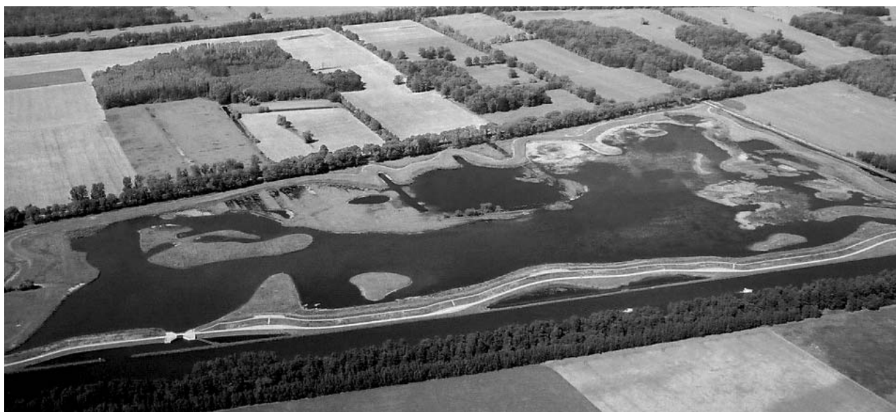
Obr. 2: Pohled na úsek modernizovaného Středozevního průplavu u obce Mannhausen v Německu a na rozsáhlý vlhký biotop, která byl v rámci modernizace zřízen. Vlastní průplav, jehož parametry po modernizaci odpovídají plánovaným parametrům vodního koridoru D-O-L a zasloužil by si proto podle některých kritiků označení „gigantický“ či „obří“ kanál (fantazii se meze nekladou) je vidět v popředí – je však pohříchu skryt za pobřežní vegetací.
