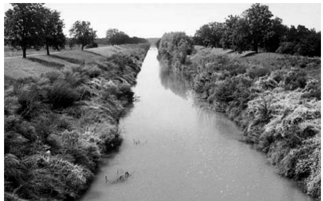
Obr. 2: 22 % trasy vodního koridoru probíhá koryty již dřívě – a často „technokraticky“ – upravených toků. K úsekům tohoto charakteru patří i odlehčovací rameno řeky Moravy, obcházející město Uherský Ostroh a Veselí nad Moravou. Naplní se jen za povodní, jinak je pokryto pouze jeho dno bahnitou stagnující vodou. Jeho vegetační doprovod je buď nevhodný (zanedbané ovocné stromy) nebo žádný. Dá se hovořit o romantické, turisticky atraktivní krajině? V současnosti sotva, po realizaci vodního koridoru podle projektu, respektujícím krajinařské zásady, však jistě.
