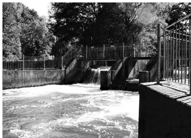
Obr. 3: Obnovený historický jez na říčce Kleine Roth, jejíž tok byl „odříznut“ trasou průplavu Mohan – Dunaj. Snímek byl pořízen v období extrémního sucha, při kterém by říčka bez dotace vody z průplavu prakticky vyschla.
