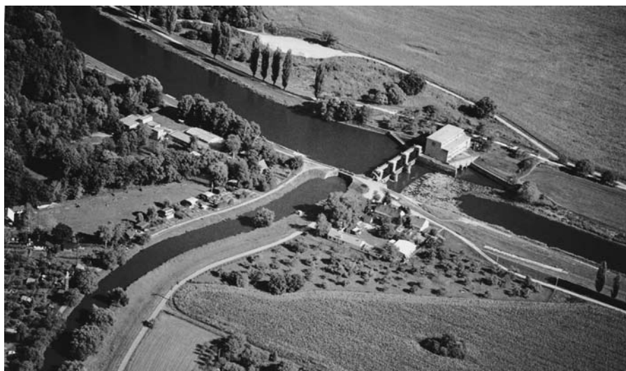
Obr. 2: Kritický profil na řece Moravě v Hodoníně. V období nízkých průtoků odtéká veškerá voda náhonem k tepelné elektrárně.
