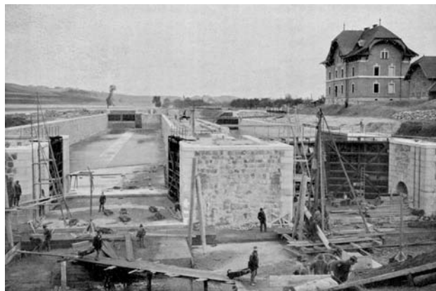
Zatímco výstavba labských stupňů pokračovala rychlých tempem - plavební komory Dolní Bečkovice (1905) ...
