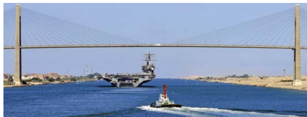
Silniční Most Suezského průplavu
