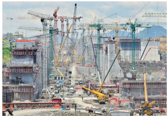
Výstavba nových plavebních komora na Panamském průplavu
