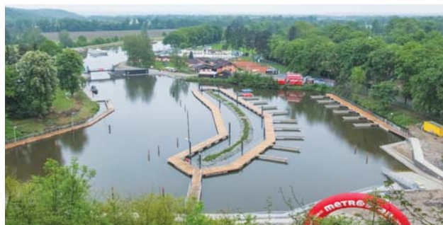
Celkový pohled na přístav Hluboká nad Vltavou
