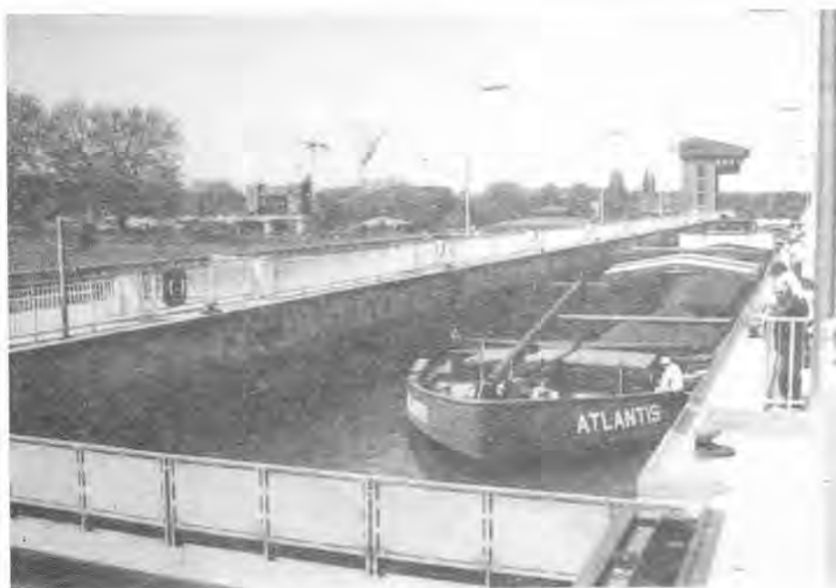
10: ... které zdolají při jediném proplavení lodě či soupravy o celkové hmotnosti 4000 tun.
