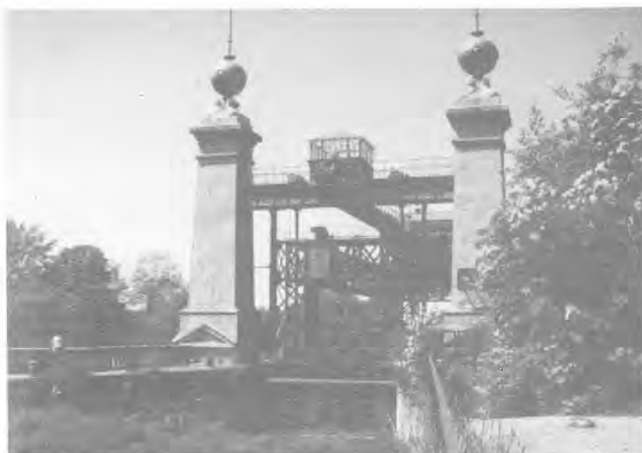
8: Staré plovákové zdvihadlo v Henrichenburgu pro lodě o nosnosti 600 tun je prvním svého druhu na světě a spravuje se proto jako cenná technická památka...
