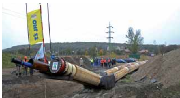
Pod řekou byla realizována nová vodovodní šyba
