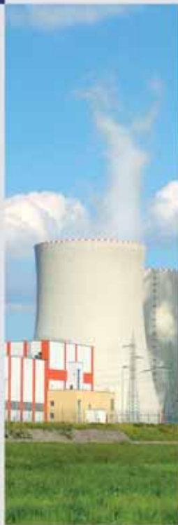
Mezisklad vyhořelého jaderného paliva Temelín, Česká republika
