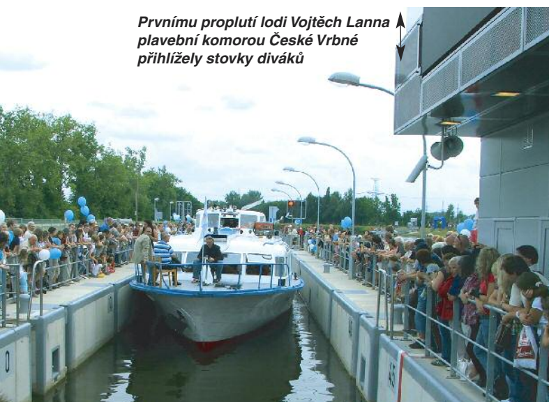
Nad jezem Hluboká nad Vltavou. Vlevo se tyčí nad řekou zámek, vpravo se buduje plavební komora
