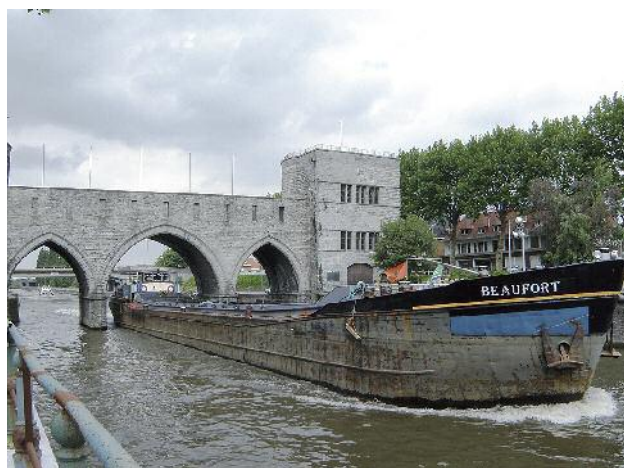
Jedním z důležitých projektů je umožnit proplouvání městem Tournai větším lodím. Největší překážkou pro plavbu je zde především most Pont des trous, jehož oblouky se budou muset rozšířit.
