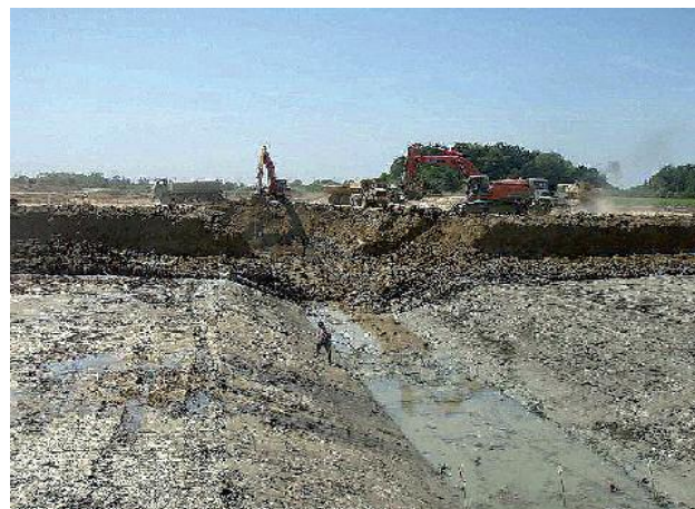
V současné době probíhá 1. fáze výstavby víceúčelového průplavu Dunaj-Sáva
