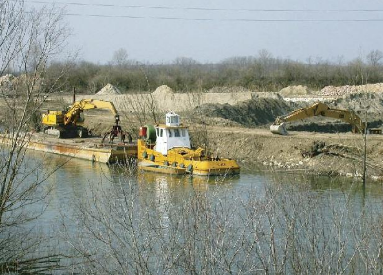
Po roce 2000 konečně začaly dokončovací práce na vodní cestě Mantova-Jadran
