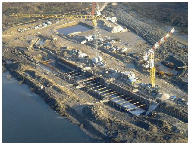
Výstavba plavební komory Valdaro na vodní cestě Mantova - Jadran (2009-2012)
