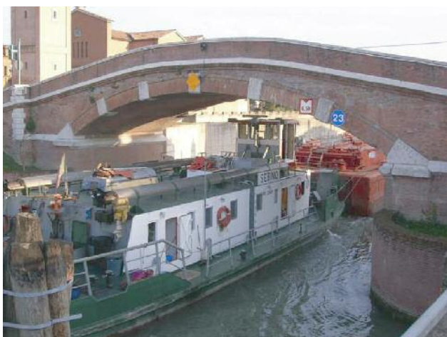
Některé mosty omezují podjezdnou výškou možnosti přeprav, především kontejnerů. Na obr. most v obci Zelo
