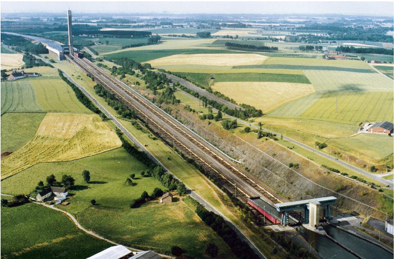
Šikmé lodní zdvihadlo Ronquières na vodní cestě Brusel-Charleroi v Belgii pro lodě o nosnosti 1500 tun bylo dokončeno v roce 1968 a nezapře svůj vzor v lodní železnici „Universell“ z přerovské soutěže, která proběhla o více než půlstoletí dříve
