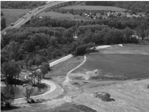
Opravená hráz - Dušníky
