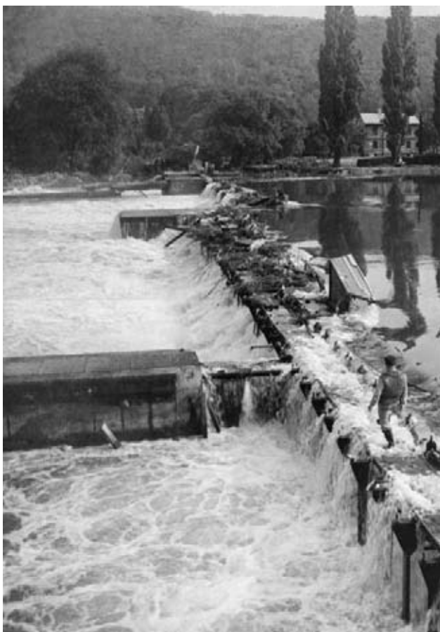
Slupicový jez v Libčicích po průchodu velké vody
