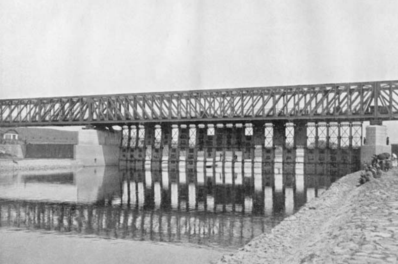
Stavění stavidlového jezu v Miřovicích.
