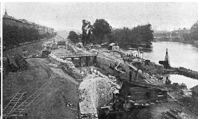
Stavba uzavírky proti povodni 7. srpna 1913
