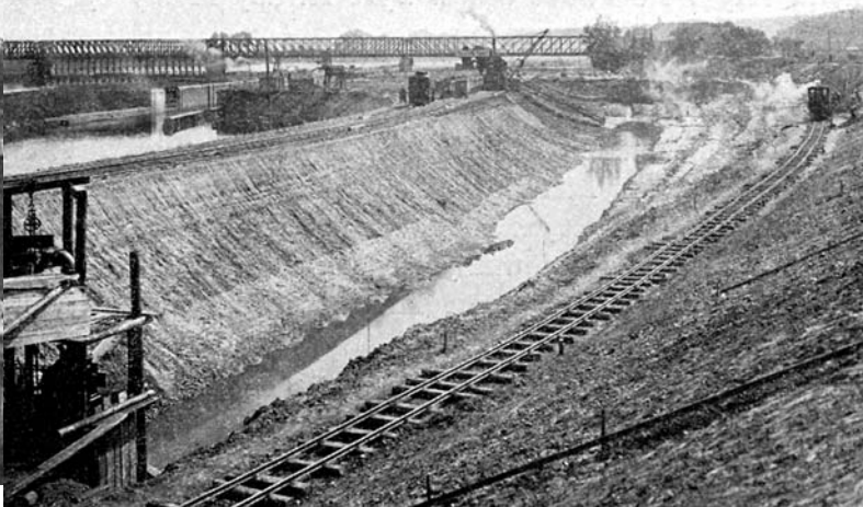
Bagrování pro odpad vodní elektrárny v Miřejovicích 8. června 1923
