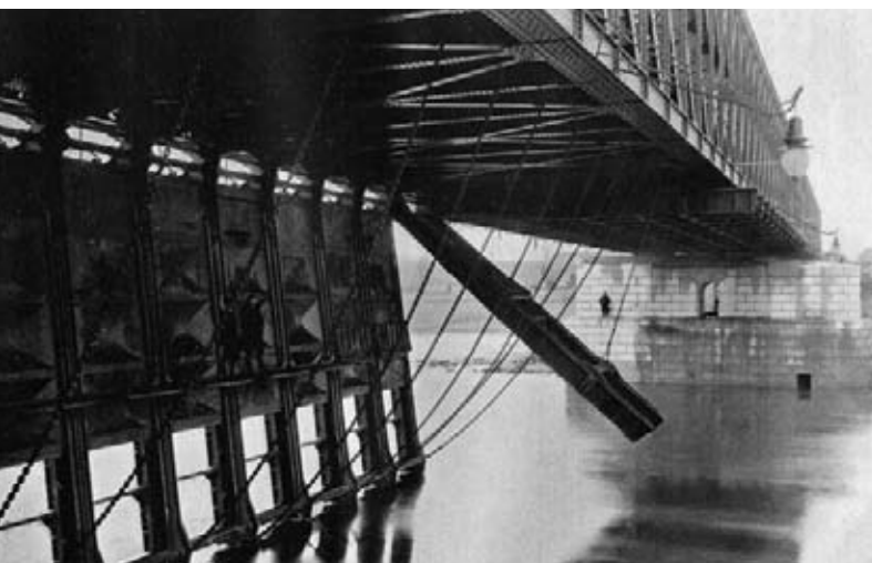
Vytahování slupic a stavidel pod most v Miřovicích 19. listopadu 1903
