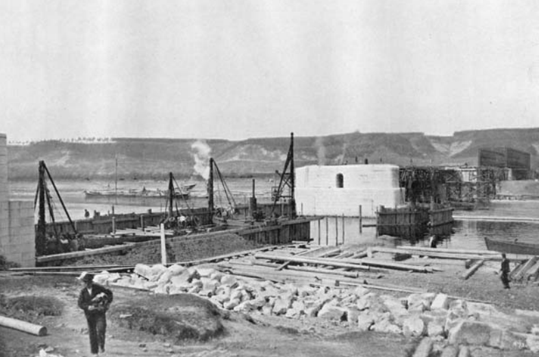
Zřízení jímky pro pravostranné pole hradlového jezu při zdýmadle Miřovickém. (29. dubna 1903
