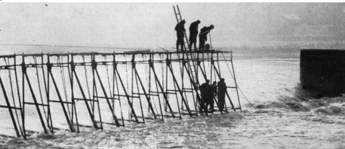
Sklápění jezové konstrukce
