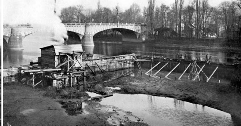
Jímka uzavírající stavební jámu pro plavební komory u Židovského ostrova v Praze 13. prosince 1911
