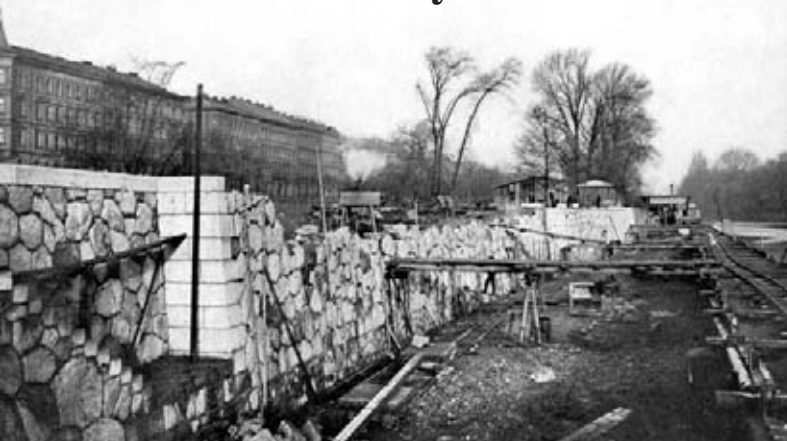
Stavba pobřežní zdi podél židovského ostrova v Praze 13. prosince 1911
