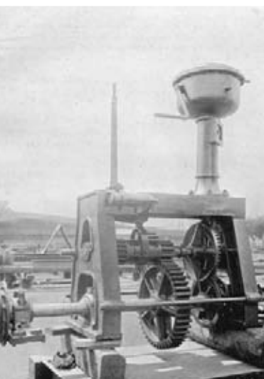
Pohybový mechanismus segmentového stavidla v Hoříně
