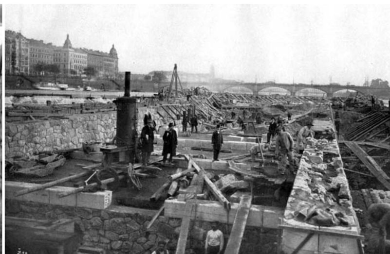
Stavba nové vorové propusti v Šitkovském jezu v Praze
