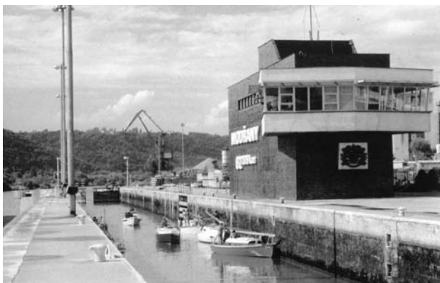
Plavební komora v Praze - Modřanech
