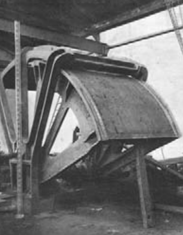
Montování segmentového stavidla pro hořínské obtoky v továrně 4. listopadu 1903
