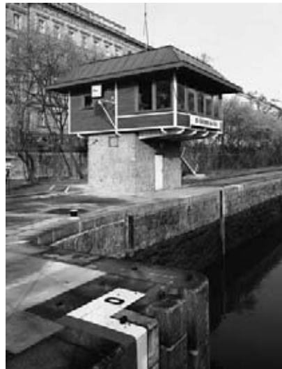
Plavební komora Praha-Smíchov, velín
