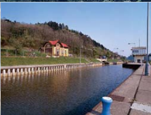
Plavební komory Dolánky na Vltavě
