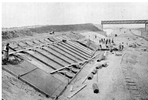
Betonování svahů laterálního kanálu u Vrbence.
