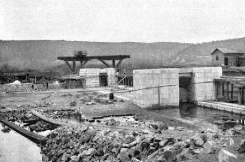
Stavba hradlového jezu u Troje dne 2. listopadu 1899
