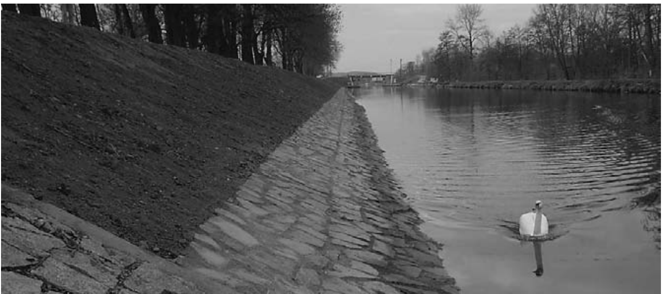
Vraňany - opravená hráz kanálu
