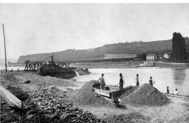
Stav stavebních prací při jezu a při vorové propusti zdýmadla Libšického dne 28. července 1899. Pohled z pravého břehu.
