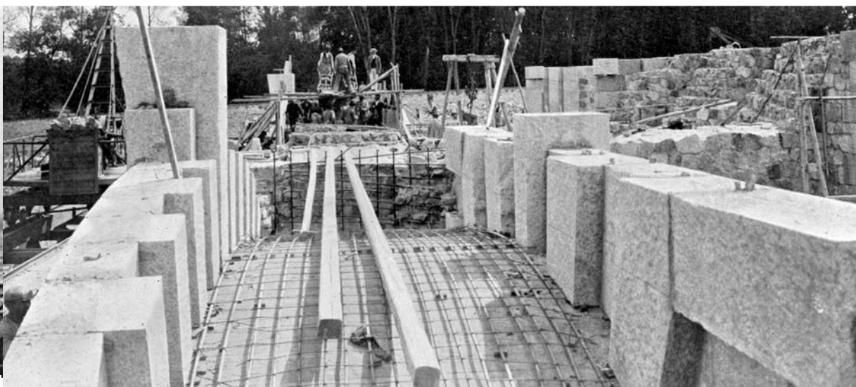
Betonování klenutí přes dolní ohlaví plavidel u Hořína
