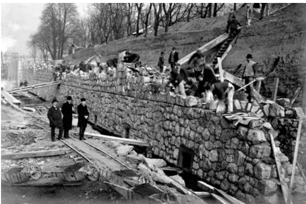
Plavební komory Smíchov – stavba pravé zdi (stav v prosinci 1912).
