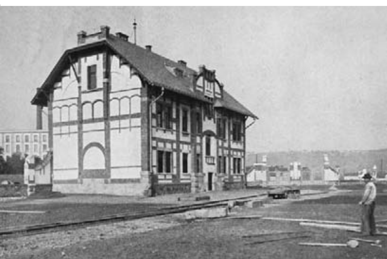
Obytné stavení pro železniční zřízence a vjezd do přístavního nádraží.
