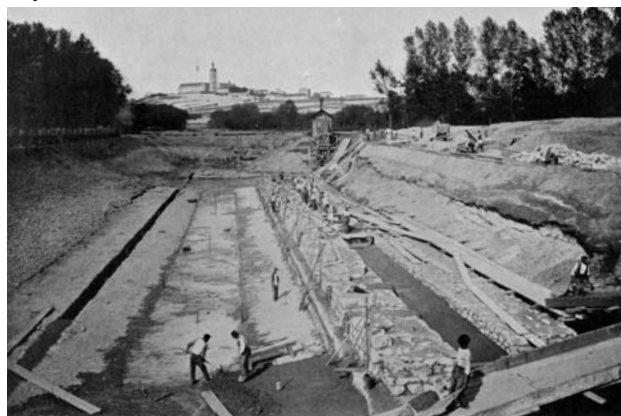
Stav prací při komorovém plavidle v Hoříně dne 28. srpna 1902.
