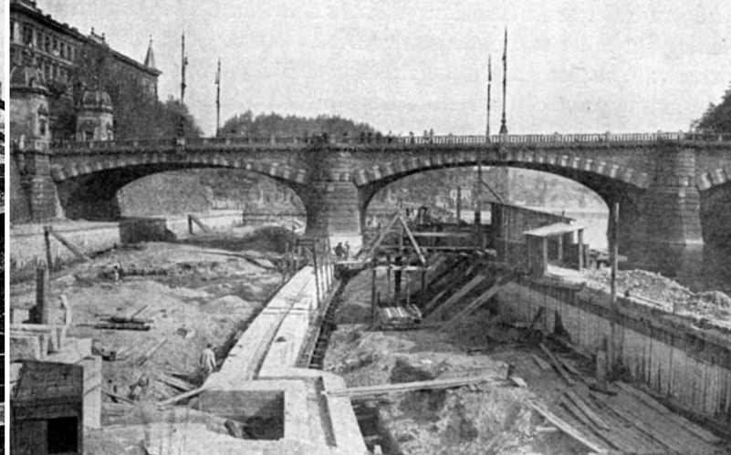
Zdymadlo u Slovanského ostrova. 17. května 1918. Základy dělicí zdi pod vlakovým plavidlem
