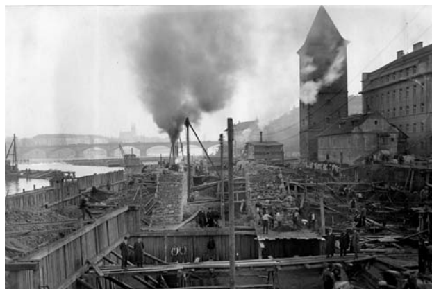
Plavební komory Smíchov – práce na horním plavebním kanálu.
