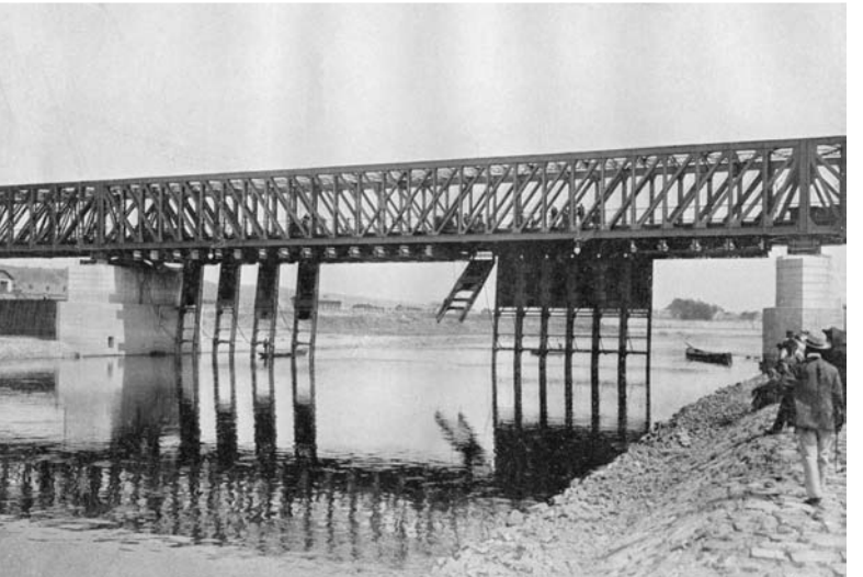
Stavění stavidlového jezu v Miřovicích.
