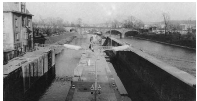
Membránová vzpěrná vrata v dolním ohlaví PK Štvanice
