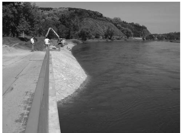
Libčice - oprava břehu pod MVE
