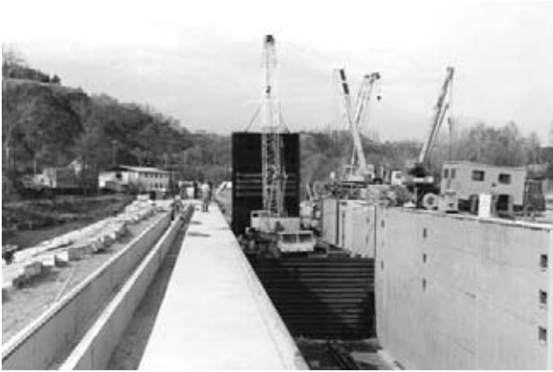
Plavební komora Praha-Podbaba, osazování vrat
