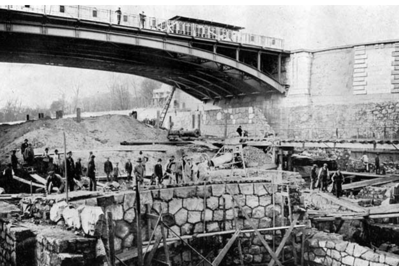
Stavba horního ohlaví plavidel u Štvanice v Praze dne 28. října 1909
