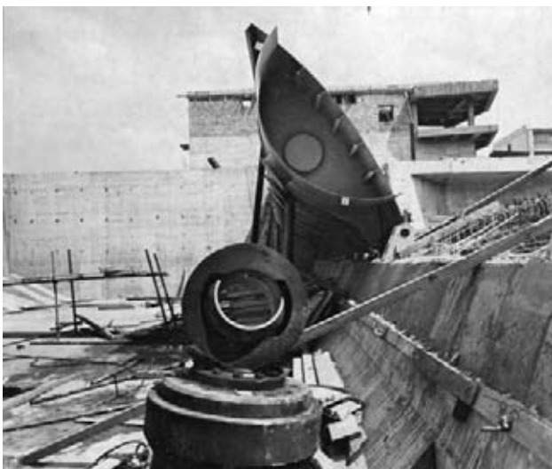
Jezová klapka podpíraná dvojicí hydraulických válců na Vltavě v Praze - Troji
