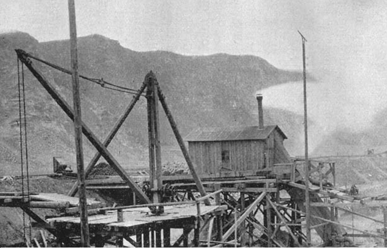
Stav stavebních prací ve vlakovém plavidlu zdýmadla č. II. u Klecan dne 22. prosince 1897 (pohled z dolního ohlaví)
