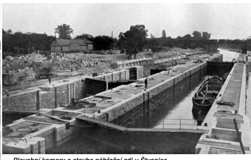
Plavební komory a stavba nábrežní zdi u Štvanice dne 17. června 1911
