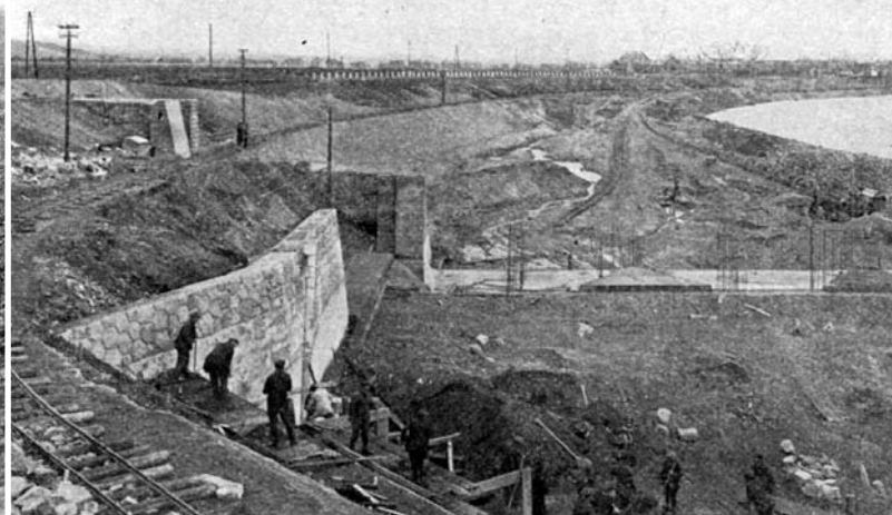
Stavba vodní elektrárny v Miřejovicích 15. července 1924
