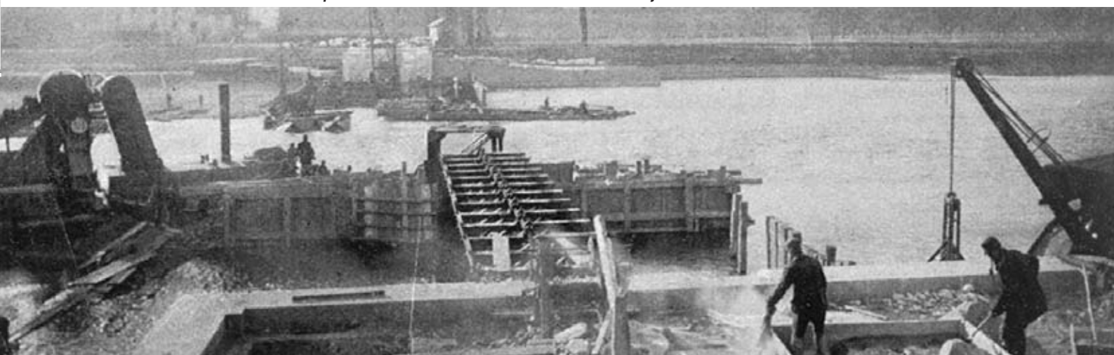
Stav prací na jezu Libšickém dne 15. listopadu 1899. Pohled s pravého břehu.
