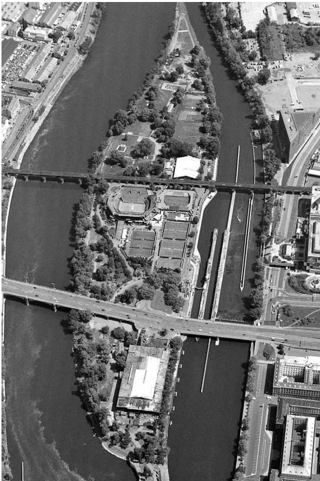
Plavební komory v Praze na Štvanici v roce 2004 (pohled po vodě)
