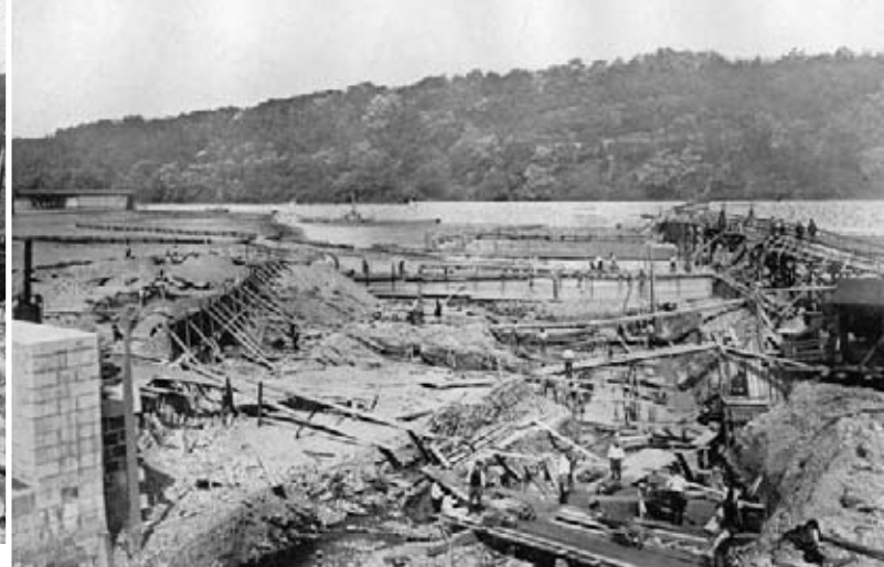
Stavba nového jezu helmovského v Praze dne 8. června 1909
