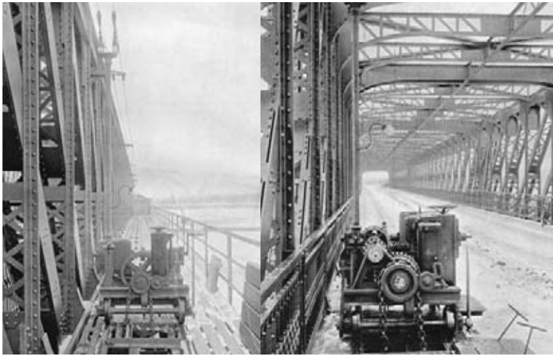
Elektrický jeřáb ku zdvihání stavidel v Miřovicích
