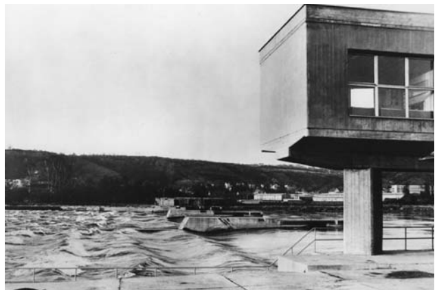
Jezová klapka podpíraná dvojicí hydraulických válců na Vltavě v Praze - Troji
