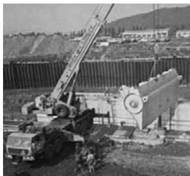
Osazování pokloповých vrat prof. Čábelky do horního ohlaví plavební komory v Praze - Modřanech
