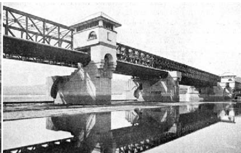
Válcové jezy v nejvyšší poloze pro vodní elektrárnu v Miřejovicích 15. dubna 1926
