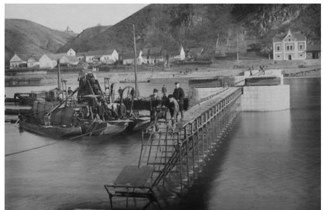
Stavba hradlového jezu v Klecanech.
