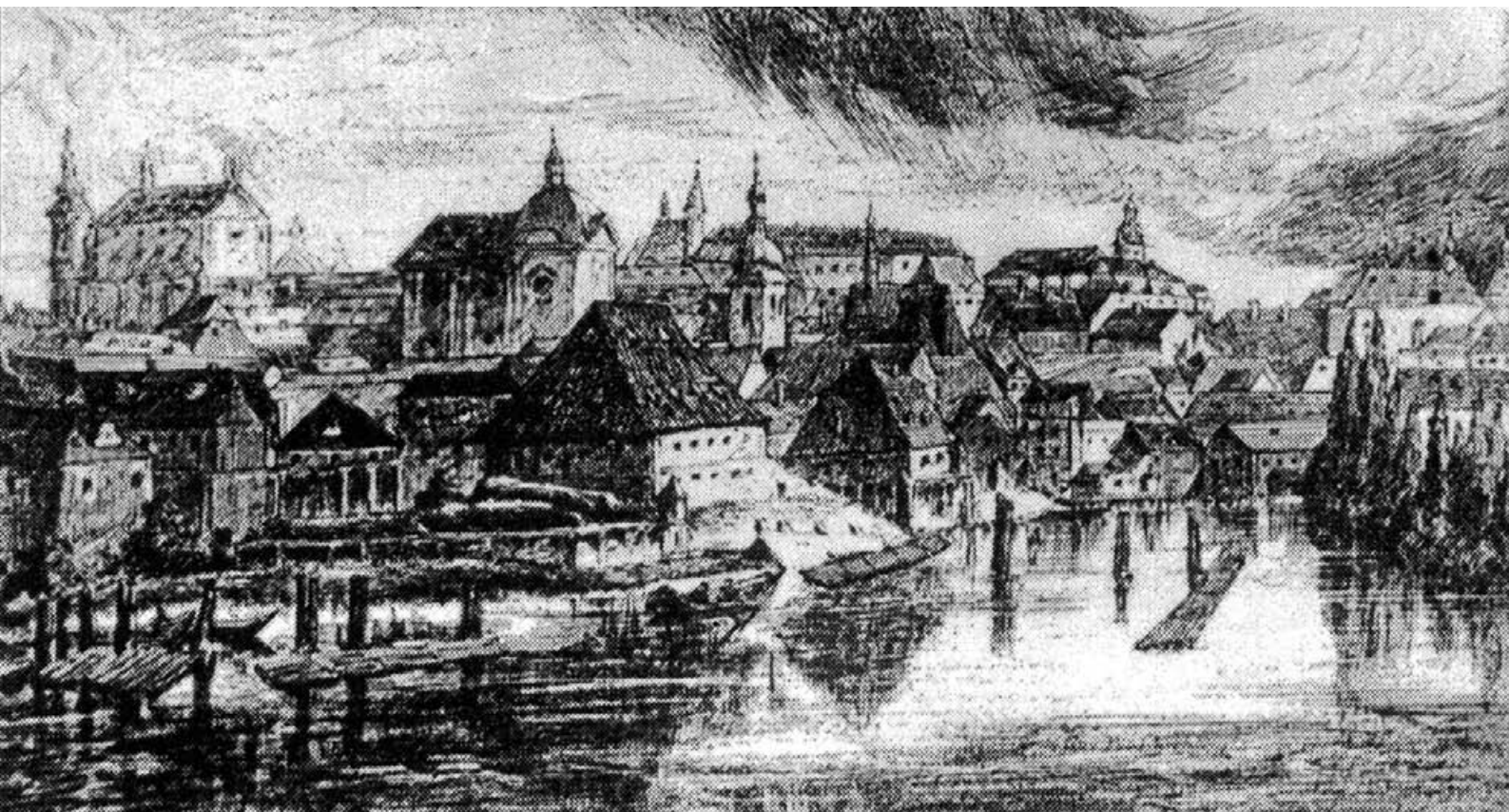
První císařská solnice v Praze, postavená roku 1562 na vltavském břehu
