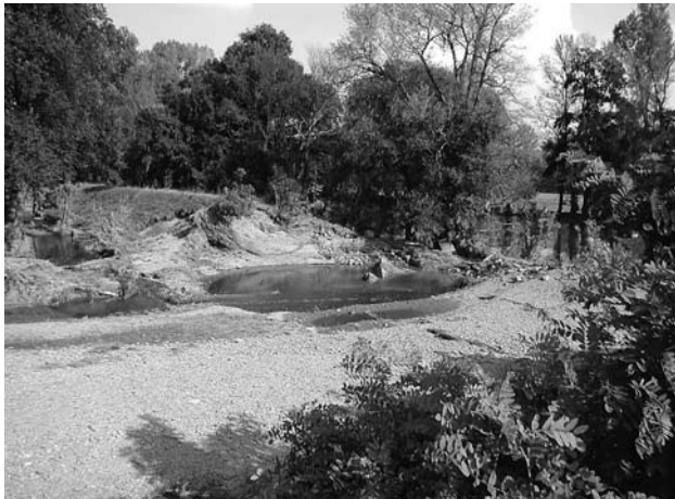
Vrbno - destrukce hráze
