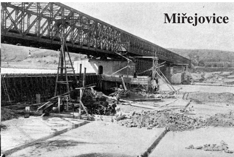
Stavba válcového jezu v Miřejovicích 28. srpna 1923
