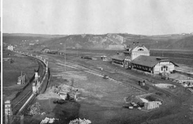
Stavba ohradní zdi nádraží v holešovickém přístavě (vpravo hotové celní skladiště).
