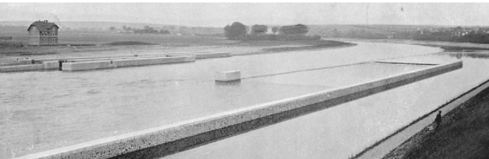
Sklopený hradlový jez u Vraňan
