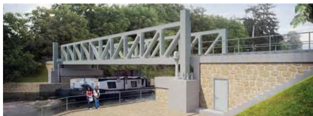
Nový pohyblivý železniční most umožní po zdvižení o 3,1 metru podjezdovou výšku až na 7 m
