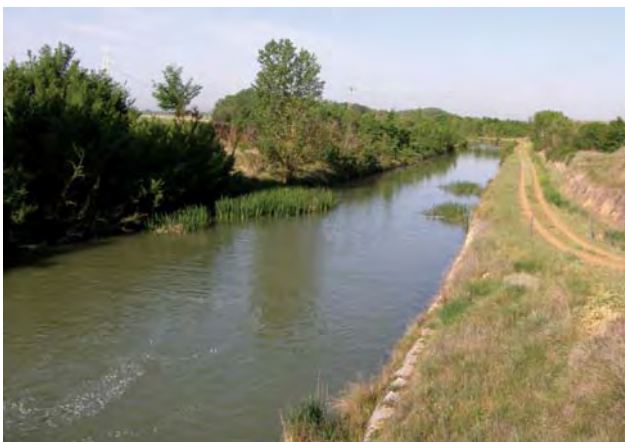
Větev Campos – současný stav kanálu
