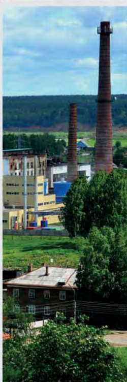
Paroplynová elektrárna Krasavino, Ruská federace
