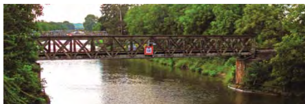
Současný železniční most poskytuje podjezdovou výšku pouze 4,80 m
