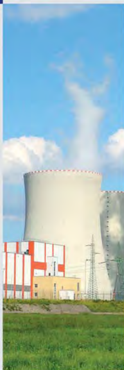
Mezisklad vyhořelého jaderného paliva Temelín, Česká republika
