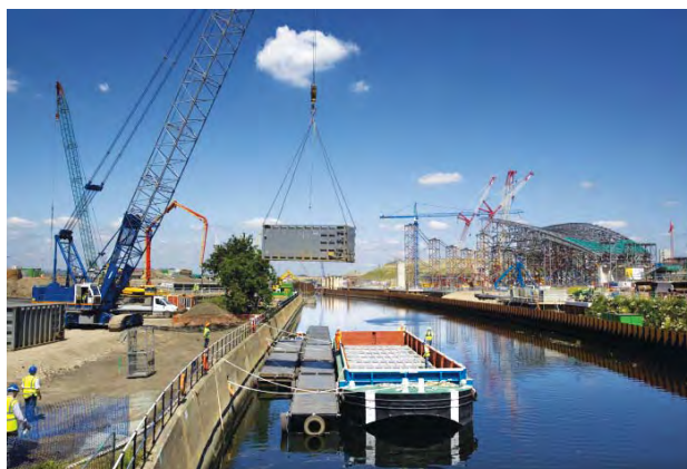
350tunové čluny odvážely stavební sutě a přivážely stavební materiály pro stavbu olympijské areálu
