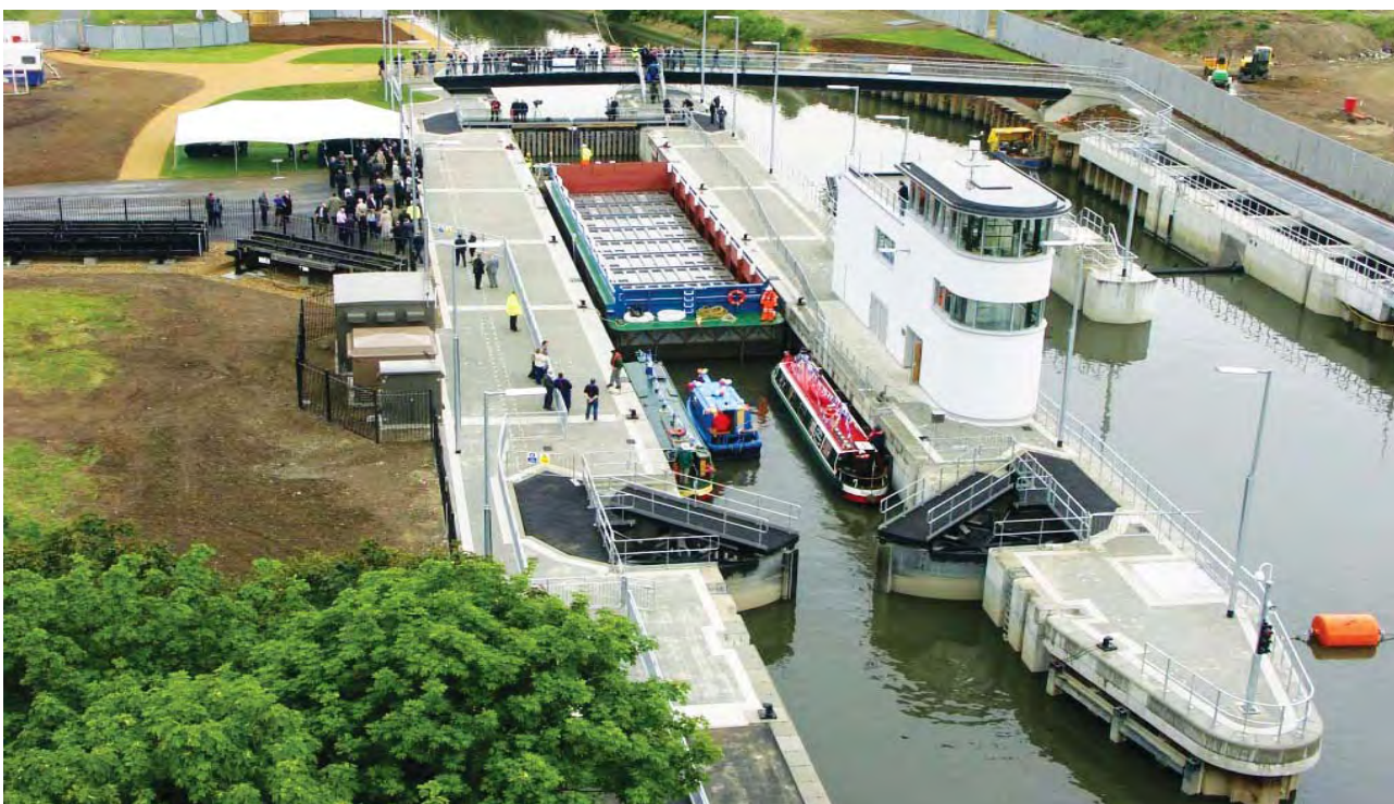
Nová plavební komora Three Mills Lock umožnila nákladní vodní dopravu na stavbu olympijského areálu
