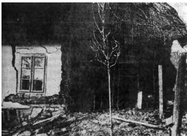
Typická chalupa z obcí v povodí toku Moravy pobořená povodní roku 1930. Z povodně v Kvasicích 18 km od Zlína a 6 km od pobočných závodů firmy Baťa na břehu Moravy
