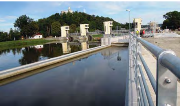
Plavební komora Hluboká nad Vltavou je před dokončením
