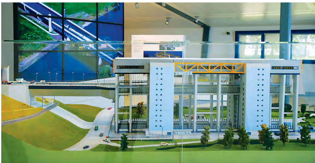
... nebo v současné době stavěného svislého lodního zdvihadla Niederfinow (Německo)
