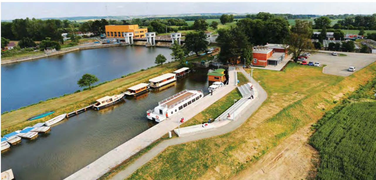
Celkový pohled na nové přístaviště a turistické centrum ve Spytihněvi
