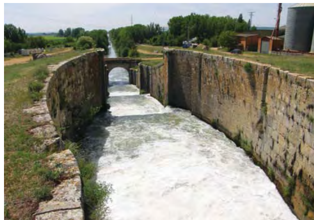
Zdymadlové schodiště El Serrón
