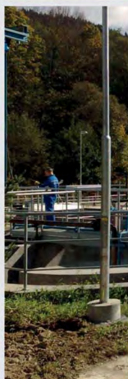
Čistička odpadních vod Valašské Klobouky, Česká republika
