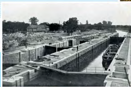
Stavba plavební komory Štvanice
