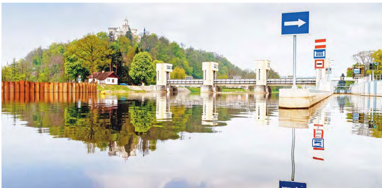
Pohled na dokončenou plavební komoru Hluboká nad Vltavou (1. května 2013)
