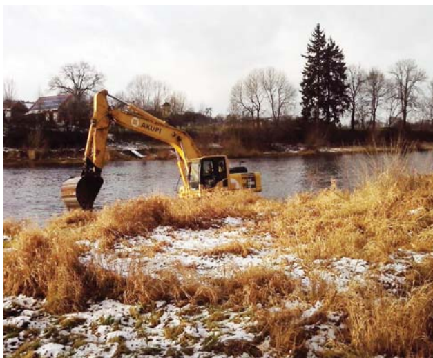
Stavba nové plavební komory u jezu Hněvkovice - kopání sond
