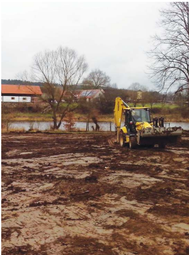
Stavba nové plavební komory u jezu Hněvkovice
