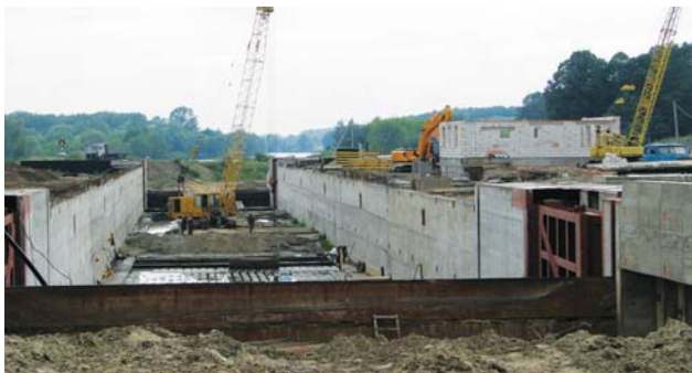
Výstavba nové plavební komory třídy Va na vodním uzlu č. 8 Zaluže na průplavu Dněpr-Bug v roce 2014
