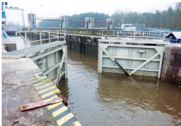
Plavební komora Velký Osek je po rekonstrukci opět v provozu
