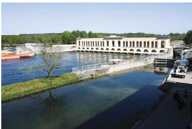
Plavební komora Panperduto je po rekonstrukci opět v provozu
