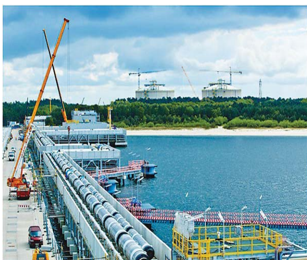
Výstavba terminálu LNG
