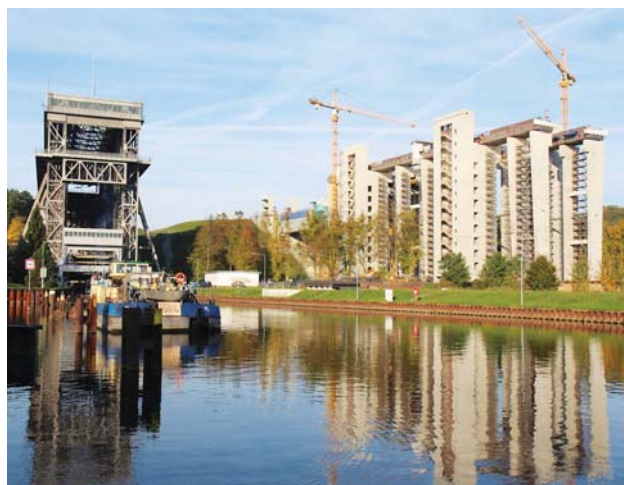
Výstavba nového lodního výtahu Niederfinow na německém průplavu Odra-Havola
