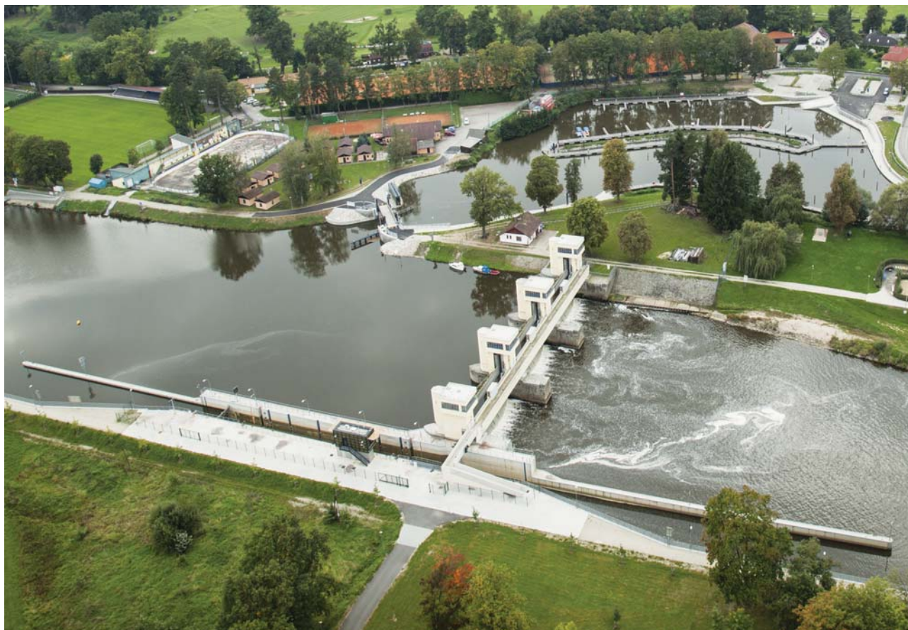
Jez, plavební komora a sportovní přístav v Hluboké nad Vltavou
