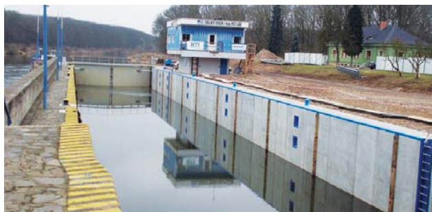
Modernizace plavební komory Velký Osek
