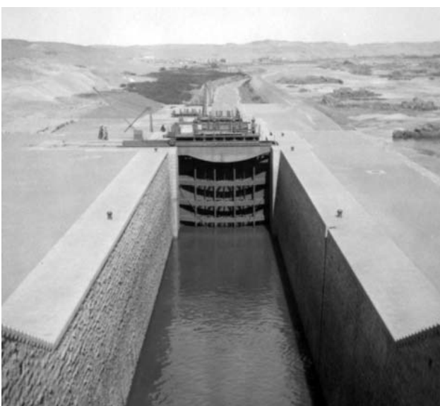
Dokončování stupnice plavebních komor na Nízké Asuánské přehradě (1901-1902) - z časopisu Středolabského komitétu
