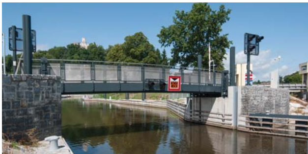
Zdvižná lávka u vjezdu do přístavu Hluboká nad Vltavou
