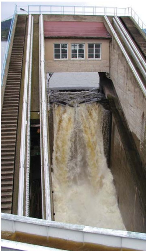
2002 - voda přetéká vzpěrná vrata v nedokončeném velkém lodním výtahu na Orlické přehradě
