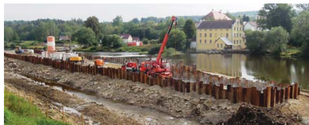
Práce na plavební komoře Hněvkovice
