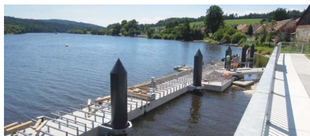
Stavební práce na přístavu Purkarec
