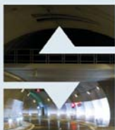
Tunelový komplex Blanka Projekt a koordinace
