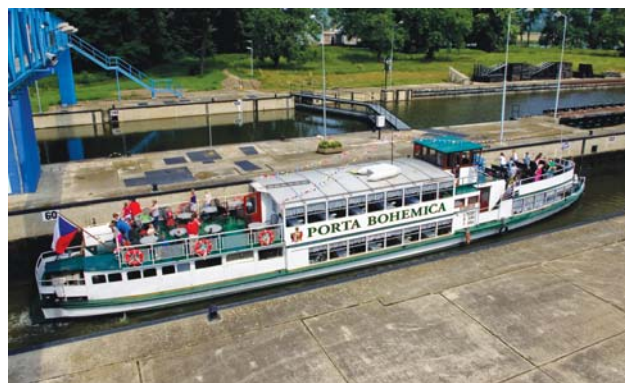
Plavební komory Lovosice
