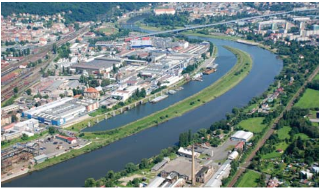
Děčín Rozbělesy – největší ochranný přístavní bazén při povodních a nízkých vodních stavech
