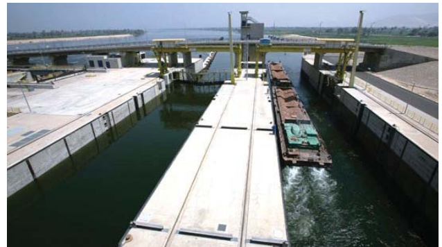
Plavební komory na novém jezu Naga Hammadi
