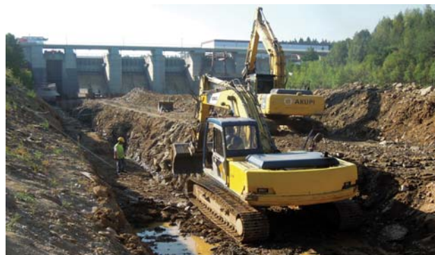
Dolní rejda VD Hněvkovice - práce na nábřežní zdi
