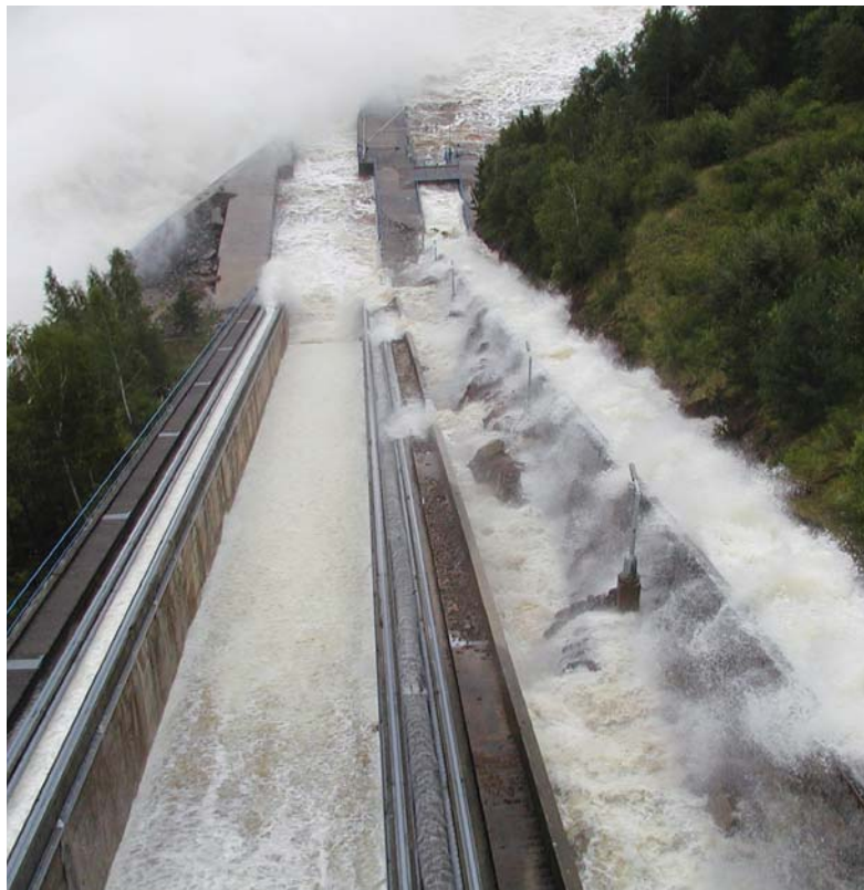
2002 - voda se valí po kolejových drahách malého a velkého lodního výtahu na Orlické přehradě
