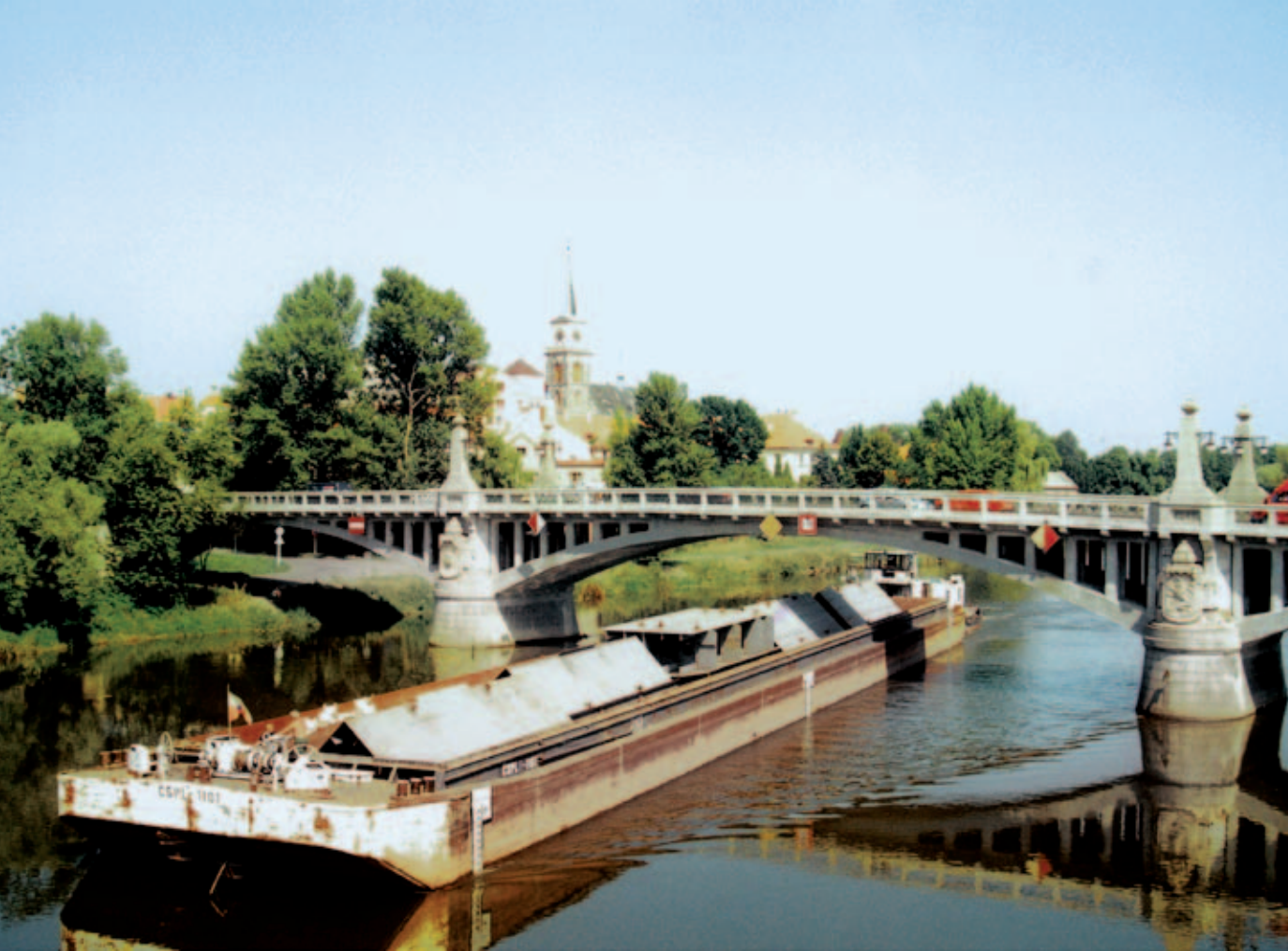
Historický most v Nymburku na středním Labi nabízí jen stísněné podmínky pro průjezd moderních plavidel. Výhledovým potřebám však vyhoví, byť za cenu jednosměrné plavby.
