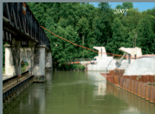
Výstavba nových klapkových jezů na řece Oise byla zahájena jezem Isle Adam (1. a 2. řádka) a pokračuje jezem Pontoise (3. řádka).
