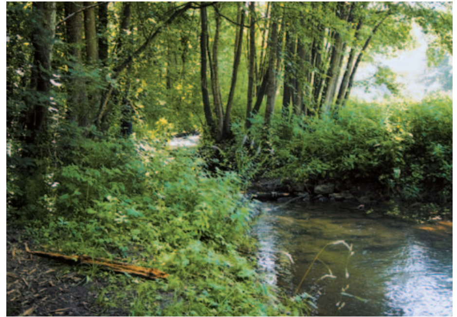
Rybí propust u jezu Eisenhammer byla vytvořena jako umělý biokoridor.
