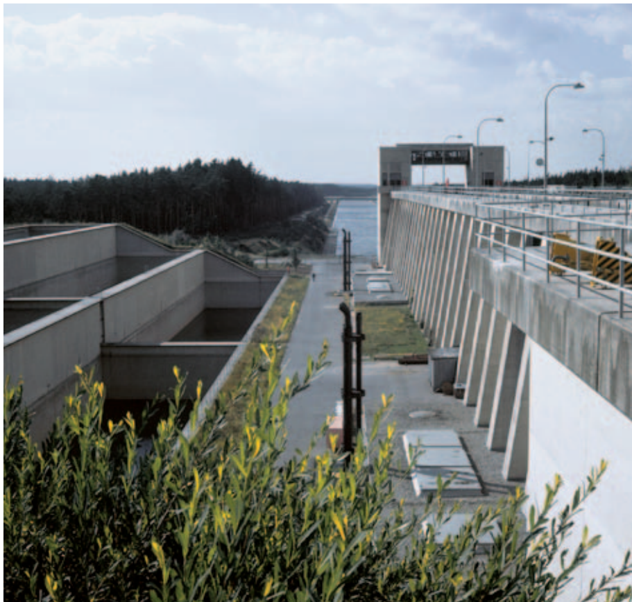
Plavební komora s úspornými nádržemi na průplavu Mohan–Dunaj.
