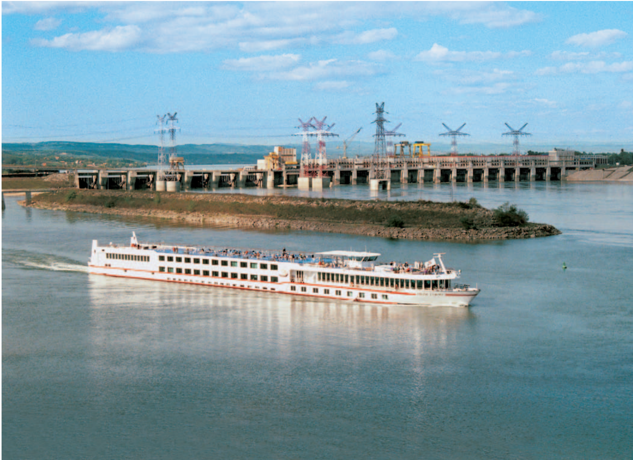
Vodní dílo Železná vrata II.
