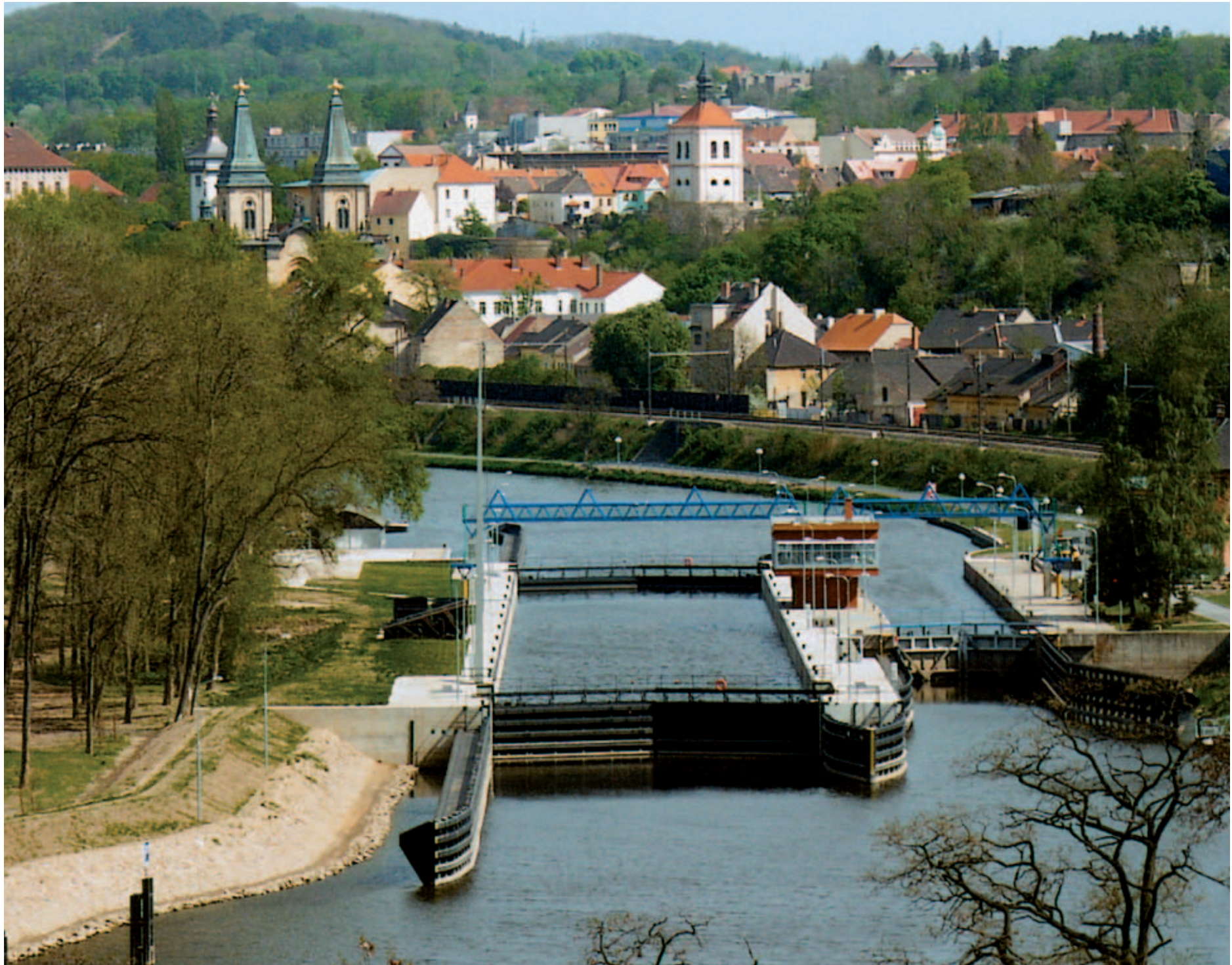
Modernizované plavební komory v Roudnici na Labi.
