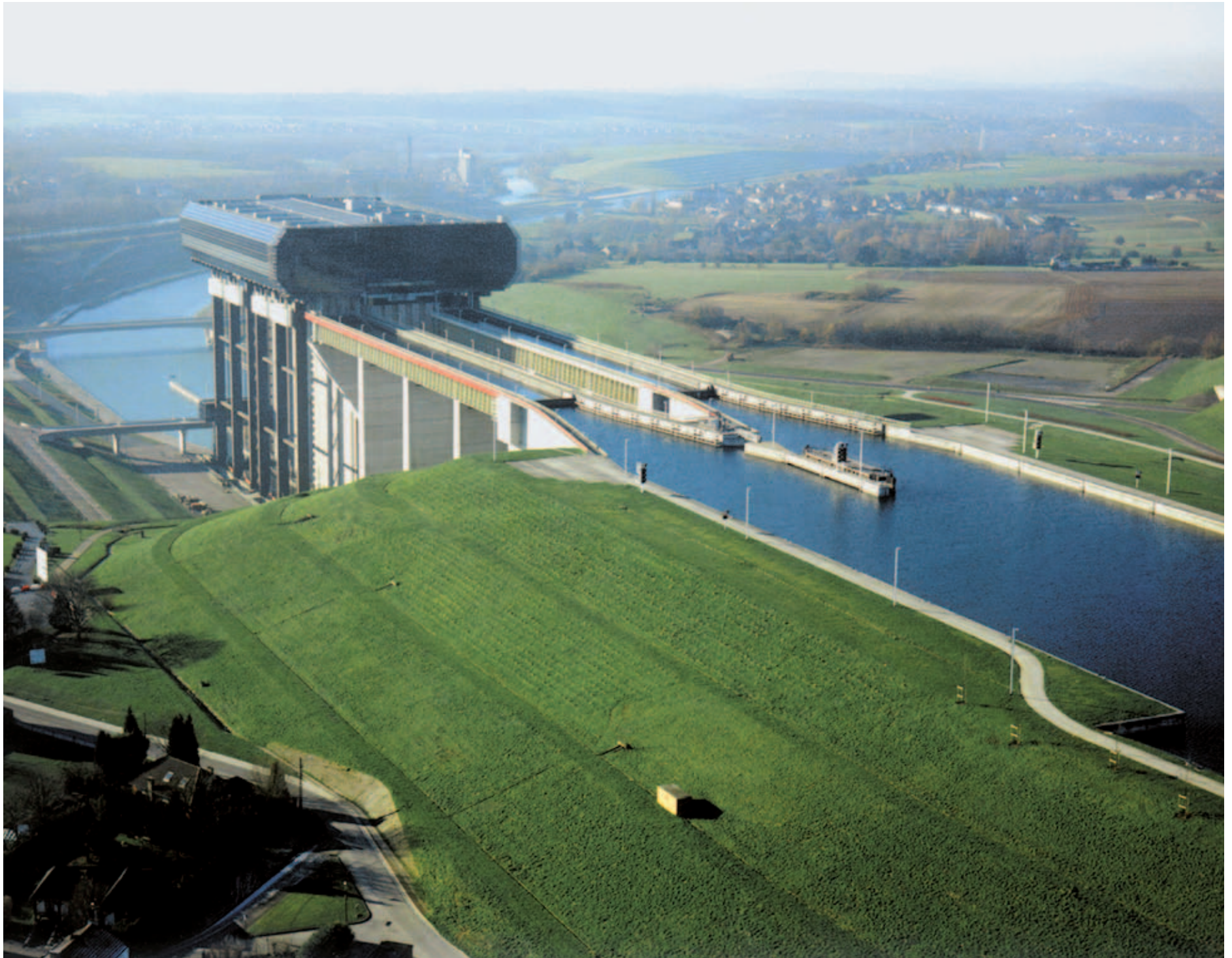
Pohled z horní vody na lodní zdvihadlo a horní akvadukt v belgickém Strépy.
