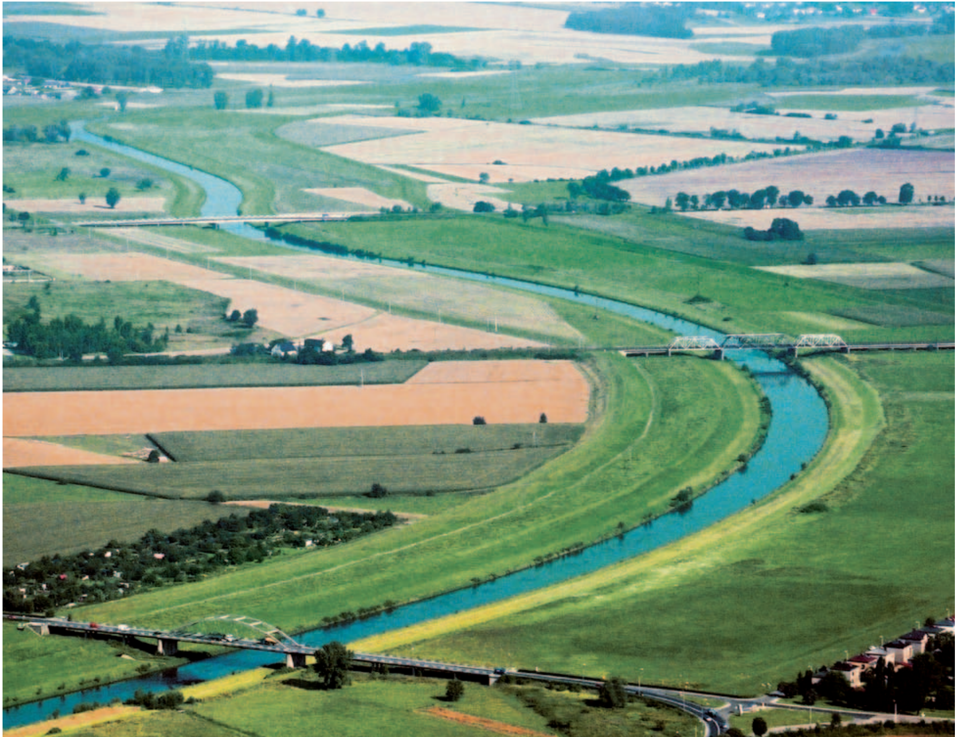
Odlehčovací rameno Odry obcházející město Racibórz. Jeho směrové vedení bylo přizpůsobeno požadavkům plavby, kterým v podstatě vyhovují i veškeré mosty.
