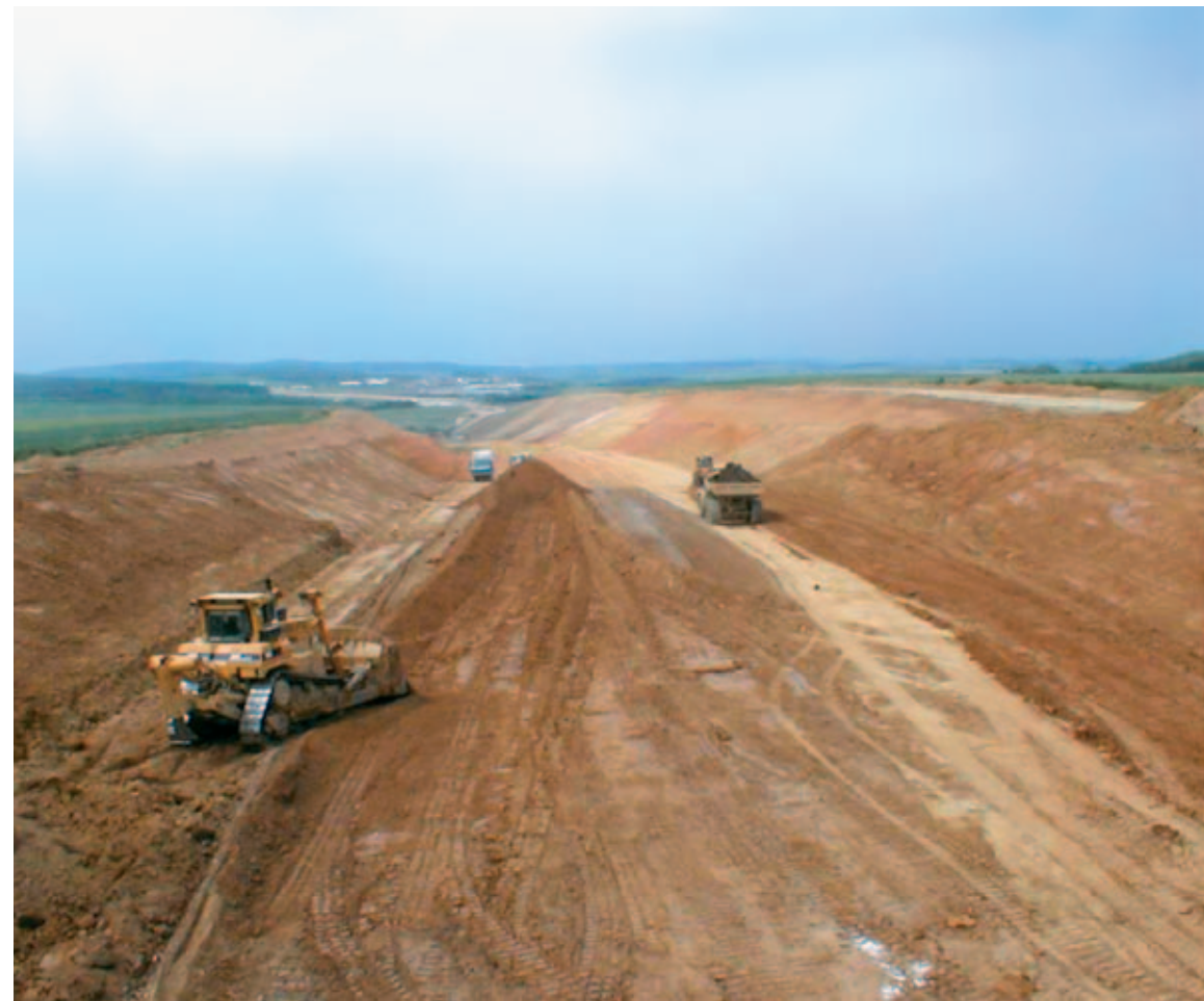
Zemní práce na zářezu dálnice D 5. Používaná technologie se stejně dobře hodí na výstavbu vodního koridoru D-O-E.
