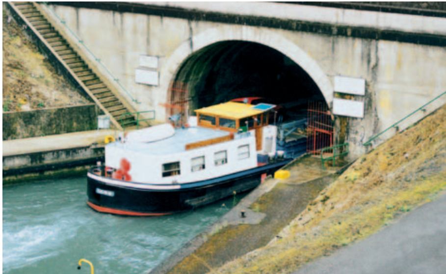
Severní portál průplavního tunelu Ruyaulcourt (Canal du Nord, Francie). Tunel je 4,35 km dlouhý a poskytuje šířku 6,38 m mezi bočními svodidly. Ve střední části je však 1,15 km dlouhá vyhybna, široká 12,3 m.
