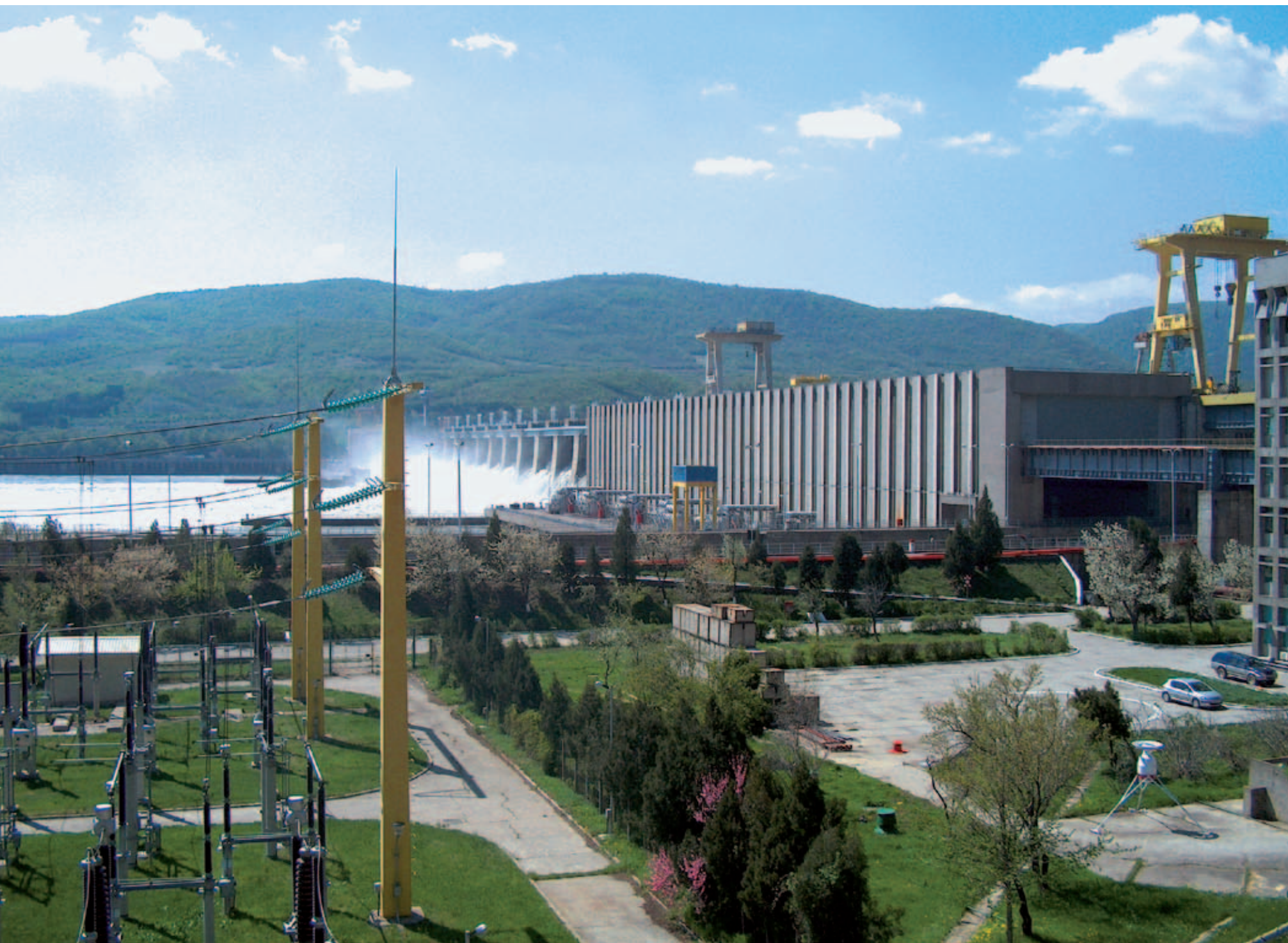
Vodní dílo Železná vrata I. Výkon hydrocentrály u tohoto díla odpovídá velké jaderné elektrárně.
