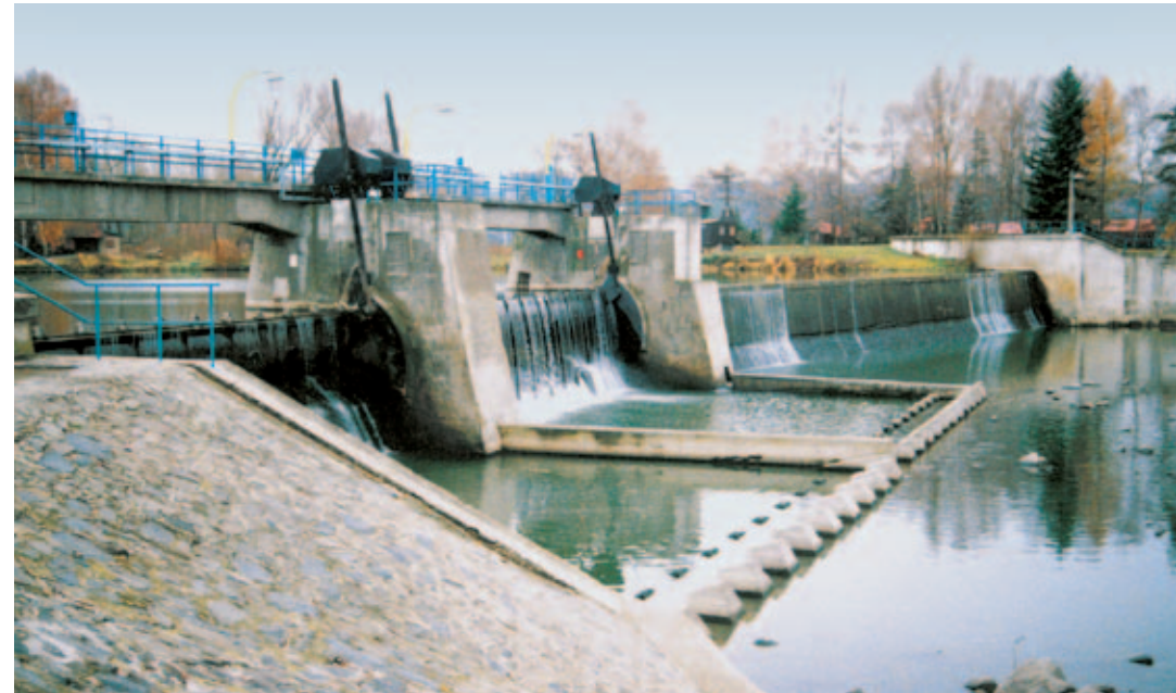
Jez v Oseku na Bečvě má pevnou část a dvě pole s klapkami. Jez usnadňuje vedení trasy vodního koridoru D-O-L v krátkém úseku řekou Bečvou.
