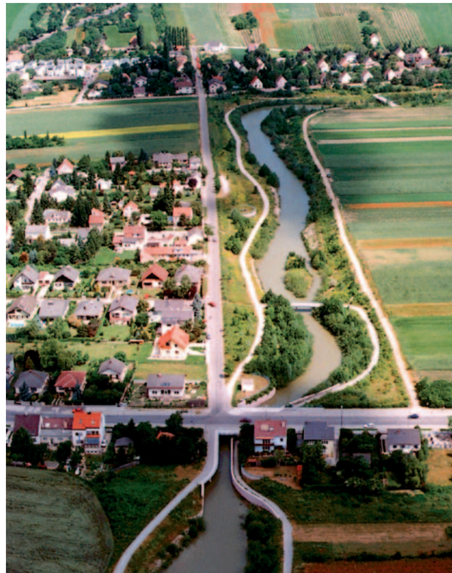
Rakouský Marchfeldkanal – investice pro podporu vodního hospodářství a životního prostředí, již bylo možno předejít výstavbou vodního koridoru D-O-L. Dnes je využíván i pro plavbu sportovních plavidel.
