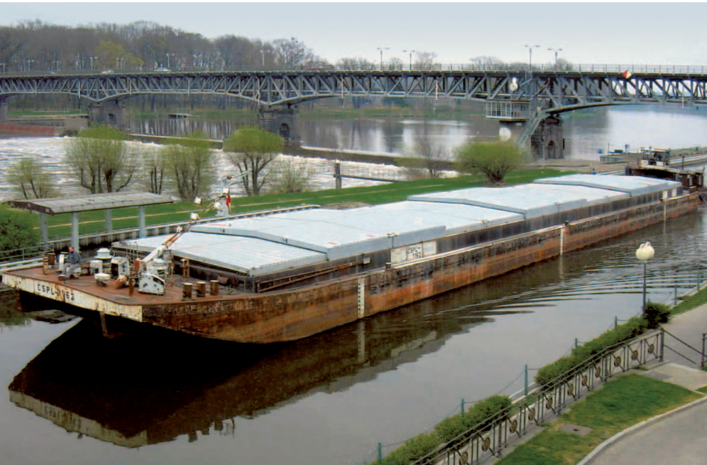
Roudnice nad Labem – jez a horní plavební kanál.
