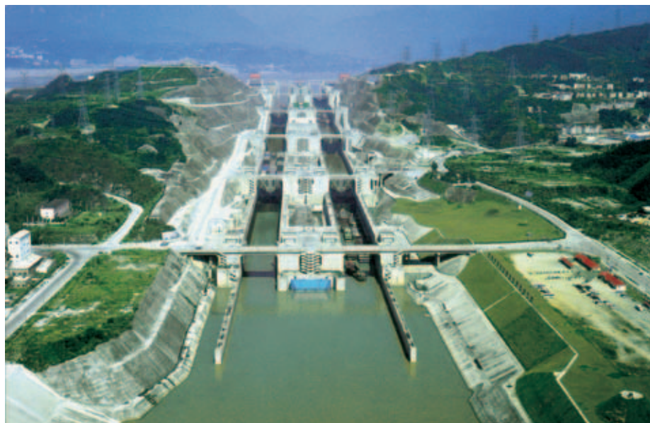
Pětistupňová dvojitá stupnice plavebních komor na vodním díle Tři soutěsky v Číně. Rozměry každé z komor činí 280 x 34 m při hloubce záporníků 5 m. Dopravní kapacita stupnice dosahuje 50 mil. t v každém směru.
