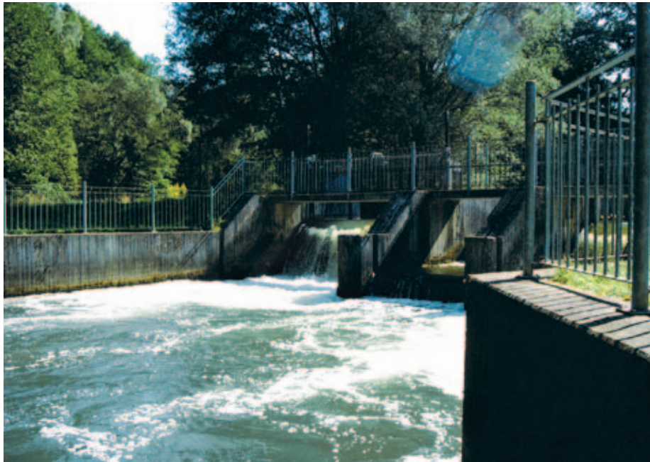
Obnovený malý jez Eisenhammer na řídce Roth. Snímek ze srpna 2003, tj. z období mimořádného sucha, dokumentuje stav průtoku na řídce, která by byla bez přívodu vody z Dunaje téměř vyschlá. Spád jezu je využíván v malé vodní elektrárně u bývalého hamru, který byl obnoven a slouží jako muzeum staré techniky.
