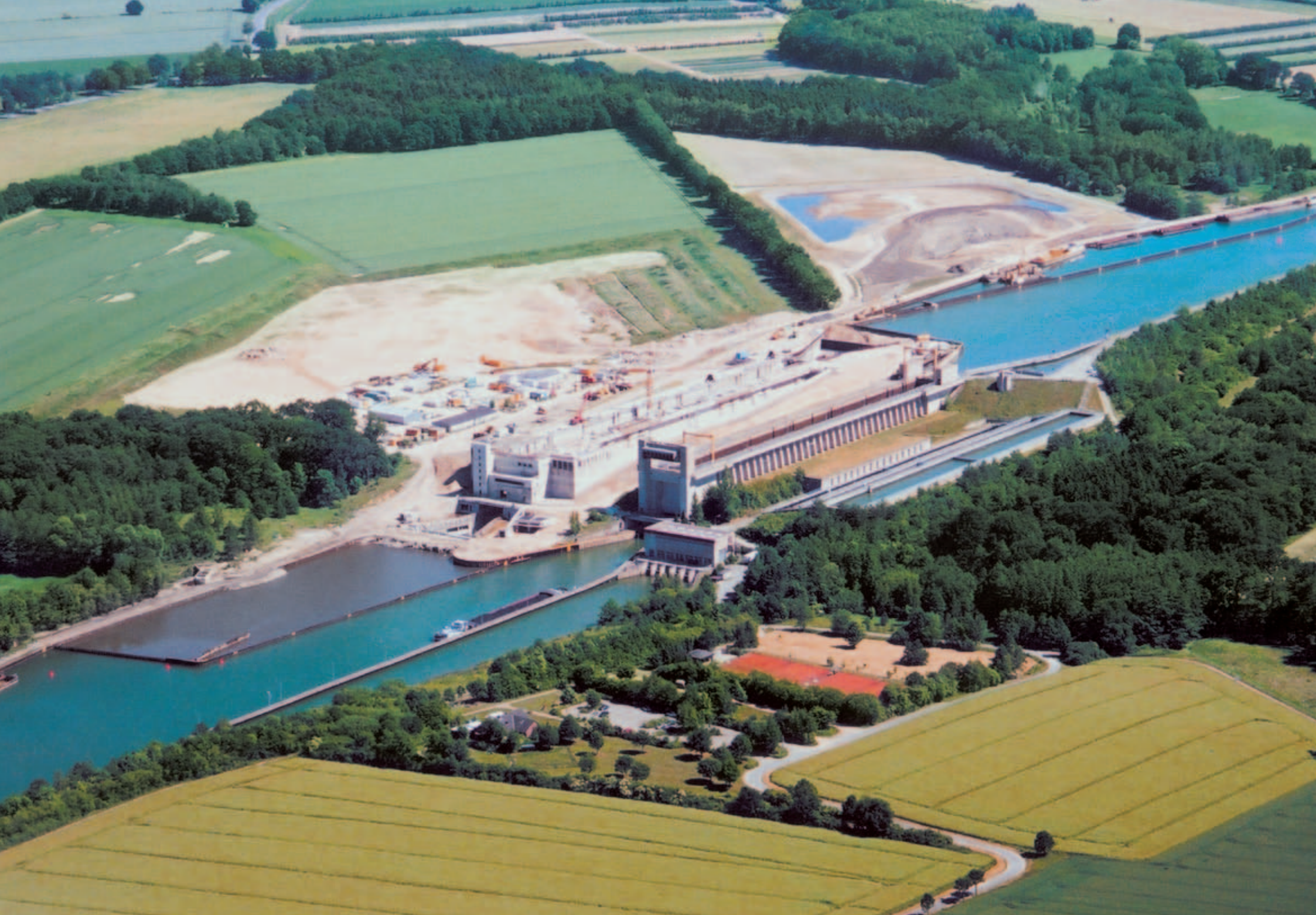
Plavební komora Uelzen na Labském laterálním příplavu. Vedle původní komory se buduje druhá.
