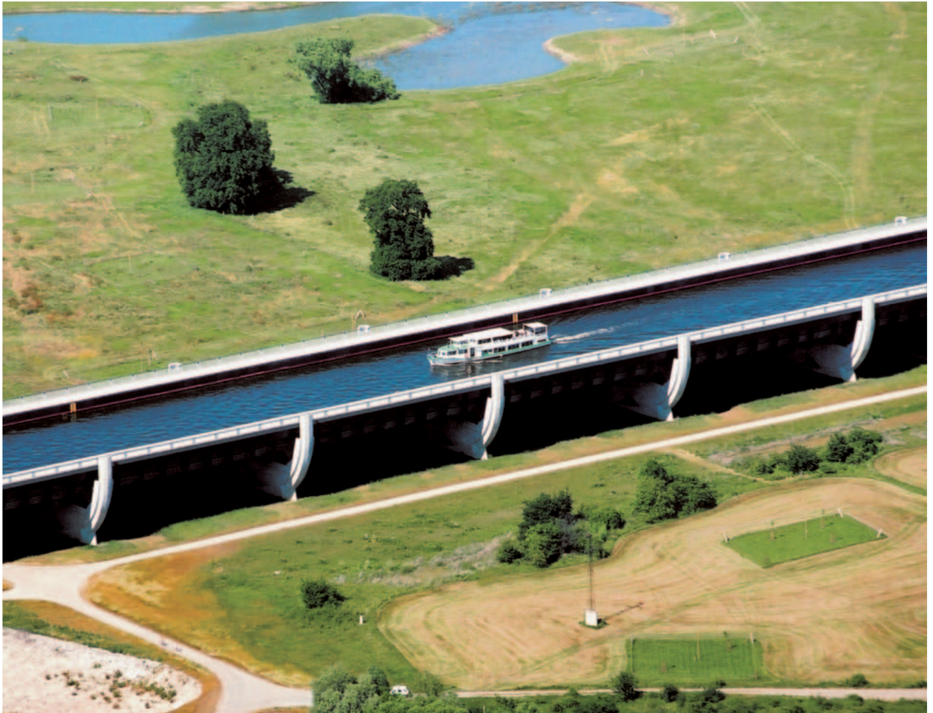
Osobní loď proplouvá inundační částí průplavního mostu u Magdeburku. Hladina na mostě se nachází 16 m nad terénem (zátopovým územím Labe).
