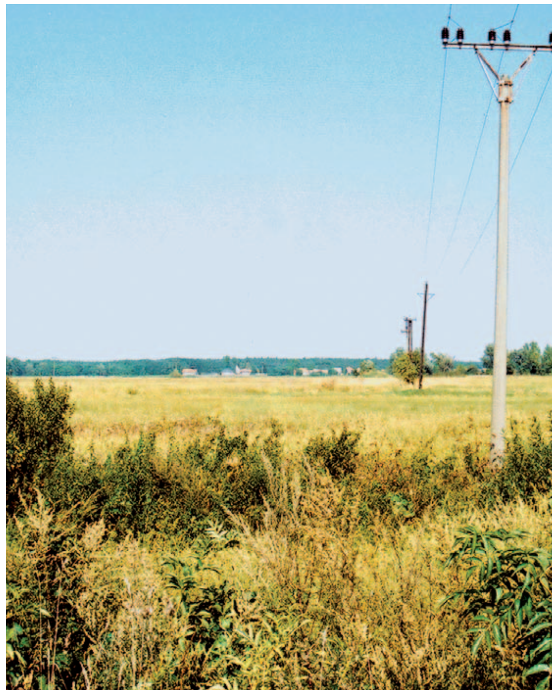
Charakter krajiny u obce Moravský Svätý Ján. Pohľad podél trasy (var. A, B a D) k severu dokumentuje, že koridor by protínal hlavně zemědělské plochy, tedy nikoliv ekologicky cennou krajinu.
