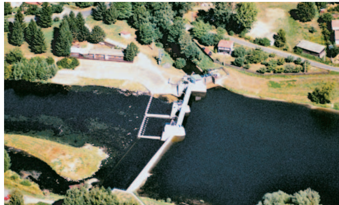
Celkový pohled na jez v Oseku na Bečvě.
