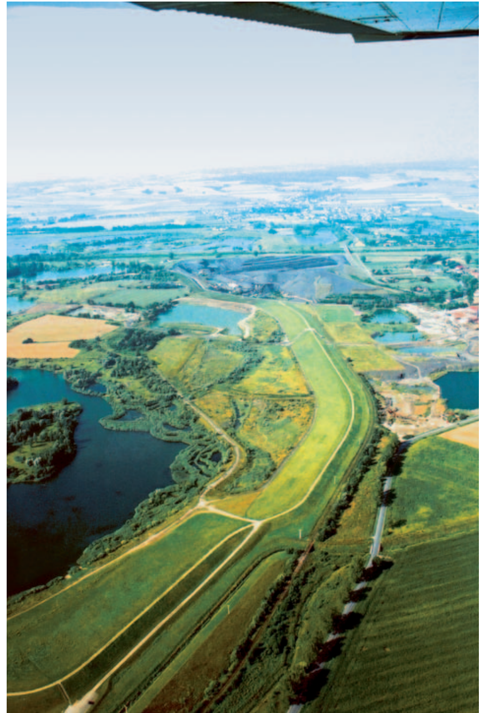
Východní obvodová hráz poldru Buków. V prostoru poldru (vlevo) se soustřeďuje těžba šterkopisku. Osou poldru může být vedena trasa vodního koridoru D-O-L.
