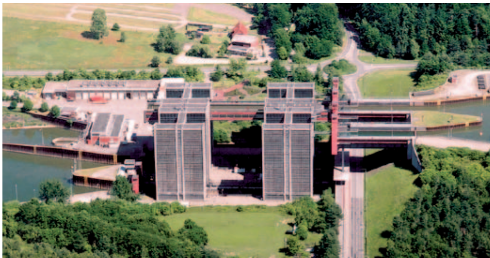
Dvojité lodní zdvihadlo s protizávažími u Lüneburgu na Labském laterálním příplavu dokončené v roce 1975. Za povšimnutí stojí soustředění kladek do čtyř věží. Architektonické ztvárnění tohoto díla dokazuje, že ani vysoké lodní zdvihadlo nemusí být technokratickou ocelovou konstrukcí jako v případě zdvihadla Niederfinow.
