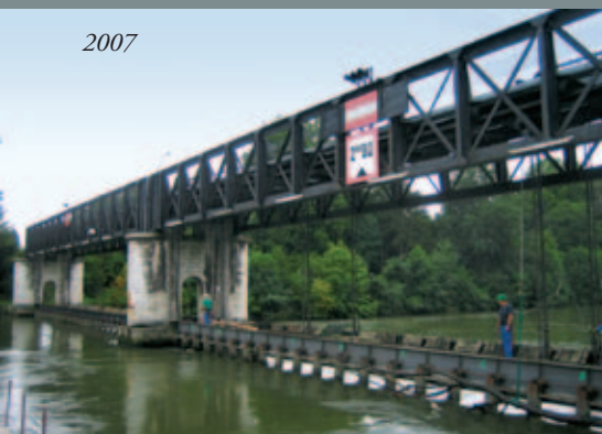
Výstavba nových klapkových jezů na řece Oise byla zahájena jezem Isle Adam (1. a 2. řádka) a pokračuje jezem Pontoise (3. řádka).
