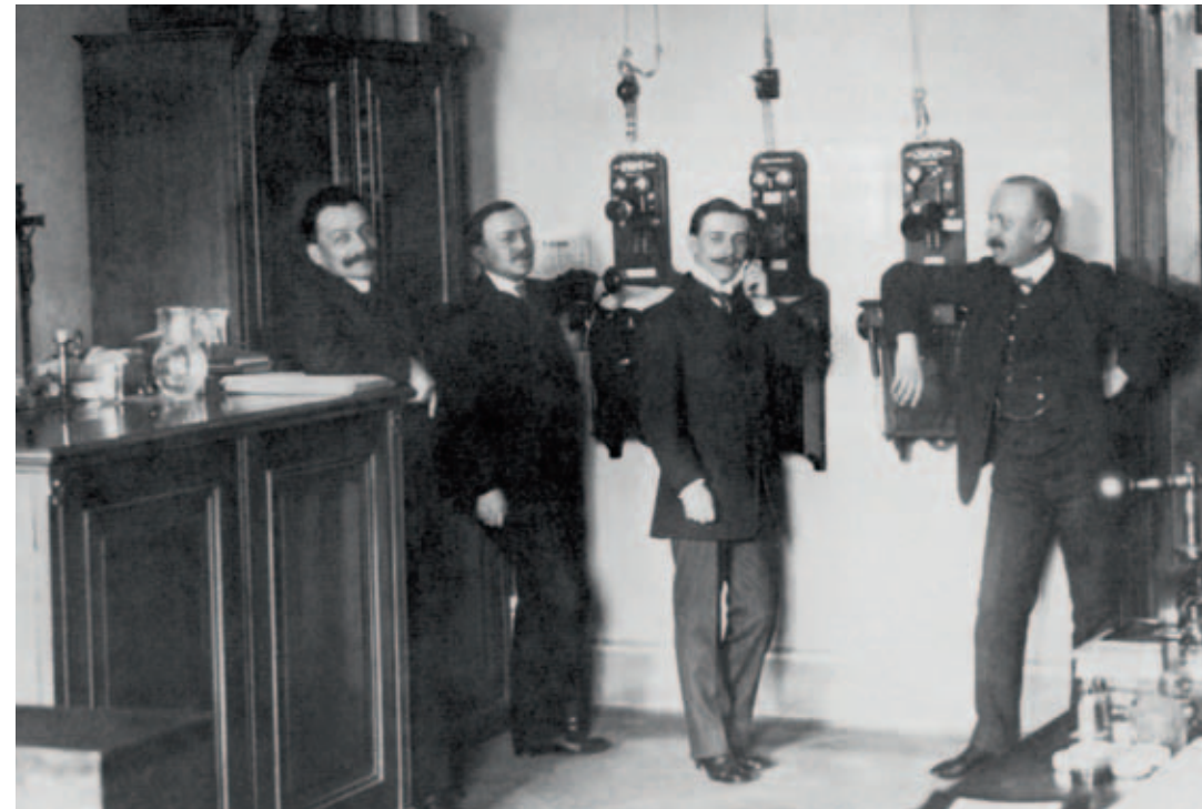
Souběžně s výstavbou plavebních stupňů se již na vodních cestách v bývalém Rakousko-Uhersku začala uplatňovat sdělovací a informační technika, tj. „vodní linky“. Byl to jistě pokrok, byť ze současného hlediska budící nejspíše úsměvy.
