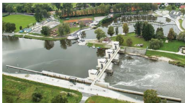
Letecký pohled na zdymadlo a přístav Hluboká nad Vltavou
