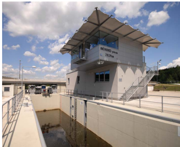
Velín plavební komory na přehradě Hněvkovice
