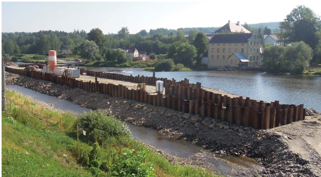
Výstavba plavební komory na jezu Hněvkovice – srpen 2015
