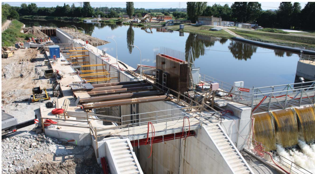
Plavební komora České Vrbné ve výstavbě v roce 2010
