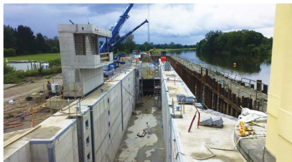
Výstavba plavební komory Hluboká nad Vltavou (2012)
