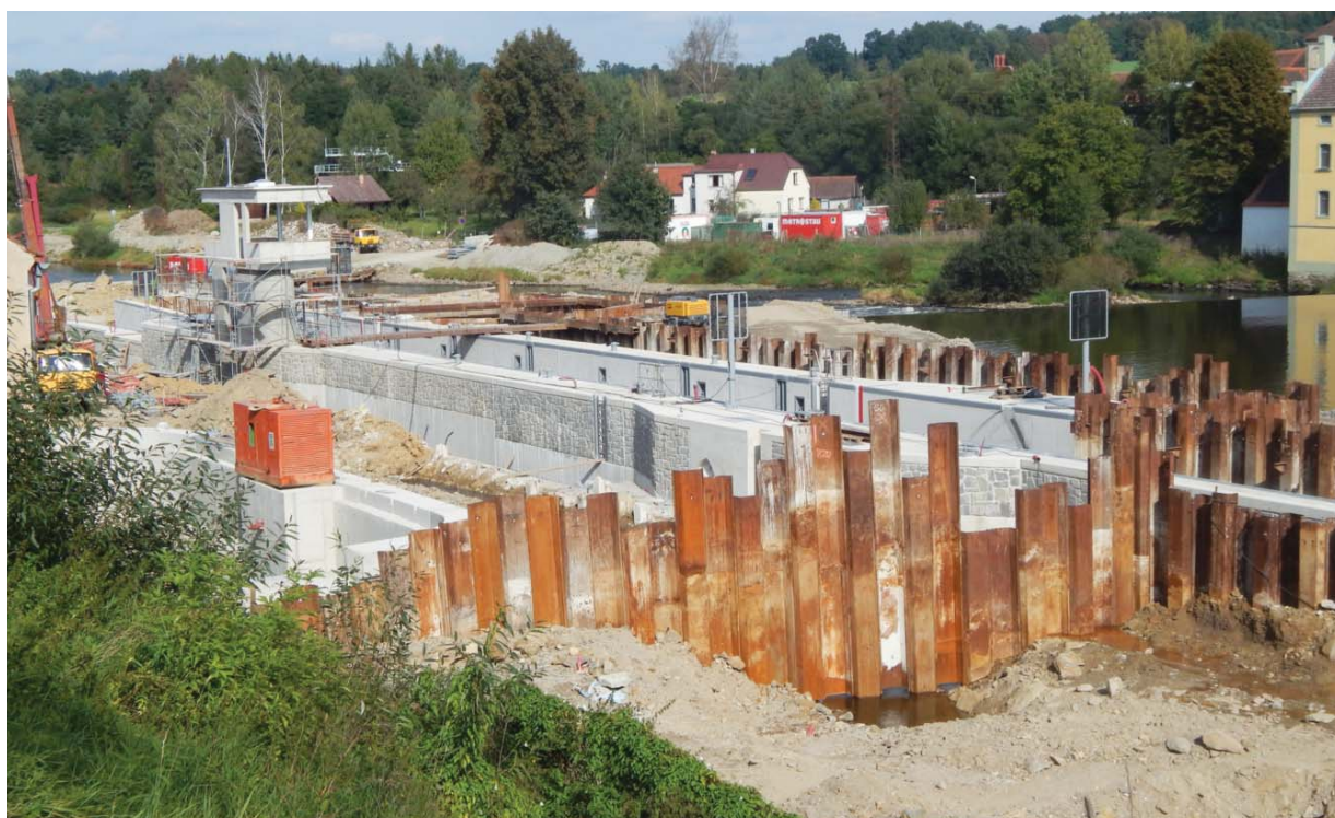
Výstavba plavební komory na jezu Hněvkovice – září 2016
