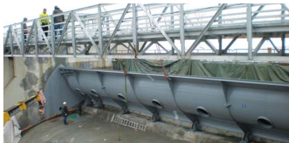
Modernizace jezu České Vrbné (2009)
