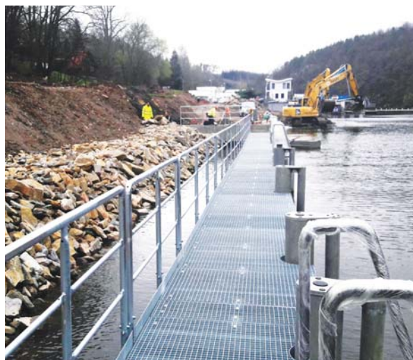
Modernizace rejd plavební komory Kořensko
