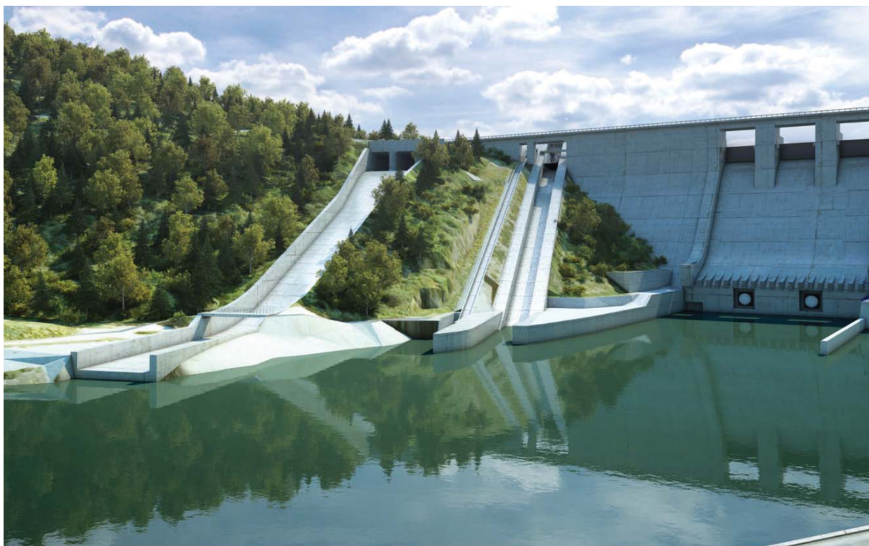
Vizualizace nového bezpečnostního přepadu vodního díla Orlík (vlevo) a nedokončené lodní zdvihadlo (vpravo)
