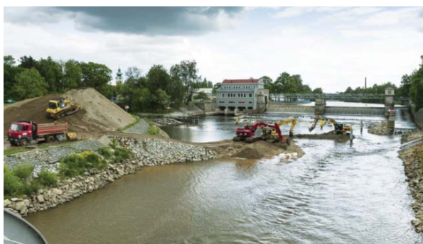
Výstavba obratiště v podjezí Jiráskova jezu v Českých Budějovicích byla velmi náročná
