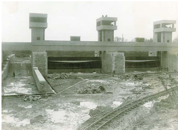
V 30. letech byl postaven jez u Hluboké nad Vltavou, který měl zajistit dostatečné plavební hloubky až do přístavu České Budějovice
