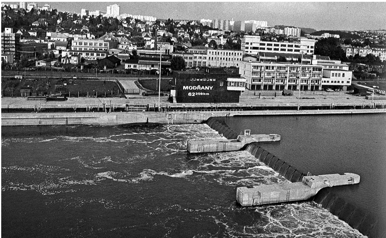
Klapkový jez v Modřanech s plavební komorou u pravého břehu a břehovou elektrárnou na pravém břehu po dokončení v roce 1988, foto: J. Podzimek
