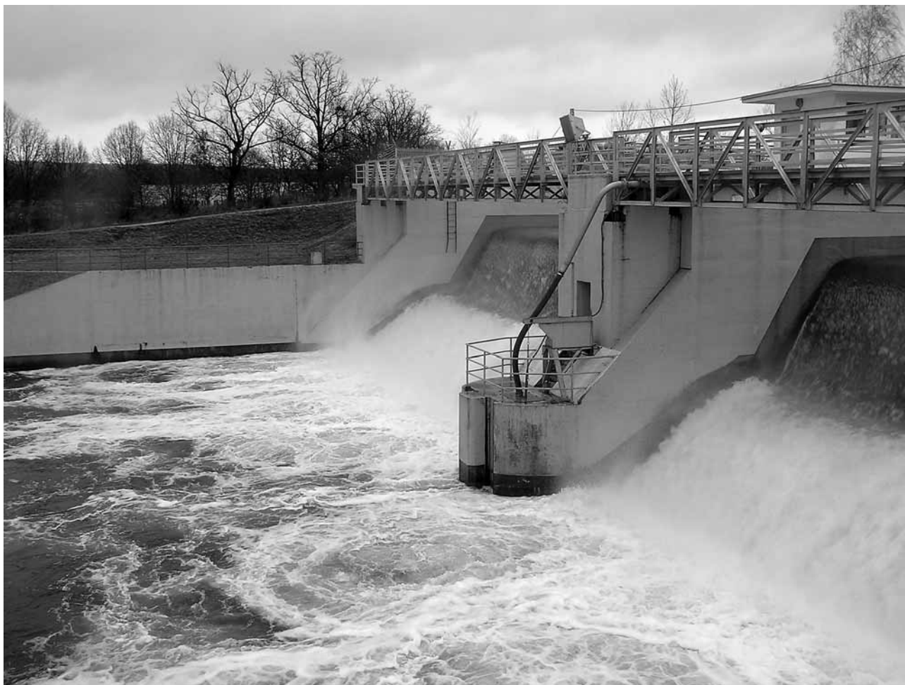
Jez na Horní Vltavě v Českém Vrbném před rekonstrukcí.
