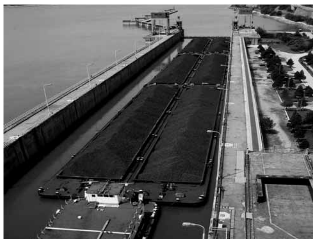
Tlačná souprava v komorách VD Železná Vrata na Dunaji.
