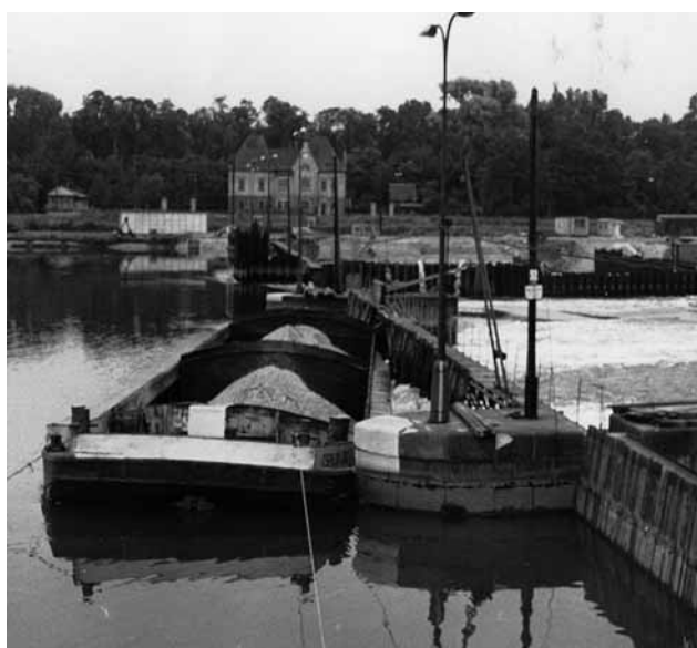
Havárie hradlového jezu v Troji se slučím hnízdem v pozadí.
