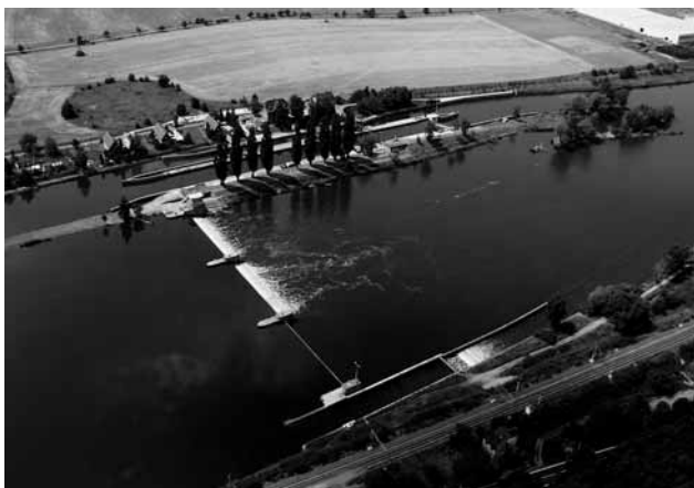
Nový sektorový jez a plavební komora v Dolních Beřkovicích (1973)
