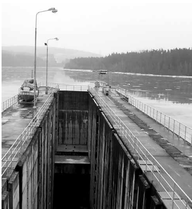
Plavební komora VD Hněvkovice
