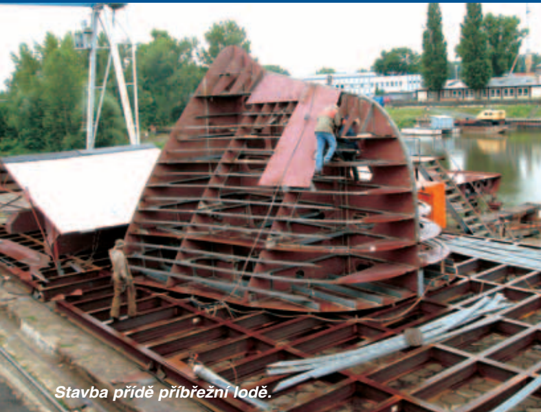
Ocelová konstrukce nástavby příbřežní lodě.
