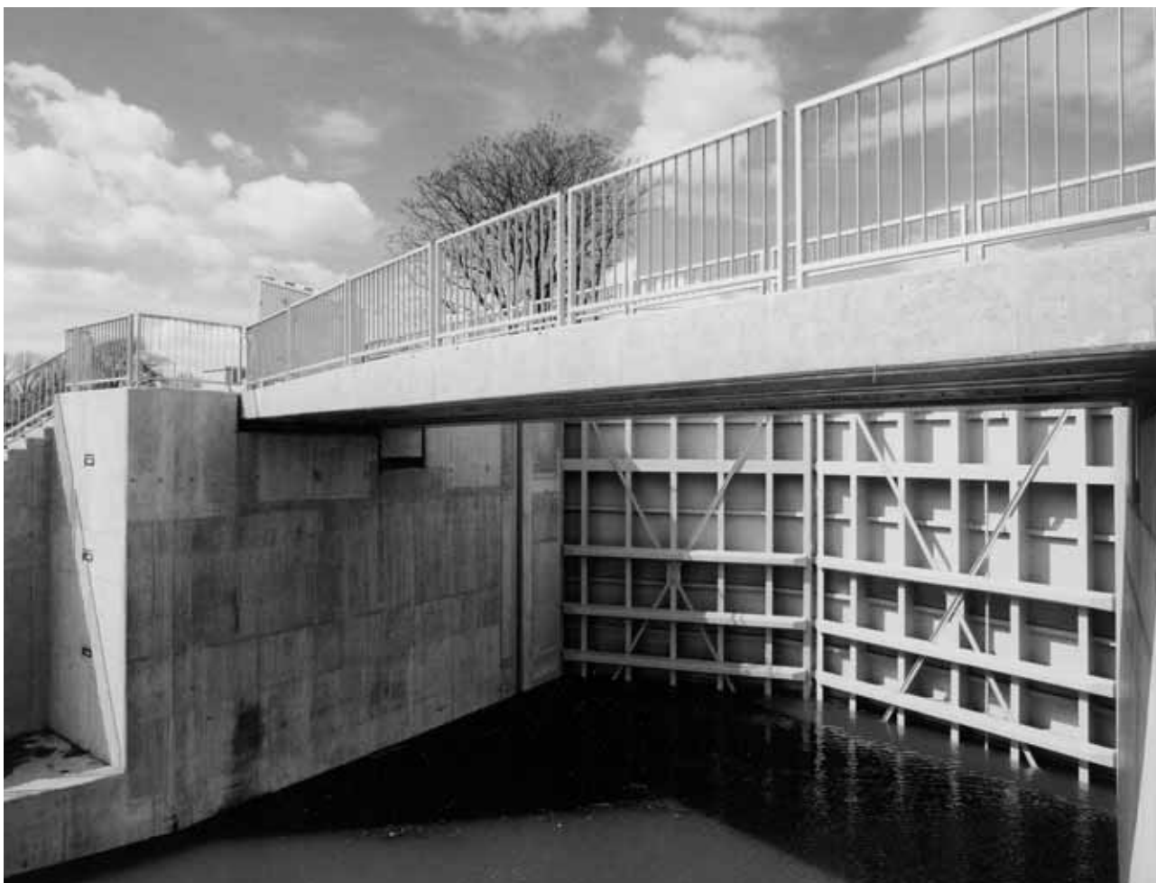
Mokrý zkoušky vzpěrných vrat.
