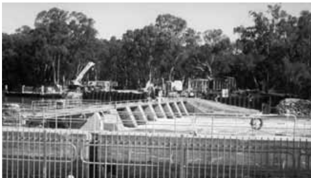
Rekonstrukce jezu u stupně Wentworth. Spád jezu činí při střední vodě 3,5 m.
