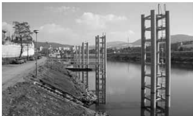
Nové vysokovodní dalby v přístavu Děčín - Rozbělesy.
