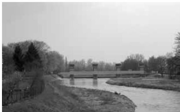
Plavební komora v Hluboké nad Vltavou bude na místě původní vorové propusti.
