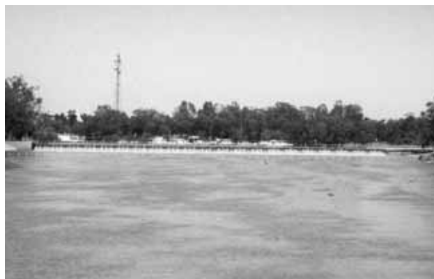
Jez u stupně Mildura, jehož hradící konstrukce se opírá o sklopné slupice. Snímek zachycuje jez při průtoku 210 m 3 s -1 , při kterém činí rozdíl hladin 3 m.
