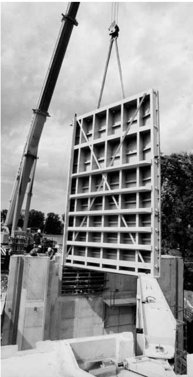
Usazování levé vrátně 120 t jeřábem.
