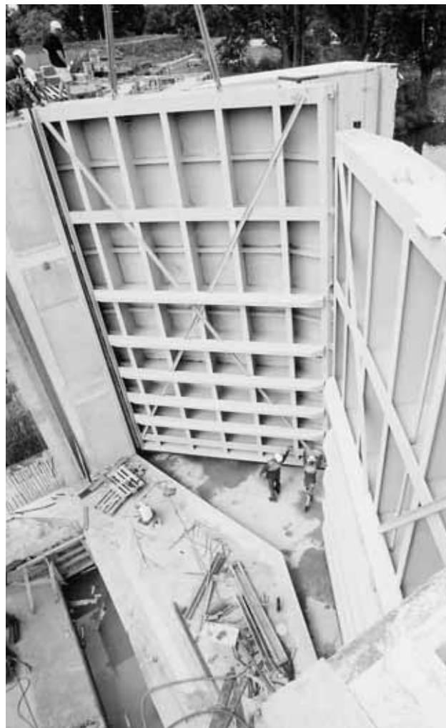
Nasazování vrátně na patní ložisko.
