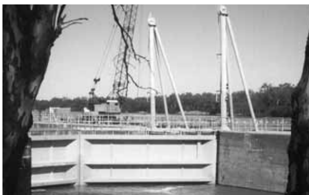
Dolní vzpěrná vrata plavební komory Wentworth.
