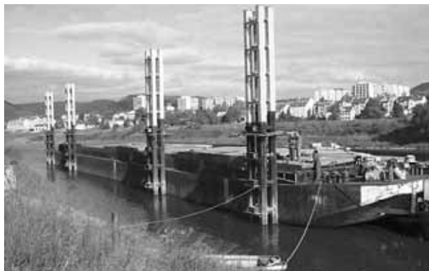
Zvýšení stávajících dalb v přístavu Děčín - Rozbělesy.
