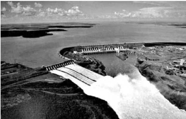
Hráz přehrady Itaipu, vlevo boční přelivy, vpravo elektrárna
