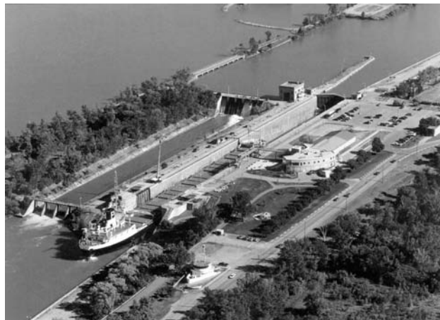
Welland kanál – pohled na plavební komoru č. 3 v St. Catharines s budovou muzea a informačního centra správy kanálu.
