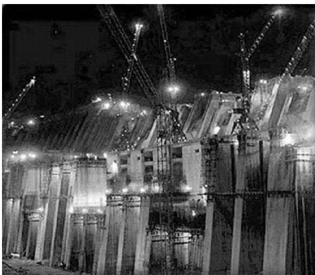
Přehrada ve výstavbě
