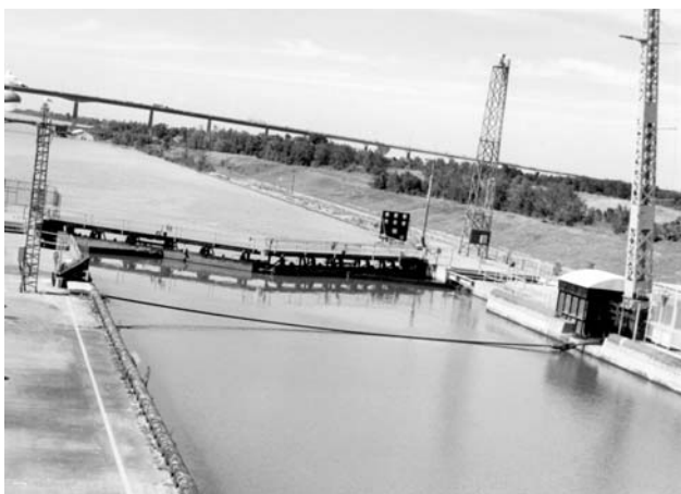
Dolní ohlaví plavební komory č.3 je připraveno na příplutí jezerní lodí. Na obzoru je visutý most dálnice QEW z Toronto do Niagara Falls a Buffala.
