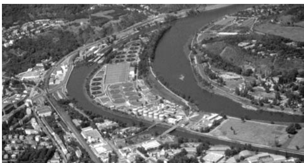
Plavební komory v Praze - Podbabě
