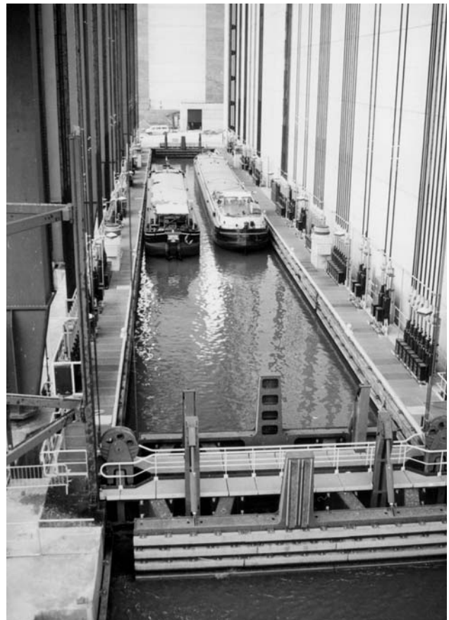
Tradiční lodi typu péniche se mohou ve žlabu zdvihadla seskupovat i vedle sebe. Najednou mohou být proplavena až 4 plavidla tohoto typu. V popředí jsou na snímku patrná vrata žlabu a zdrže, chráněná s obou stran mohutnými dynamickými ochranami. Zřetelné jsou i hydraulické kompenzátory na závěsných lanech.
