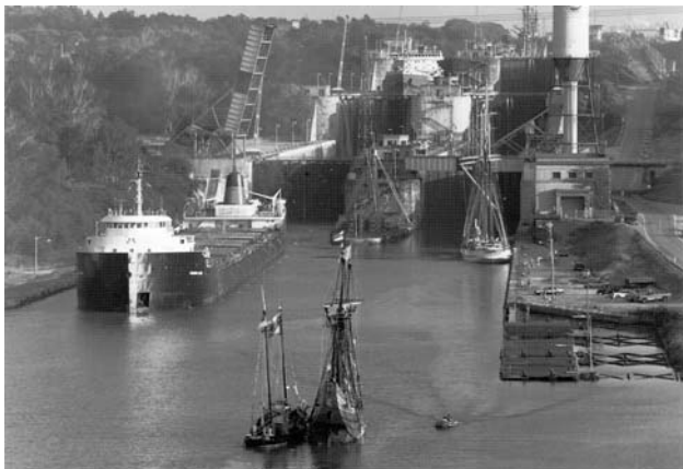
Plavební komory Welland kanálu č. 4 jsou prvním stupněm zdvojené stupnice tří sdružených plavebních komor. Každá stupnice pracuje pro jeden směr.
