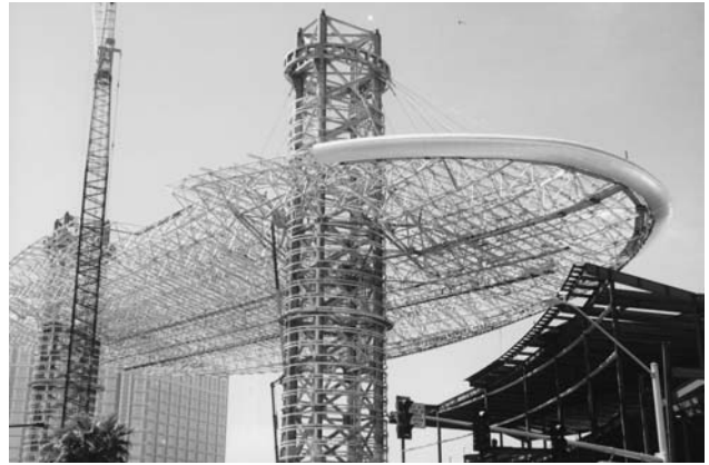
Montáž ocelové konstrukce nového hotelu v Las Vegas
