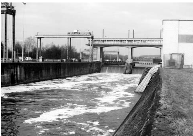
Obr. 4: Typický plavební stupeň na řece Sambře, tvořící součást jižní transversály. Vzduší zajišťuje nevelký pohyblivý jez o dvou polích, improvizovaná malá vodní elektrárna (vpravo) využívá disponibilní spád pomocí turbin s plechovými savkami.
