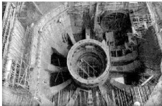
Základ před osazením spirály
