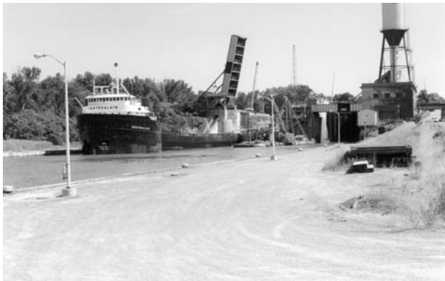
Typická jezerní loď (laker) Montrealais vyplouvá z plavební komory č.4. Na ohlavi plavební komory je vztyčen železniční výklopný most.
