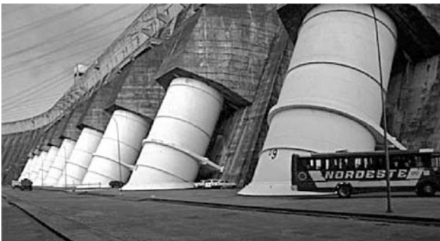
Přívodní potrubí ke spirálám turbin o průměru 10.5 m
