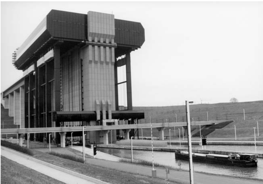
Motorová loď typu péniche (nosnost 300 t), vplouvající z dolní vody do zdvihadla Strépy. Ve srovnání s tímto obrovským objektem vypadá plavidlo o nosnosti 300 t trochu titěrně.
