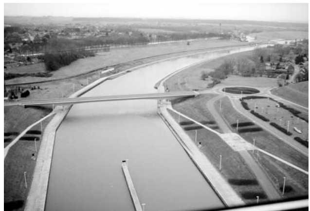
Pohled prosklenou stěnou restaurace na zdvihadlo Strépy na dolní rejdě a krajinu směrem k Mons je srovnatelný s pohledem z cca 100 m vysoké rozhledny.
