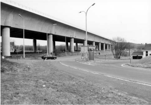
Celkový pohled na dokončený průplavní most Houdeng-Airmeries se na první pohled příliš neliší od pohledu na Nuselský most v Praze...
