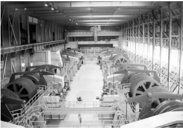
Pohled do strojovny prosklenou stěnou turistické restaurace. V pozadí poloportálový jeřáb.
