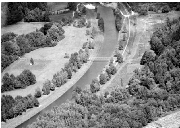
Upravená řeka Odra nad Svinovem, která se stane po zřízení definitivního jezu v Ostravě-Svinově součástí vodní cesty.
