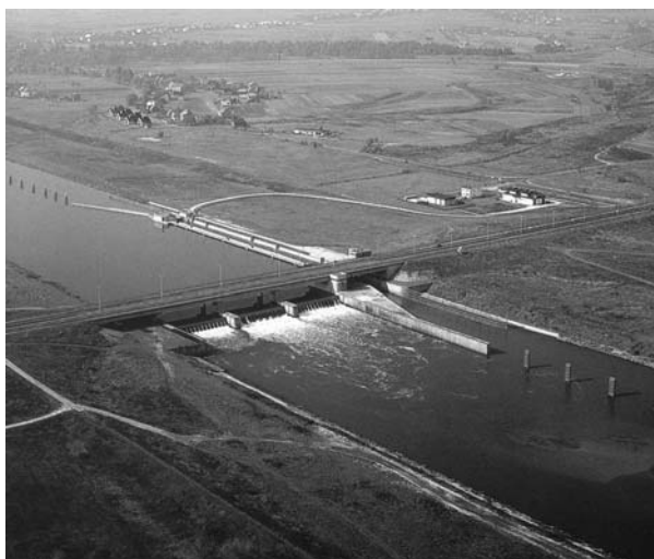
Stupeň Kościuszko na horní Visle. Nad dolním ohlavičím plavební komory a nad jezem je situován dálniční most v trase jižního dálničního obchvatu Krakova.
