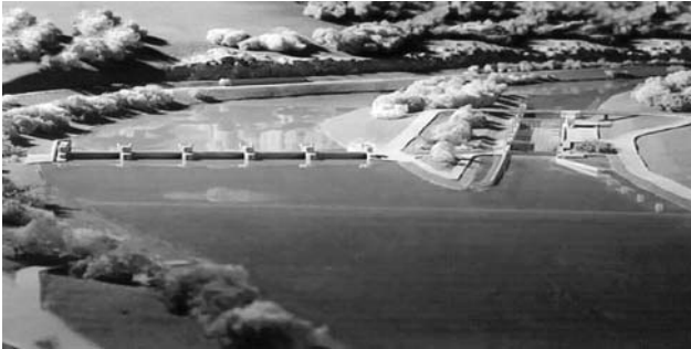
obr. 3 - Plavební stupeň Malé Březno
