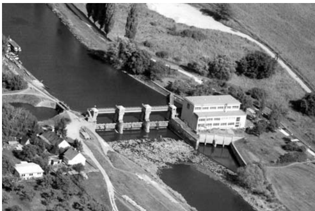
Jez v Hodoníně vytváří dlouhou zdrž, dosahující až k Rohatci, která je již dnes vhodná pro plavbu. Snímek byl pořízen v srpnu 2003 za velmi nízkého stavu vody a dokumentuje, že jezem ani vodní elektrárnou neprotéká již žádný průtok. Veškerá voda je odebírána náhonem tepelné elektrárny (vlevo).
