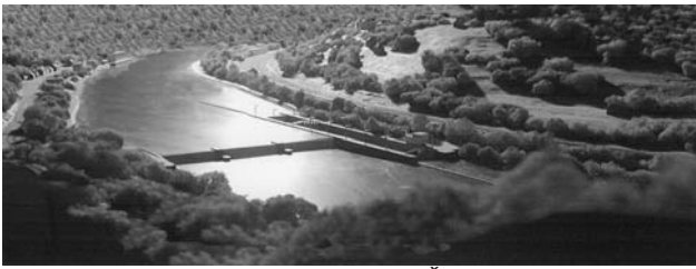
obr. 2 - Plavební stupeň Prostřední Žleb
