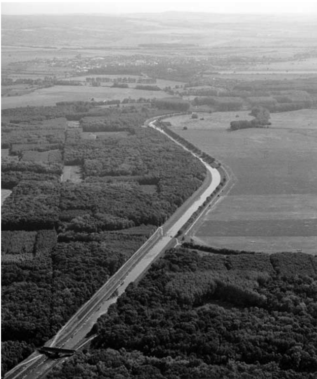
Odlehčovací rameno řeky Moravy mezi Uherským Ostrohem a Vnorovy představuje téměř hotový úsek vodní cesty – vyžaduje jen zřízení příslušného vzdouvacího objektu.
