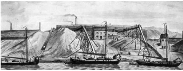
Lodě s malý ponorem pro plavbu na horním toku řeky Weaver jsou nakládány solí pomocí násypek, kresba z roku 1856.
