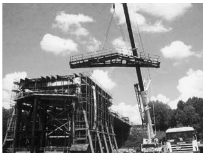
Autojeřáb o nosnosti 1000 tun v květnu 2000 při rekonstrukci lodního zdvihadla Anderton.
