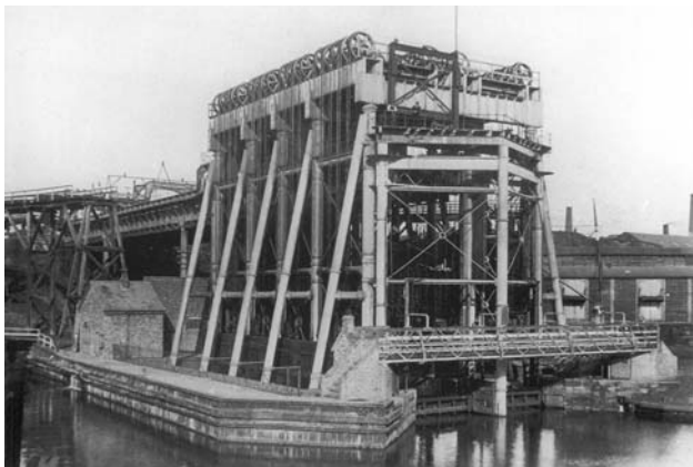
Nádherný záběr výtahu po transformačních úpravách z konce roku 1908. Jasně jsou vidět nové podpěry, mechanické ovládání, nový systém kladek, horní plošina a soustava lan nového výtahu.
