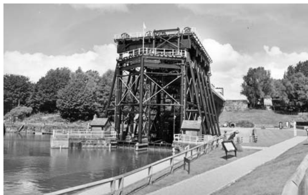
Pohled na lodní zdvihadlo Anderton po rekonstrukci (srpen 2004).
