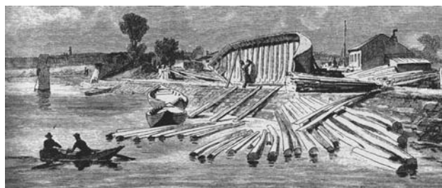
Dokončovací práce menšího šifu v Lannově loděnici v Českých Budějovicích
