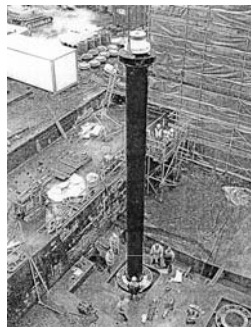
Osazování 17 m dlouhého pístu při zpětné rekonstrukci zdvihadla na hydraulický pohon.
