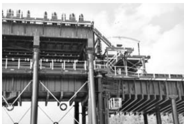
Napojení akvaduktu na konstrukci lodního zdvihadla.
