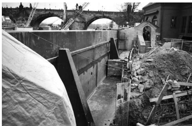
Dokončený tabulový protipovodňový uzávěr – prosinec 2004 b) pohled ze strany Čertovky
