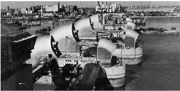
Protipřílivová bariéra na Temži před dokončením
