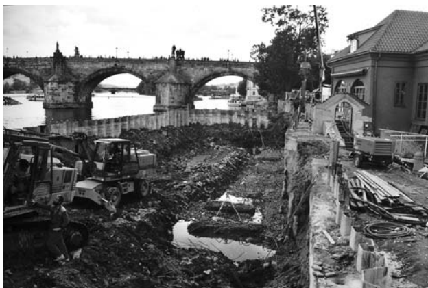
Pohled do stavební jámy 29.9.2002
