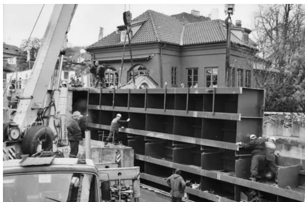
Osazování třetího dílu hradící tabule 26.11.2004
