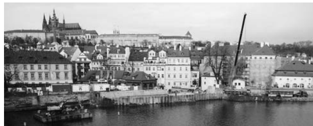
Pohled na stavbu protipovodňového uzávěru Čertovky 19.11.2004
