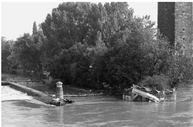
Plavební komora Smíchov
