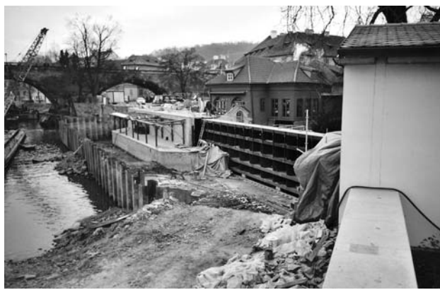
Dokončený tabulový protipovodňový uzávěr – prosinec 2004 a) pohled ze strany Vltavy
