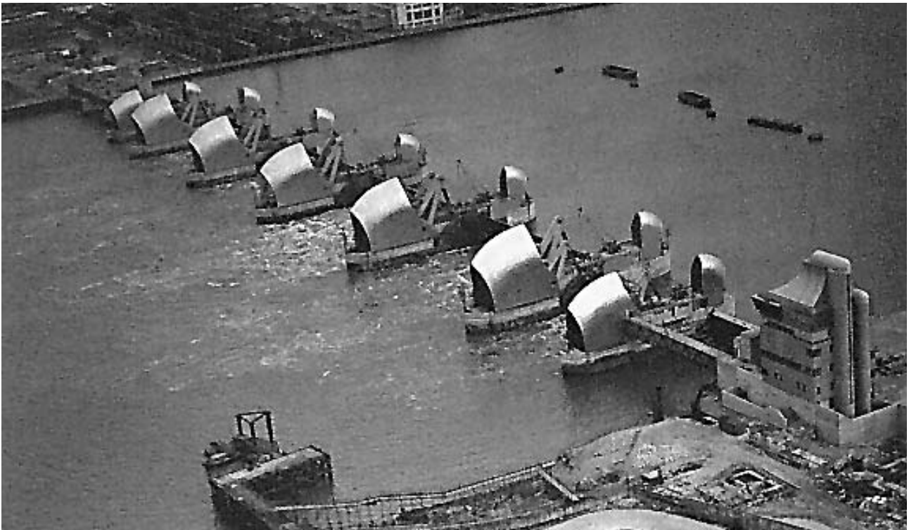
Letecký pohled na protipřílivovou bariéru na Temži
