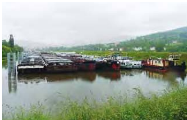
Ředitelství vodních cest ČR vybuodovalo v letech 2005–2006 také vysokovodní stání v přístavu Děčín-Rozbělesy. Při letošní červnové povodni byl ochranný přístav plně využit
