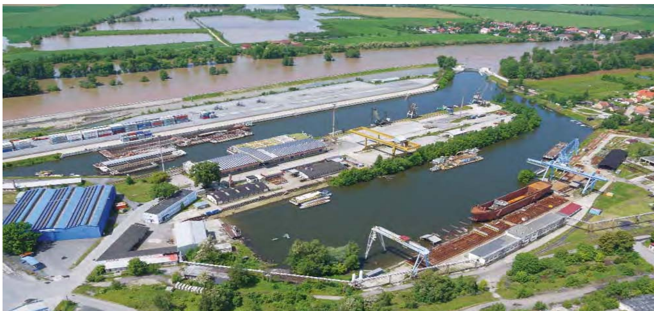
Mělnický přístav ochráněný novou hrází a protipovodňovým uzávěrem - 5.6. 2013
