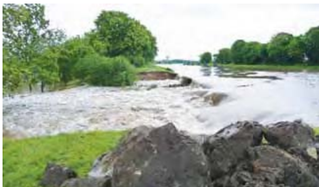
Řízené vypouštění plavebního kanálu 4. června 2013 po vybudování havarijního přelivu v pravé hrázi nad plavební komorou Hořín
