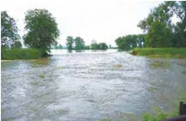
Porucha pravobřežní hráze mezi Lužcem a Vraňany (km 8,35) – nekontrolované plnění kanálu 4. 6. 2013
