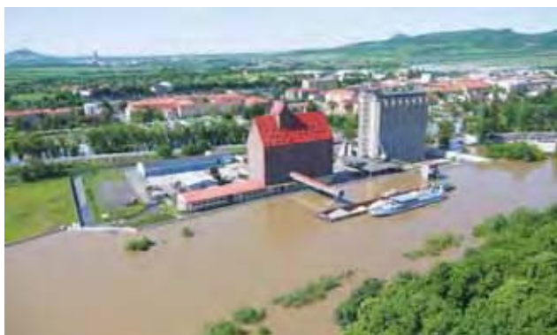
Lodě přecházejí povodeň v Lovosickém překladišti. Sila a závody Lo-vochemie jsou ochráněny novou protipovodňovou stěnou - 5.6. 2013
