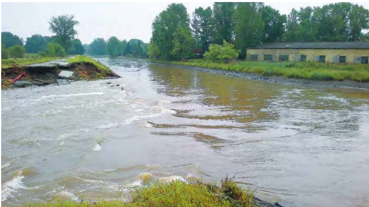
Průrva hráze plavebního kanálu u ÚČOV během povodně – 10. června 2013
