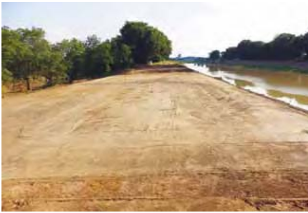
Zhutněná pláň pravobřežní poruchy nad plavební komorou Hořín – stav 25. 7. 2013
