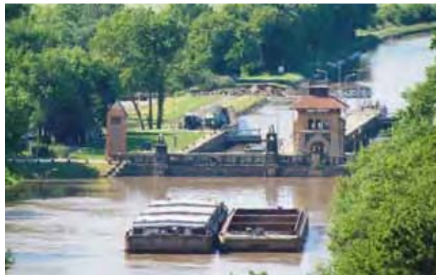
Nákladní čluny vyvázané pod plavebními komorami Hořín 5. června 2013. Na obrázku je také vidět, že Hořínský plavební kanál je již protržený, , foto: H. Vavřinová
