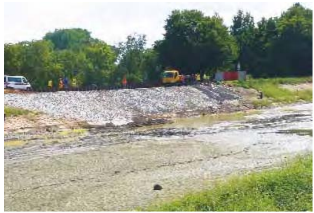
Stav opravy pravobřežní poruchy nad plavební komorou Hořín dne 13. 8. 2013
