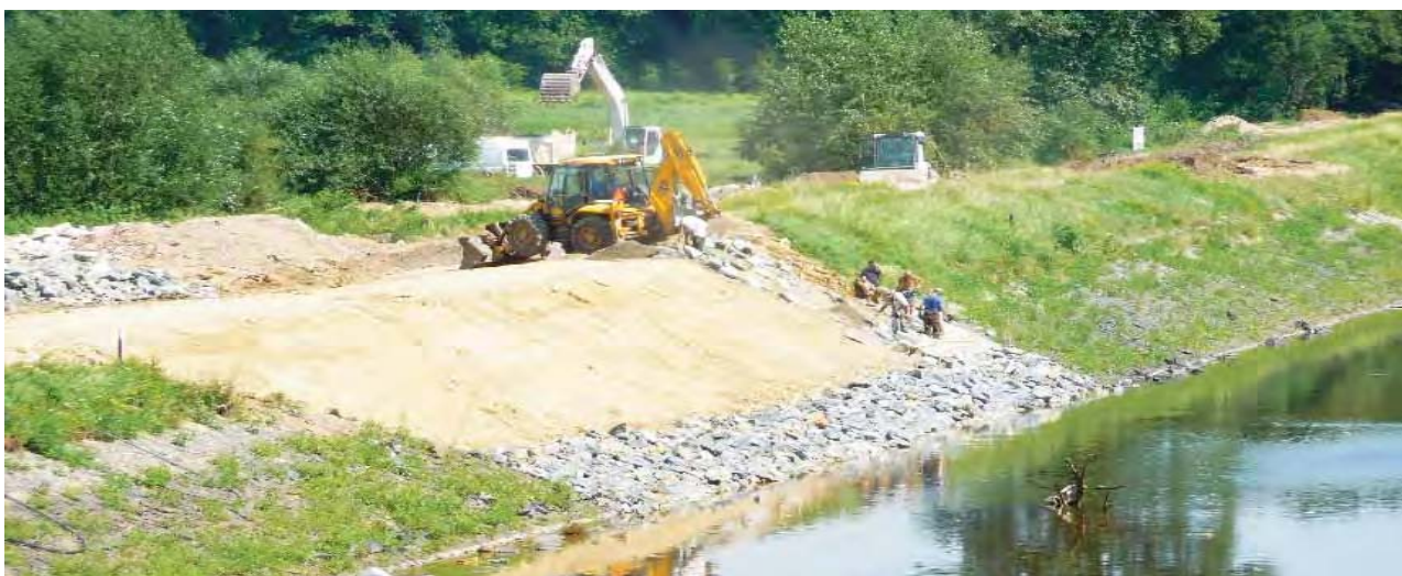
Opravné práce na průrvě plavebního kanálu – 6. srpna 2013
