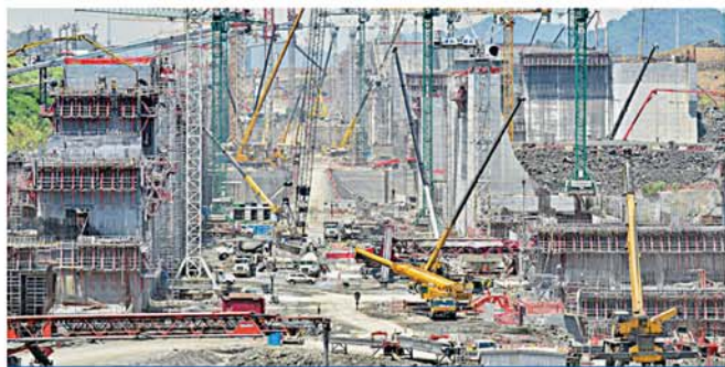
Výstavba nových plavebních komor probíhá ve dne...
