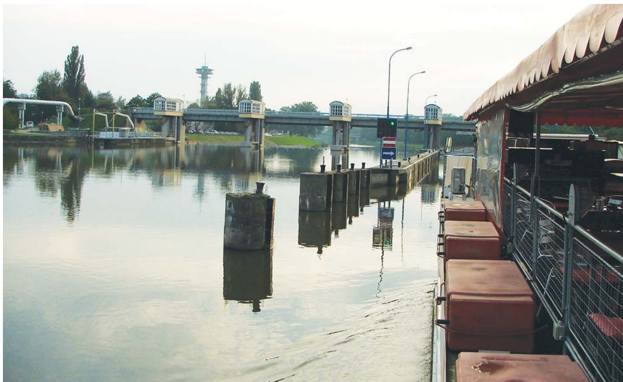
Vplouvání do plavební komory Pardubice
