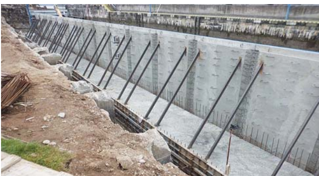
Betonáž pravé zdi plavební komory Velký Osek
