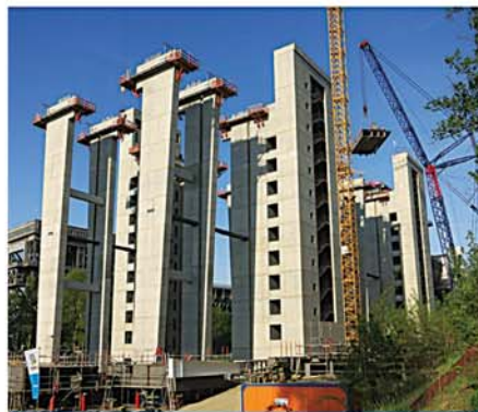
Stav výstavby nového lodního zdvihadla Niederfinow v květnu 2014
