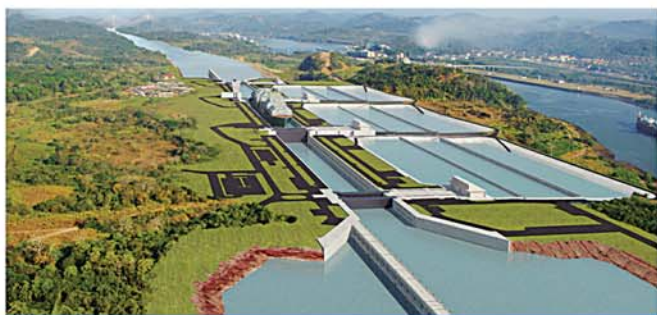
Vizualizace plavebních komor na pacifické straně Panamského průplavu
