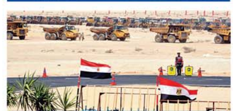
Stovky buldozerů, nákladních aut a na 7 500 dělníků zahájilo 5. srpna 2014 výkop nového Suezského průplavu
