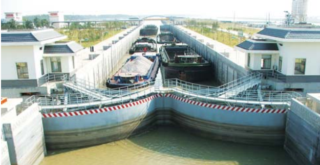
Nová třetí paralelní plavební komora Shaobo na císařském průplavu otevřená plavbě v roce 2012 o rozměrech 260x23x5 m
