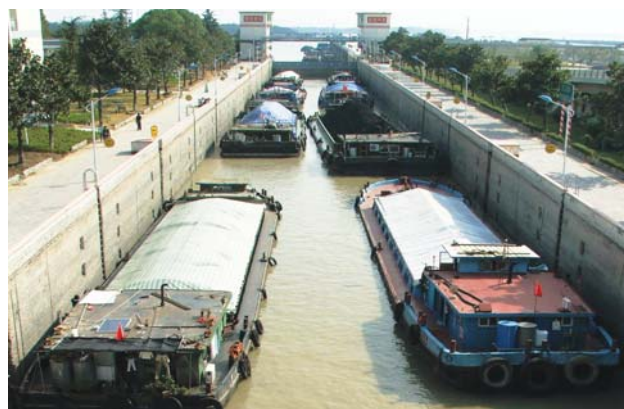
Jedna ze dvou plavebních komor Shaobo starší generace na Císařském průplavu o rozměrech 230x23x5 m
