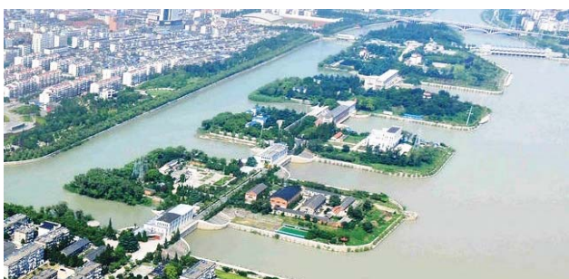
Velká čerpací stanice v Yangzhou je počátkem východní části projektu přesunu vody z jihu na sever
