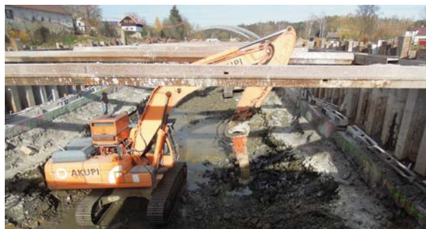
PK Hněvkovice – těžba na základovou spáru
