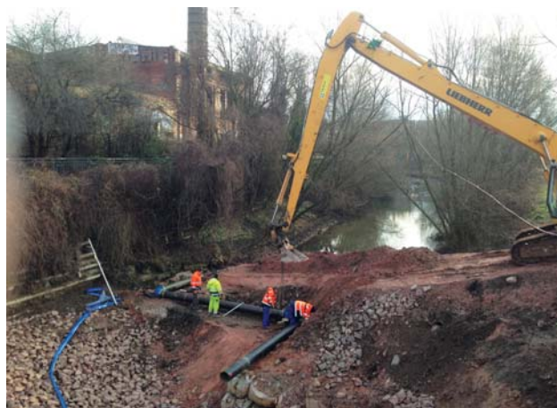
Odstraňování hráze a začátek napouštění nového plavebního kanálu (2015)
