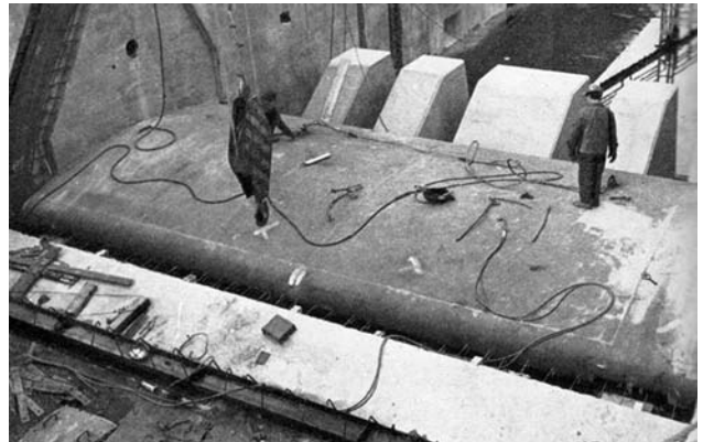
Montáž horních klapkových vrat v Dolních Beřkovicích
