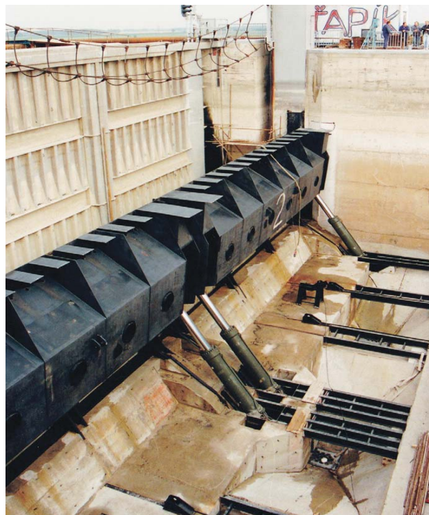
Podpírané klapky v horních ohlavi plavebních komor Gabčíkovo
