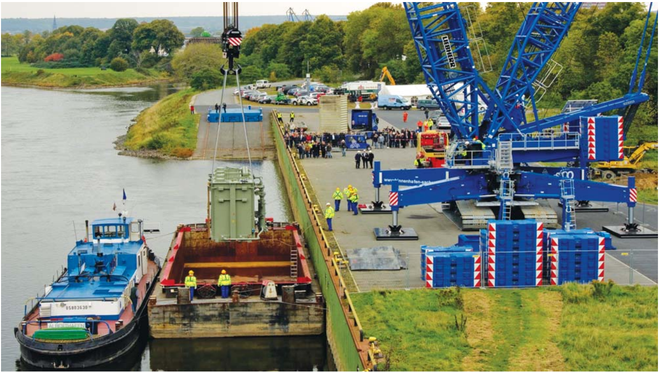
Nakládka transformátoru
