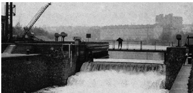
Speciální klapkový uzávěr pro malou plavební komoru v Praze-Podbabě pro převádění nezámrazného průtoku
