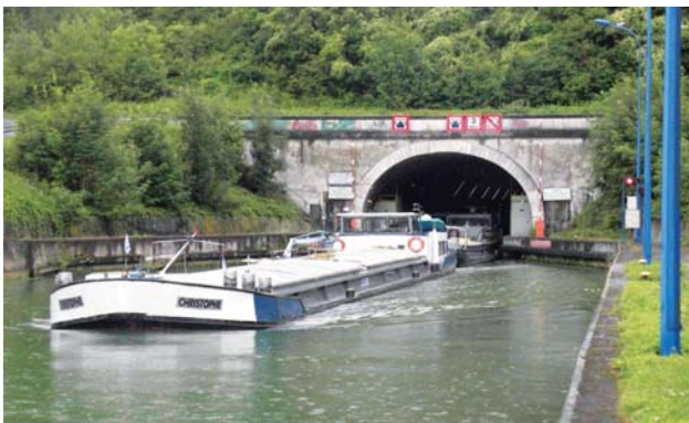
Vjezd do tunelu Ruyaulcourt na Canal du Nord
