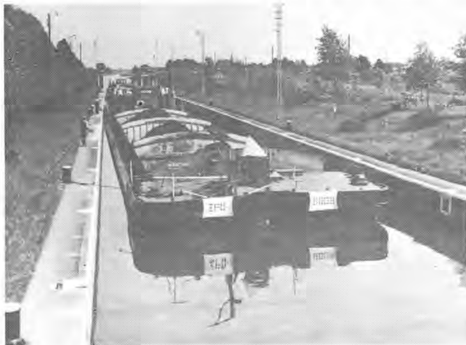
Obr. 5. Proplavování starou plavební komorou na Odře ve Zwanowicích. Rozměry komory činí 187,8x9,6 m.
