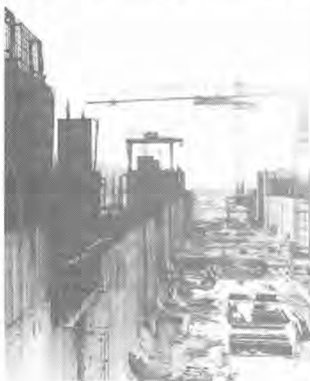
Obr. 2. Výstavba plavebních komor na jugoslávském břehu vodního díla v Kataraktech – stav roku 1969. Dnes jsou již v běžném provozu na každém břehu dvoustupňové plavební komory rozměrů 310 \times 34 \text{ m} .
