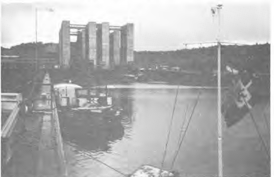
Obr. 10. Pohled z dolní rejdy na dvojité lodní zdvihadlo u Lüneburgu (Elbe – Seiten – Kanal). Užitné rozměry žlabů jsou 100 x 12 m.
