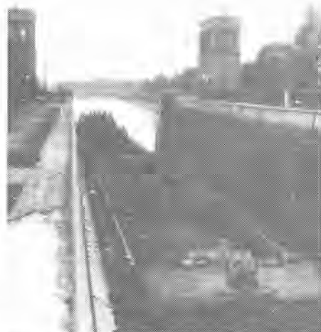
Obr. 4. Proplavování tlačné soupravy plavební komorou Brzeg Dolny na Odře. Užité rozměry této plavební komory činí 225 x 12 m.
