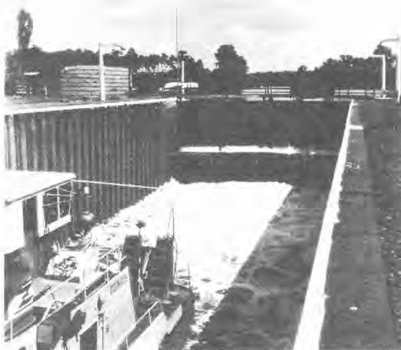
Hlivický průplav, plavební komora Nová Wies (přímé plnění)
