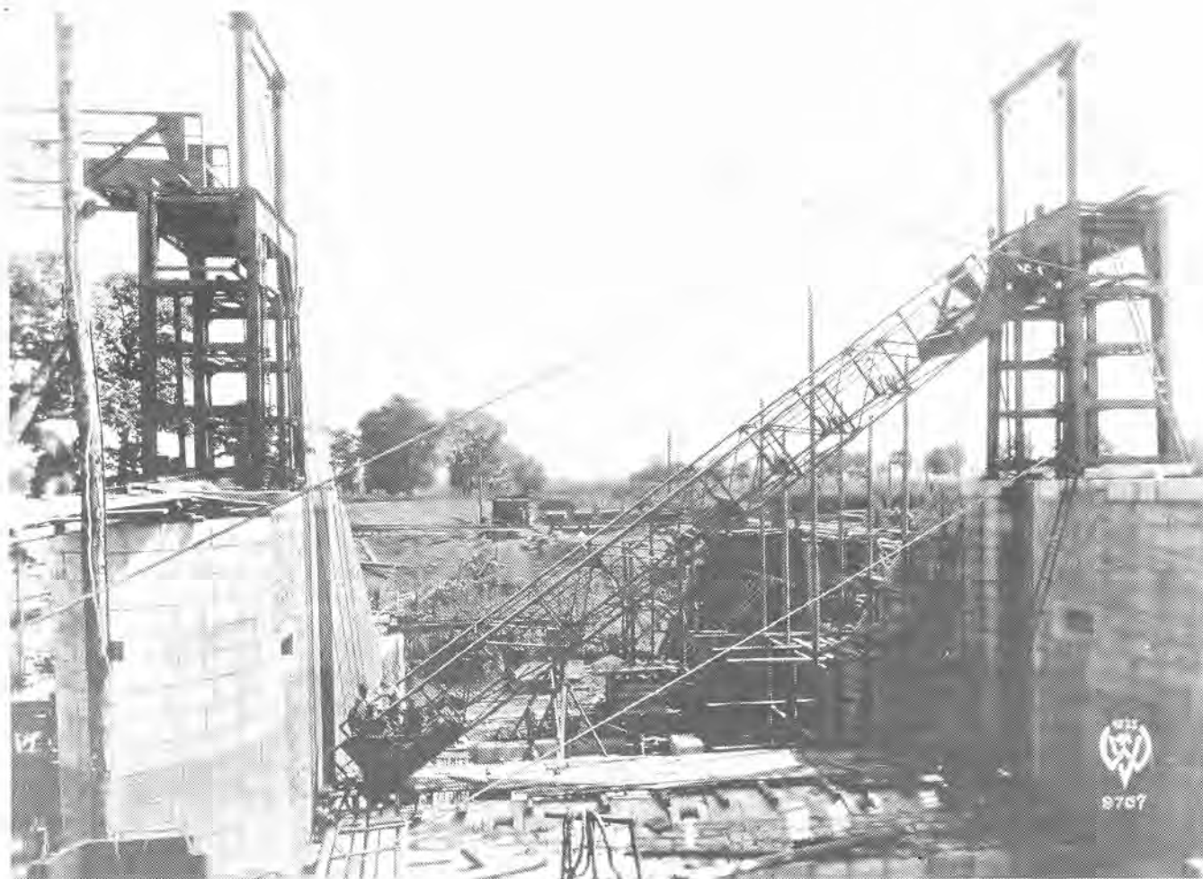
Obr. 2. Koblovský jez na Odře - stav výstavby 19. května 1936
