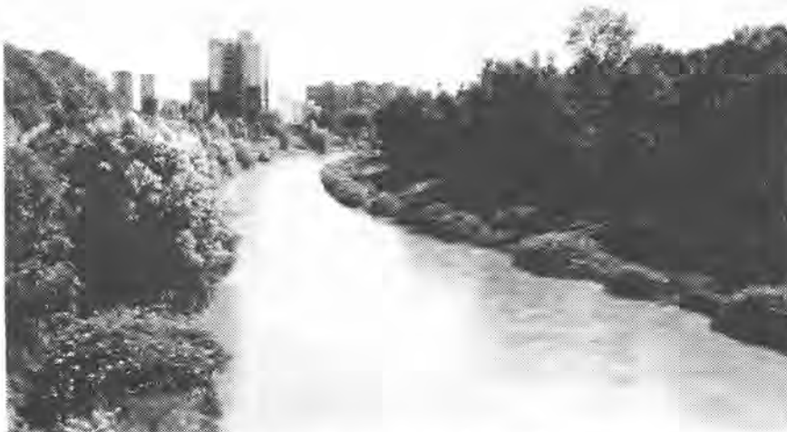
Obr. 3. Pohled z tzv. vodovodní lávky proti proudu Ostravice za vyššího stavu vody evokuje představu o vzhledu říční trati (výšce hladiny) po výstavbě stupně Muglinov
