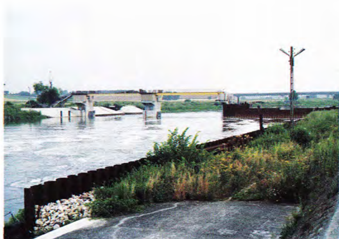
Obr. XI. Stavba nového jezu Rogów na Odře. Snímek zachycuje stav prací v červenci 1995. Dvě pole nového klapkového jezu jsou hotova, v pravobřežní jímce se buduje třetí pole a malá vodní elektrárna.
