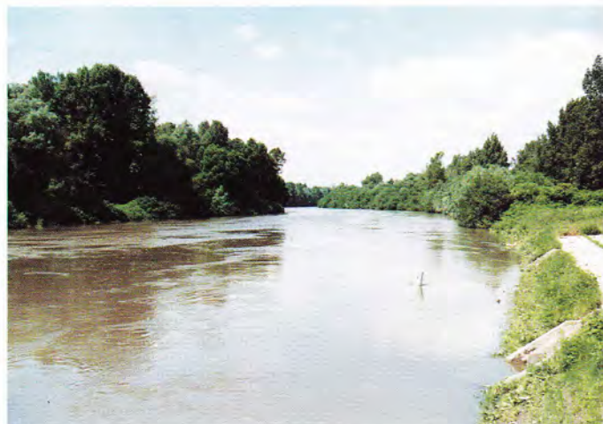
Obr. II. Pohled po proudu Odry od Hrušova směrem k Vrbici. Upravená trať umožňuje vedení plavební dráhy poloměrem cca 800 m. Snímek byl pořízen za vyššího vodního stavu, aby podpořil představu o pravděpodobné výšce hladiny v budoucí zdrži Kopytov (pokud by byla na kótě okolo 200 m n.m.).
