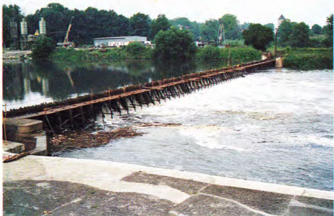
Obr. VII. Hradlový jez Rogów na Odře je ještě ve funkci, i když od jeho dokončení uplynulo více než 100 let.
