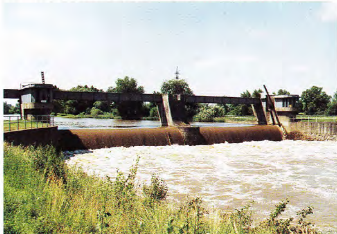
Obr. I. Jez na Odře v Ostravě-Lhotce, zajišťující hladinu ve zdrži Přívoz.
