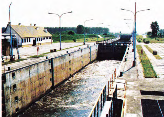
Obr. VIII. Nejnovější plavební komora (190 x 12 m) na Odře u Zwanowic.
