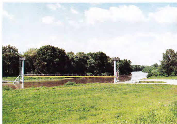
Obr. III. Speciální clona na likvidaci ropných havárií na Odře u Hrušova. Kdyby byl včas vybudován stupeň Kopytov, který by plnil danou funkci daleko spolehlivěji, nebylo by třeba tento objekt vůbec zřizovat.
