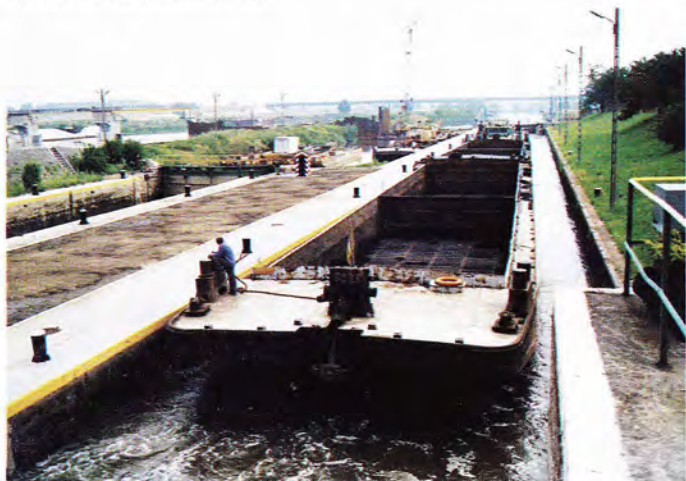
Obr. IX. Proplavovací tlačné soupravy ve velké plavební komoře stupně Rogów. Vlevo je malá plavební komora.
