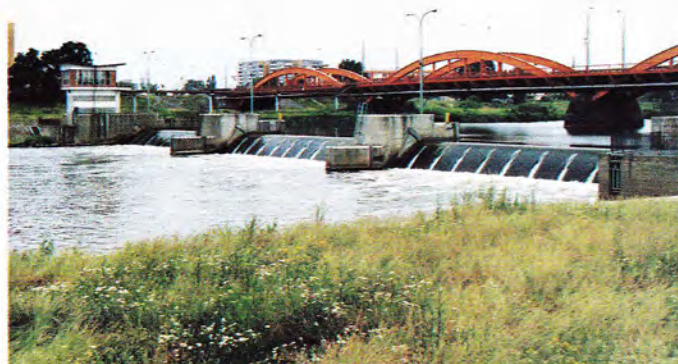
Obr. X. Nový sektorový jez na řece Odře u Różanky ve Wrocławu, který nahradil původní hradlový jez.
