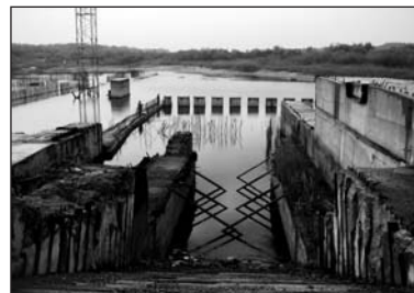
Rozestavěný plavební stupeň Copaceni
