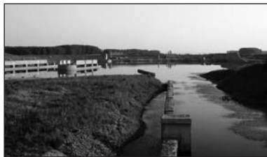
Rozestavěný plavební stupeň Oltenita
