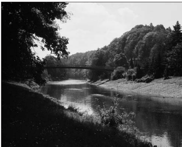
Obr. 5: Současné koryto řeky Bečvy ve stísněné soutěsca v blízkosti teplických lázní nemá dnes dostatečnou kapacitu pro bezpečné převedení povodně. Situaci vyřeší komplexní řešení poldru a vodního koridoru D-O-L, a to jednak díky snížení kulminace, jednak díky značnému prohloubení koryta řeky, jejíž běžné hladiny za středních a nízkých průtoků se ovšem nesníží, takže ráz malebného údolí bude zachován.
