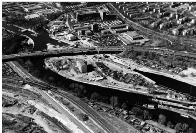
Charlottenburg - uprostřed stavba nové plavební komry typu Va, vpravo dole původní PK
