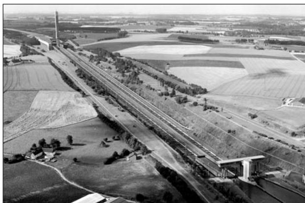
Šikmé lodní zdvihadlo Ronquieres v Belgii pro lodě o nosnosti 1500 tun bylo dokončeno v roce 1968 a nezapře svůj vzor v lodní železnici „Universell“ z přerovské soutěže, která proběhla o více jak půlstoletí dříve.
