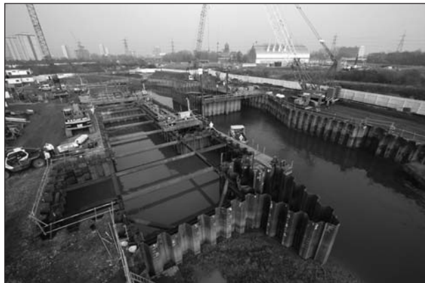
Stavba nového zdymadla New Prescott Lock v Londýně + barevná příloha
