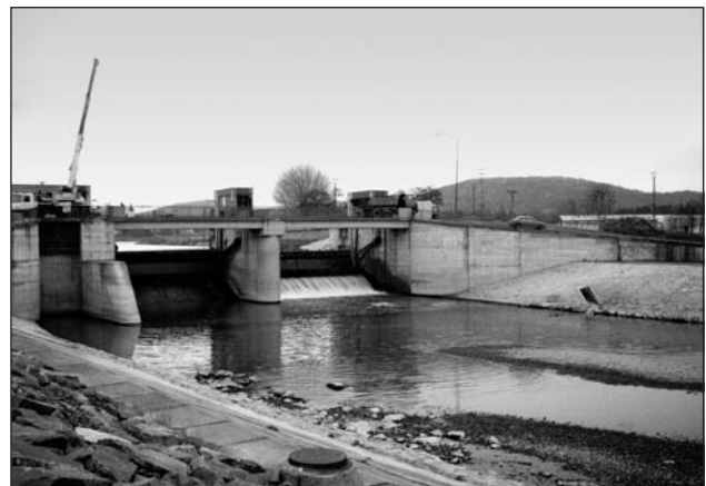
Obr. 4: Jez na Bečvě v Hranicích byl navržen již s ohledem na budoucí potřeby vodního koridoru D-O-L. Umožní rozdělení transformovaného povodňového průtoku mezi koryto Bečvy a paralelní příplavní úsek.
