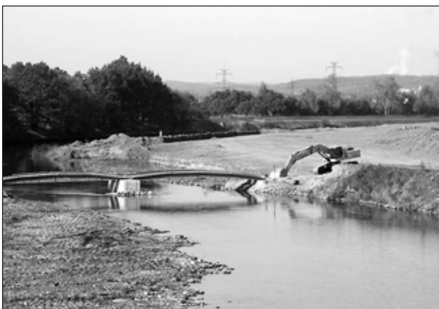
Prohrábky řeky Vltavy pomohou ochránit město České Budějovice před povodněmi a umožní také plavbu lodím do 300 tun
