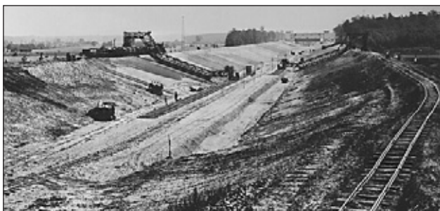
Výstavba průplavu do Lipska, rok 1938 (Foto: Saale – Elster - Kanal Förderverein e.V.)
