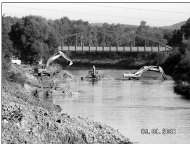
Prohrábký pod jezem České Vrbné umožní pod dokončení nové plavební komory plout lodím z Českých Budějovic na Hlubokou, později po síti vodních cest po celé Evropě
