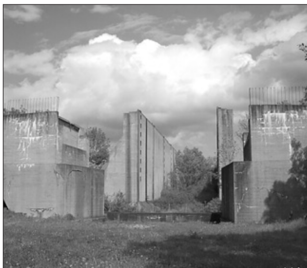
Nedokončená plavební komora Wüsteneutzsch (Foto: Dirk Becker)
