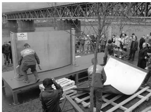
Montáž protipovodňového hrazení membránového typu firmy Strojírny Podzimek s. r. o.
