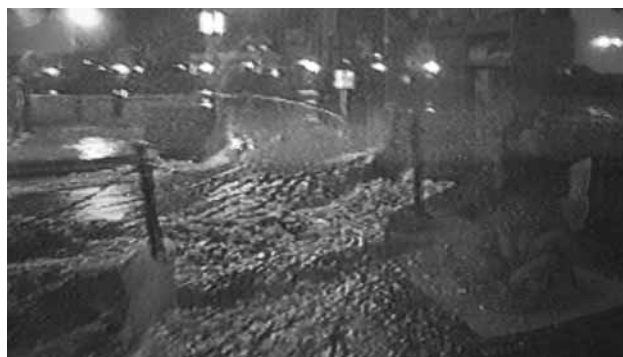
Mobilní protipovodňové hrazení hradidlového typu instalované v Písku se při velké vodě na Otavě v roce 2002 protrhlo
