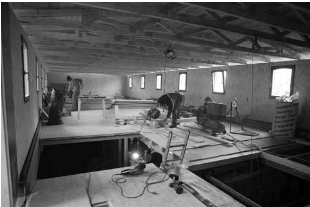
Na přestavbě původní nákladní lodi se podílelo celkem 111 pracovníků
