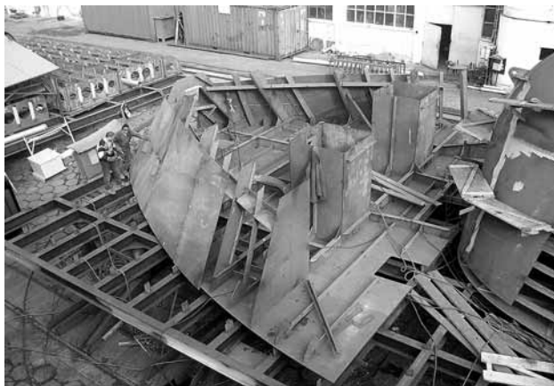
Aobr. 10. také byla postupně dokončována montáž horní části přídě.
