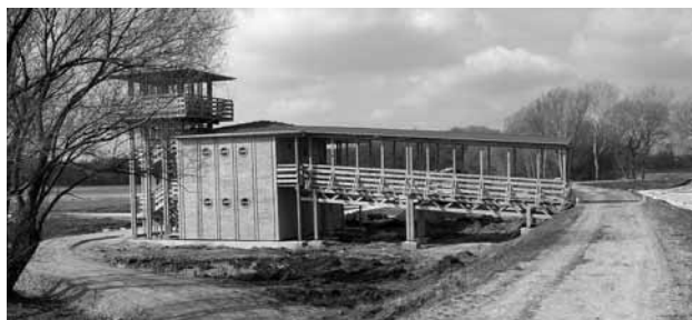
Pohled na provozní budovu z levé hráze po proudu
