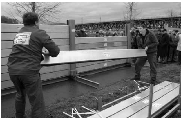
Montáž protipovodňového hradidlového hrazení firmy Eko systém s. r. o.
