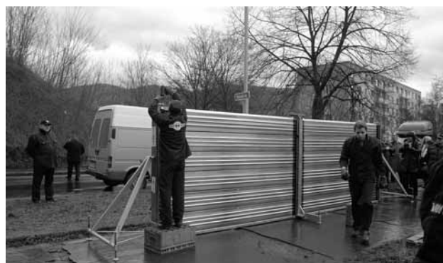
Montáž protipovodňového hrazení firmy SPD Kovo s. r. o.
