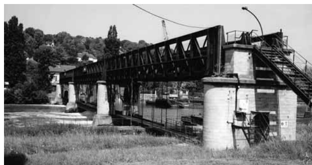
Původní jez l'Isle Adam na řece Oise. V pozadí zahájení stavby nového jezu (červen 2005)
