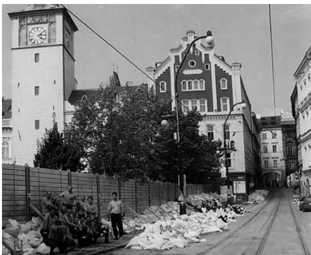
Mobilní protipovodňové hrazení hradidlového typu - Eko systém, použité v Praze u Novotného lávky
