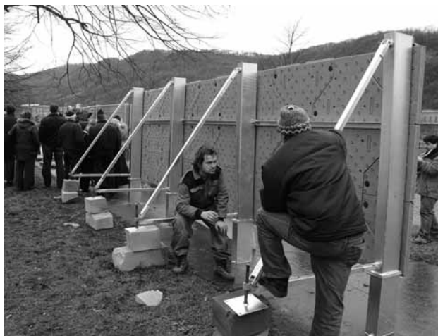
Montáž protipovodňového hrazení firmy SAT Konsult
