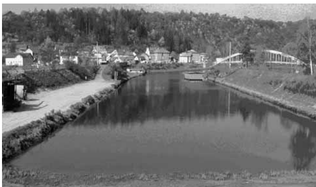
Přístav Štěchovice – současný stav
