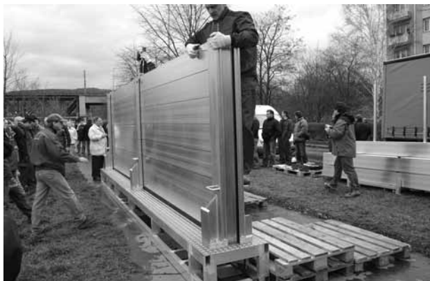
Montáž protipovodňového hrazení firmy PGS
