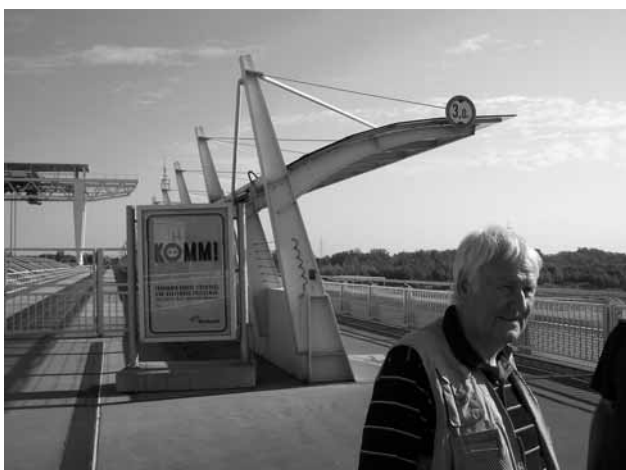
Přes vodní dílo Freudenau prochází zastřešená komunikace pro sportovce, turisty i místní obyvatele
