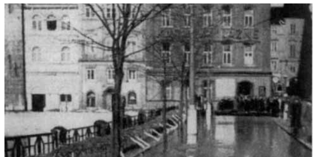
Provizní hrazení z dřevěných hradidel při povodni 15. března 1940 ( Q_{max}=3244 \text{ m}^3/\text{s} ) brání přelítí rozvodněné Vltavy do Starého města pražského (Povodí Vltavy 3-4/79)
