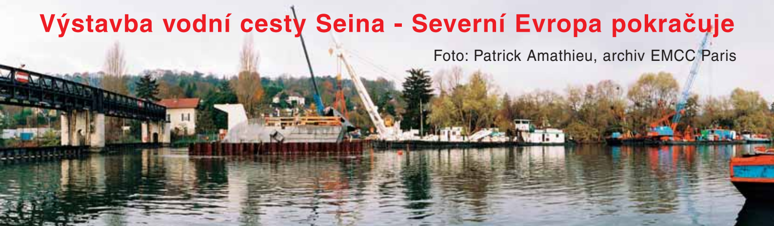
Osazování hradících klapek na jezu l'Isle Adam, prosinec 2005
