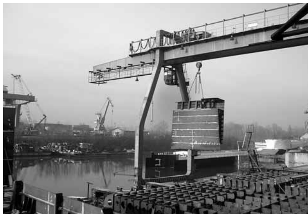
obr. 5. Stavba MS Helenic jde od ruky. Stejný den byla do tělesa usazována sekce přechodového boku.
