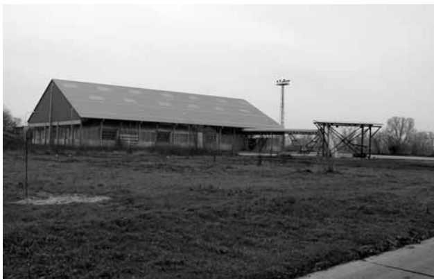
Skladová hala posypové soli v přístavu Lovosice po dohotovení v říjnu 2006
