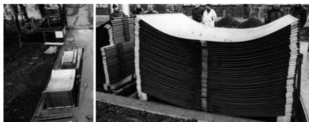
Celé hrazení membránového typu v délce 250 m včetně slupic a pomocných jeřábků je uskladněno v podzemním skladišti o velikosti 10,5 x 2,2 x 1,85 m
