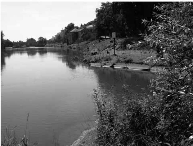
Vjezd do maríny - současný stav - nátok do vedlejšího ramene v horní části Kmochova ostrova
