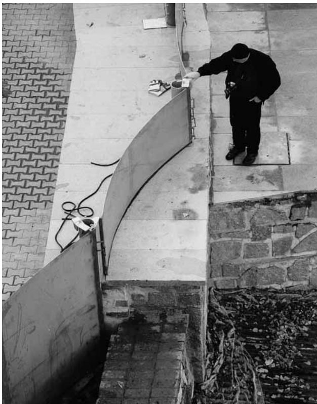
Membránové hrazení je vhodné pro různé výšky. Lze ho umístit na terén i opěrné zdi.
