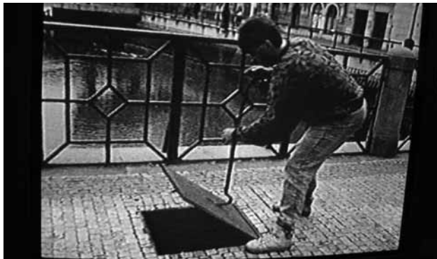
Ve filmu „Čekání na stoletou vodu“ figurant ukazuje kotevní místa pro osazení slupic protipovodňového hrzení
