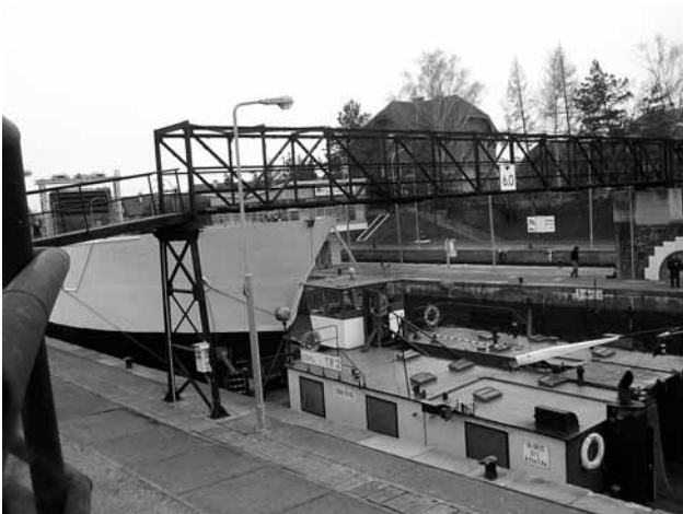
obr. 6. Těleso bylo zabalastováno pomocí 8 čerpadel, která byla pro tento účel spěšně zakoupena, na ponor 180 cm. Betonový práh v komoře a lávka pro pěší, umístěná nad plavební komorou, nedovolovaly příliš mnoho improvizace. Člen posádky na snímku, sledující průběh podplouvání lávky, musel za několik okamžiků rychle utíkat.
