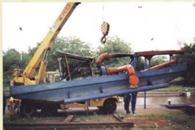
Doprava čerpacího prámu typ Povodí Vltavy
