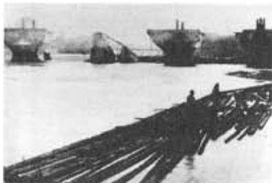
Karlův most v Praze za povodně v r.1890
