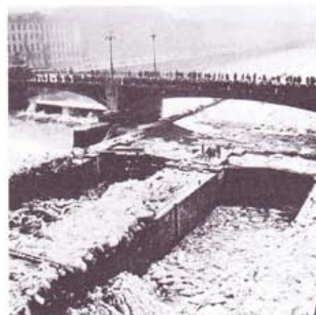
Plavební komory na Vltavě v Praze na Švanici (1910)
