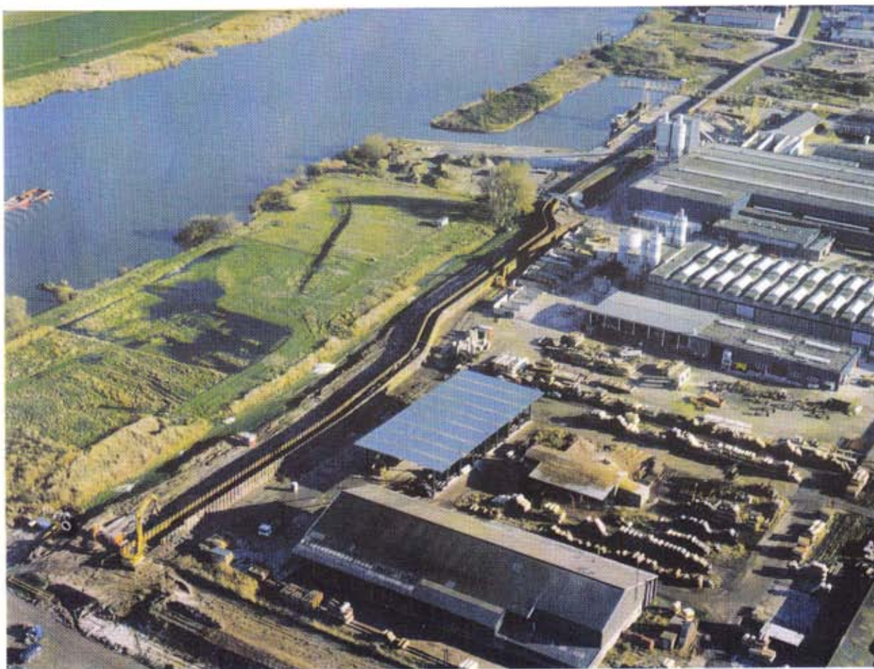
Zvyšování hrází u města Kampen (řeka Ussel) pomocí štětových stěn.
