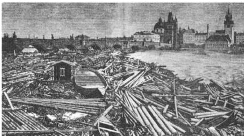
Při povodni roku 1872 se nad Karlovým mostem nahromadilo množství plovoucích předmětů - kmenů, vorů, lodí i zbytků dřevěných pobřežních objektů, které velká voda zničila.
