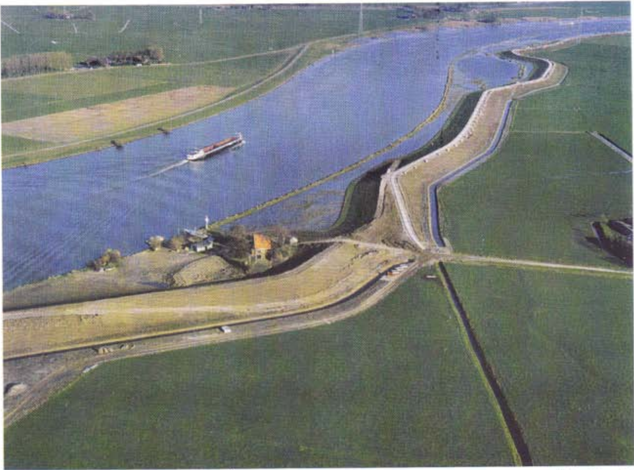
Úprava hrází v zemědělské oblasti u města Kampen (řeka Ussel).
