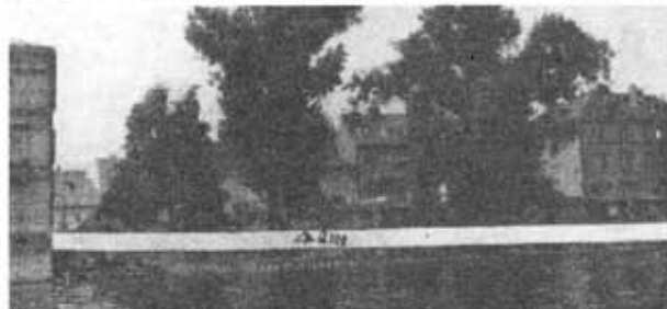
Průběh hladiny stoleté velké vody pod Lichtenštejnským palácem
