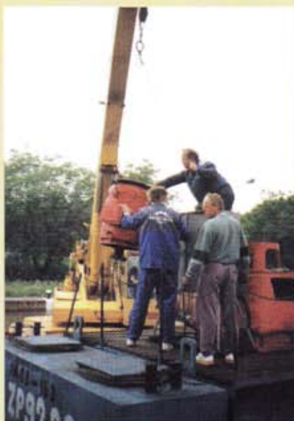
Nasazení čerpacího prámu s elektromotorem
