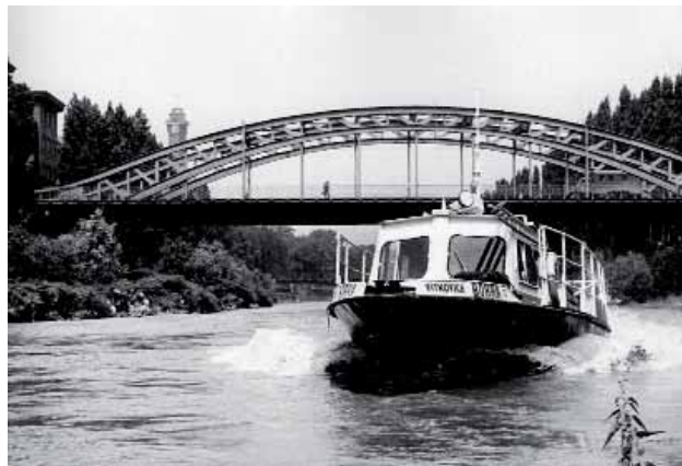
Lod Bobra pod Sýkorovým mostem při zkušební plavbě na Ostravicí 24. 7. 1980
