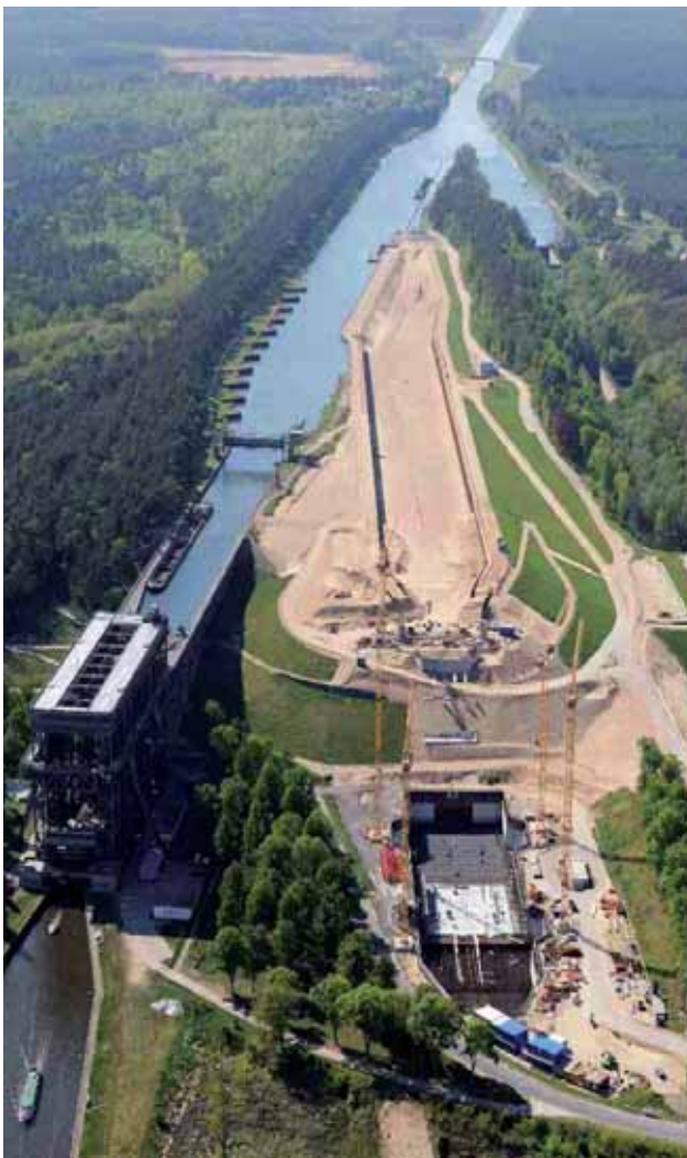
Letecký pohled na starý (vlevo) a výstavbu nového lodního zdvihadla Niederfinow - 7. 5. 2011
