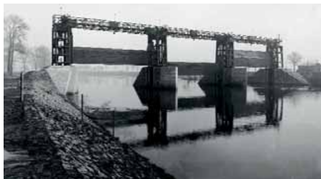
Koblovský jez dokončený v roce 1937
