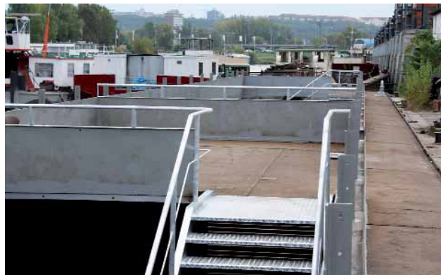
Aktuální průběh rekonstrukce - před nástavbou
