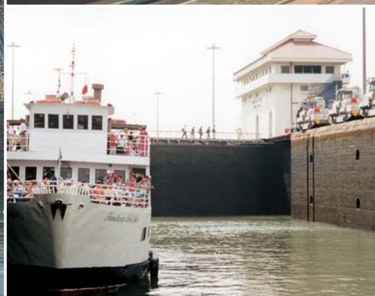
Dvojstupňová plavební komora Miraflores
