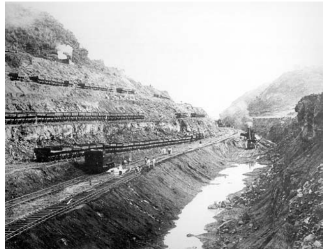
Odvoz materiálu při výkopových pracích v Culebra Cut
