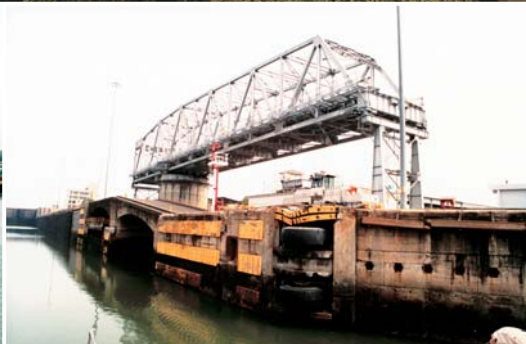
Celkový pohled na dvou stupňovou plavební komoru Miraflores s vodní elektrárnou zásobující teplem a elektřinou celý průplav. Ve spodním ohlavi je dvoudílný otočný most.
