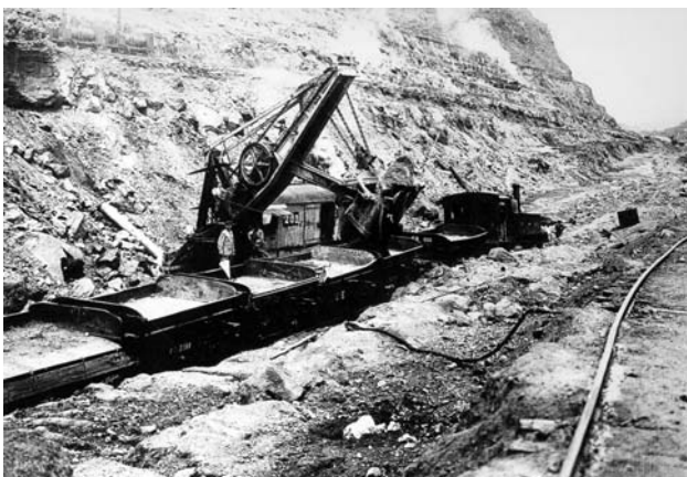
Výkopové práce na průplavu v roce 1904
