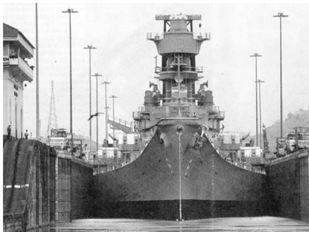
Americká válečná loď se šířkou 33 m patří mezi největší plavidlo, které může proplout Panamským průplavem. Na obr. je loď v plavební komoře Miraflores.
