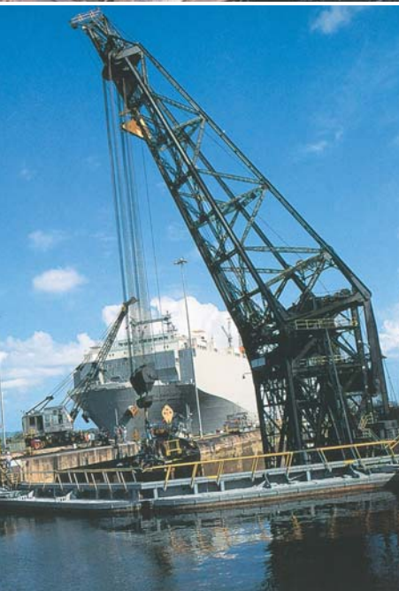
Výměna vrátně plavební komory
