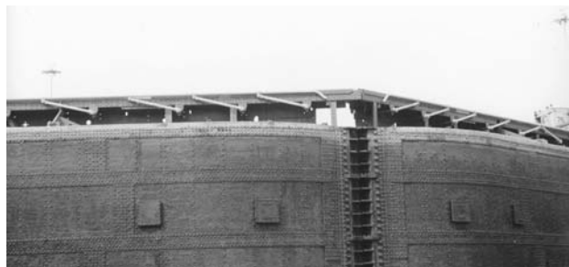
Zábradlí na vratech plavebních komor je sklopné
