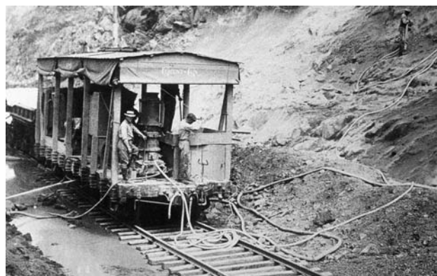
Zpevňování stěn proti sesuvu cementovou injektáží v roce 1911
