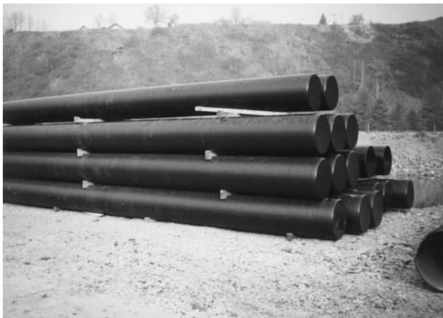
Plastová potrubí před montáží
