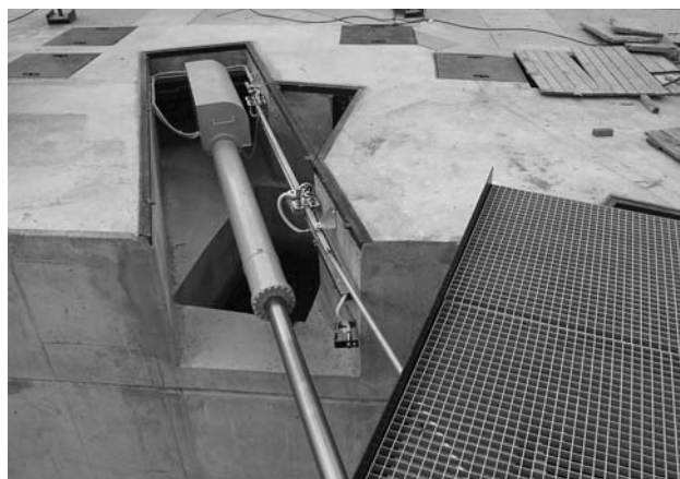
Elektromechanické ovládní vzpěrných vrat VPK
