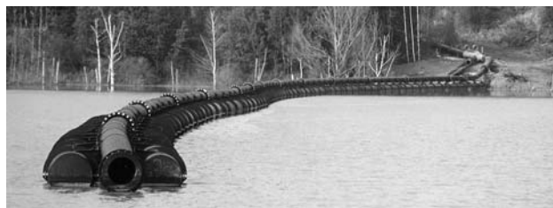
Plovoucí dopravní potrubí před dokončením v Litvínově
