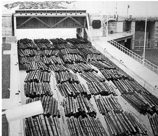
K proplavování dřeva ve svazcích se na finských vodních cestách používá i speciálních plavebních komor
