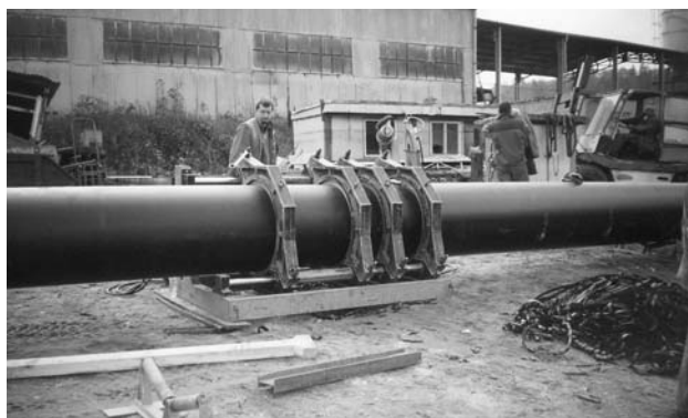
Svařování plastových potrubí
