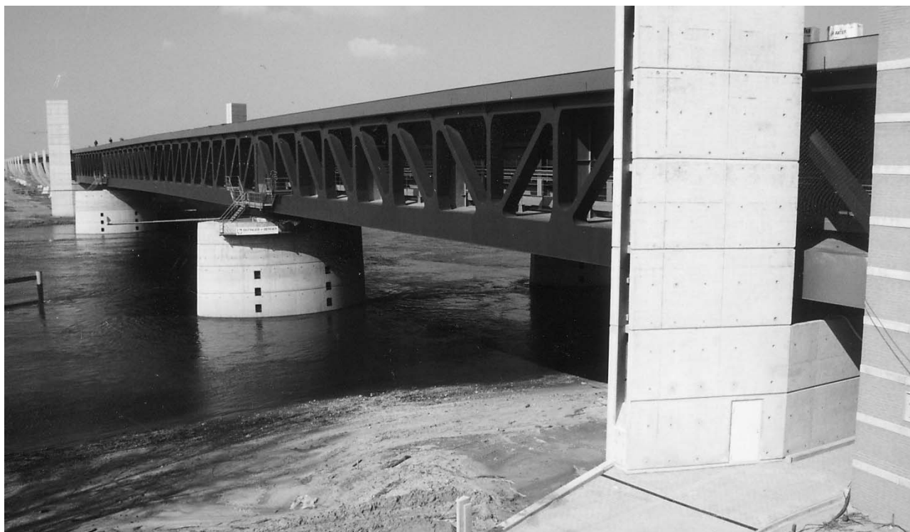
Návodní část průplavního mostu těsně před dokončením
