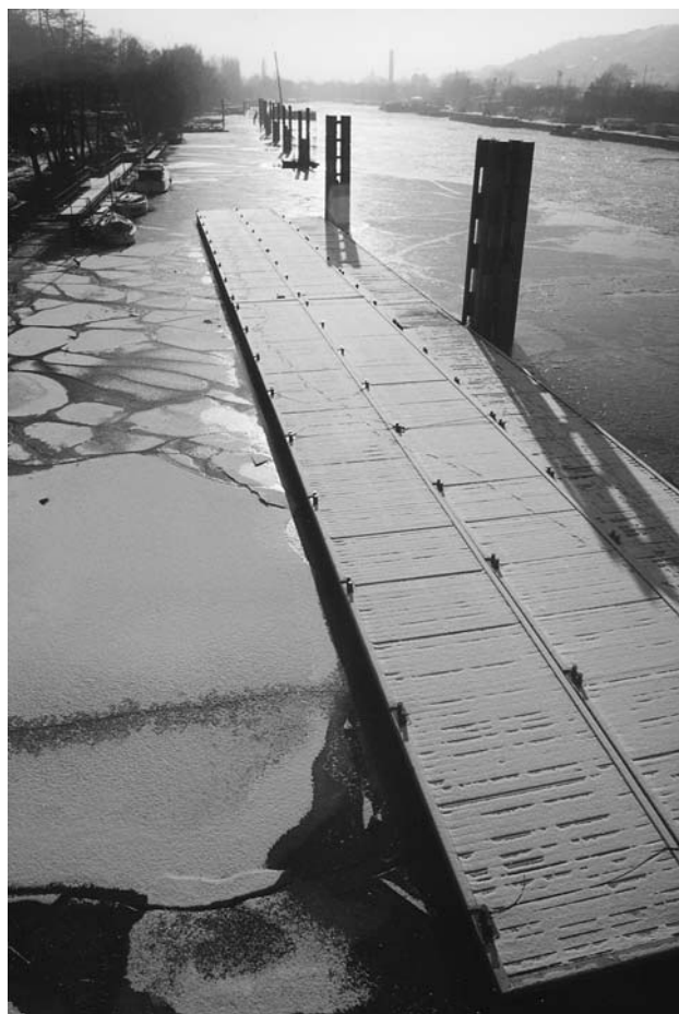
Vázací protipovodňové dalby ve Smíchovském přístavu na Vltavě v Praze. Vedle plovoucího plata na klasických ocelových plovácích (vpravo) jsou provizorně ukotveny dva díly nových plovoucích plat na plastických plovácích (vlevo). Dokončení montáže se předpokládá v 1. čtvrtletí 2004.
