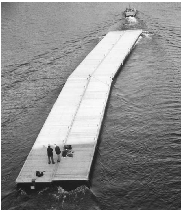
Přeprava první sekce plovoucího mola ze Štěchovic do přístavu Praha - Smíchov
