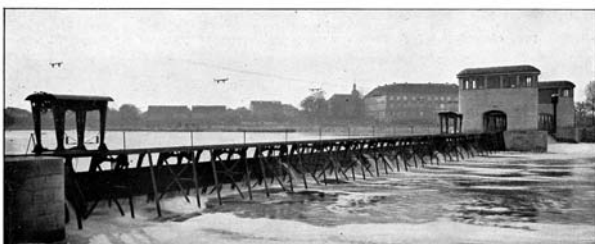
Zdymadlo na Labi v Obřívství. Stavidlový a mostový jez slupicový, spád 2,20 m. Stavba z roku 1913.
