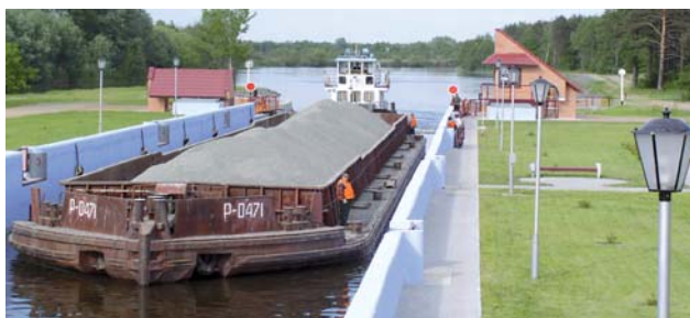
Plavební komora Novosady, uvedena do provozu v roce 2003
