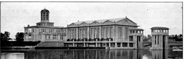
Zdymadlo a elektrárna na Labi v Poděbradech. Stavidlový jez s klapkou, spád 2,20 m. Stavba z roku 1925.
