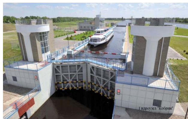
Plavební komora Kobrin, která nahradila dva stupně 6-7, byla uvedena do provozu v roce 2009
