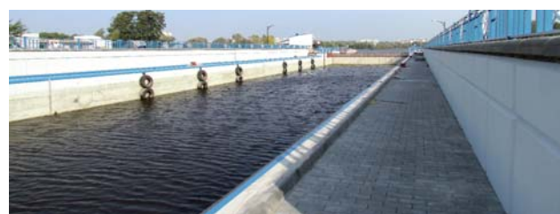
Plavební komora Trišin, uvedena do provozu v roce 2011
