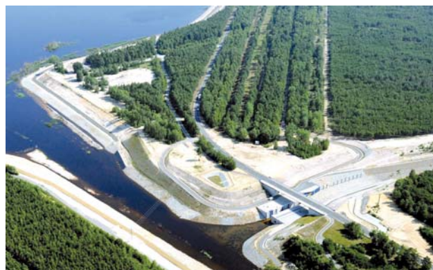
Propojka č. 6 je již vybudována, ale čeká na napuštění jezer
