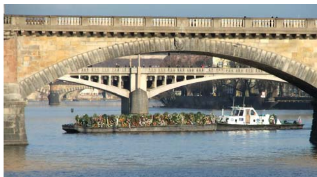
Pod Palackého mostem v Praze
