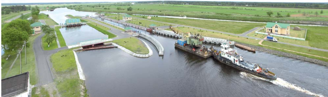
Plavební komora Duboj byla uvedena do provozu v roce 2006
