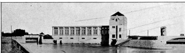
Zdymadlo a elektrárna na Labi v Nymburce. Stavidlový jez s klapkou spád 2,70 m. Stavba z roku 1925.
