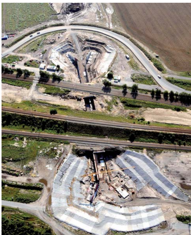
Výstavba propojky č. 11, která podchází tři železniční tratě a silnici
