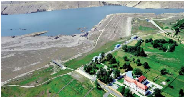
Letecký pohled na napouštěné jezero Großbräschener See a návštěvnícké centrum IBA
