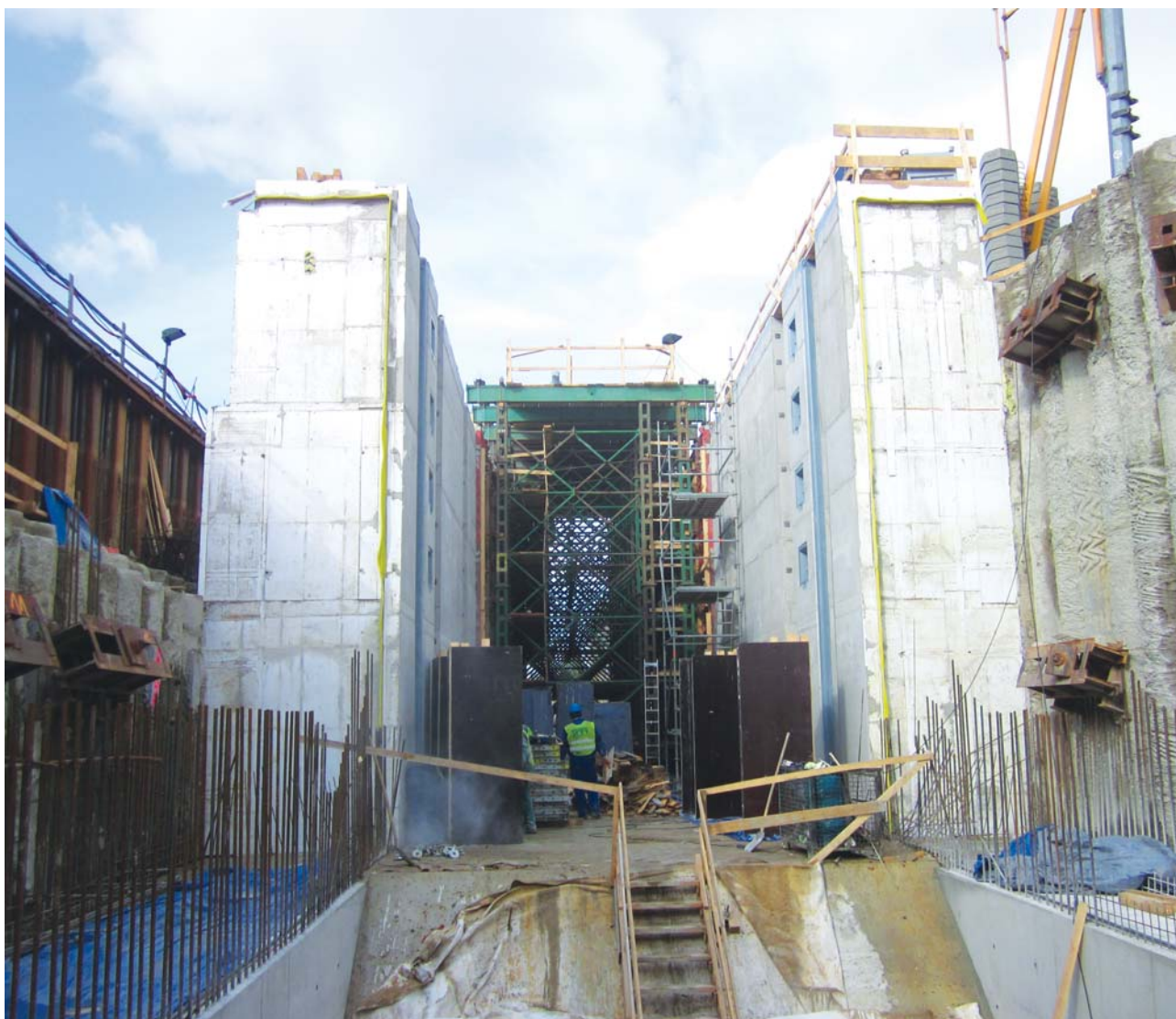
Výstavba plavební komory Hluboká nad Vltavou
