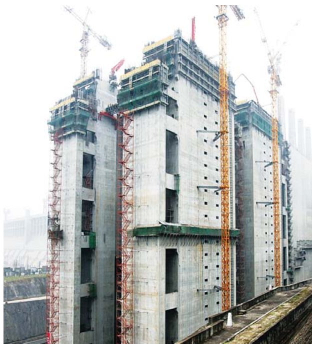
Výstavba nejvyššího lodního zdvihadla na světě na přehradě Tři soutěsky pokračuje - únor 2012
