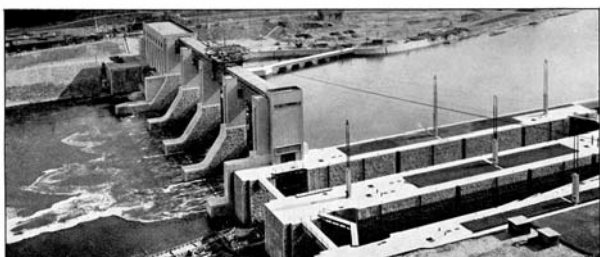
Zdymadlo a elektrárna na Vltavě u Vraného. Dvoudílný jez, spád 13,40 m. Stavba z roku 1936.
