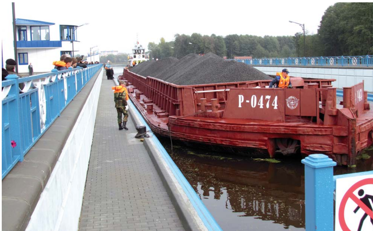
Nová plavební komora Trišin odpovídá evropskému standardu Va
