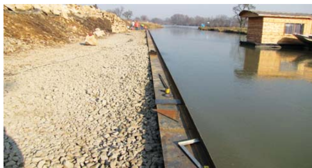
Výstavba přístaviště Spytihněv
