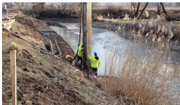
Výstavba přístaviště Sudoměřice - Výklopník
