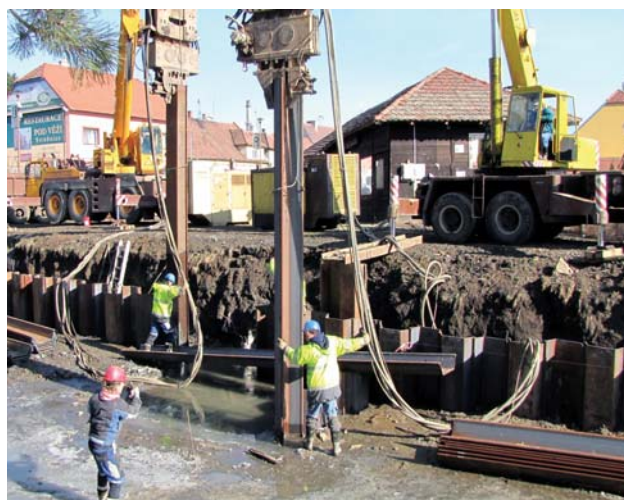
Výstavba stání plavidel ve Strážnici
