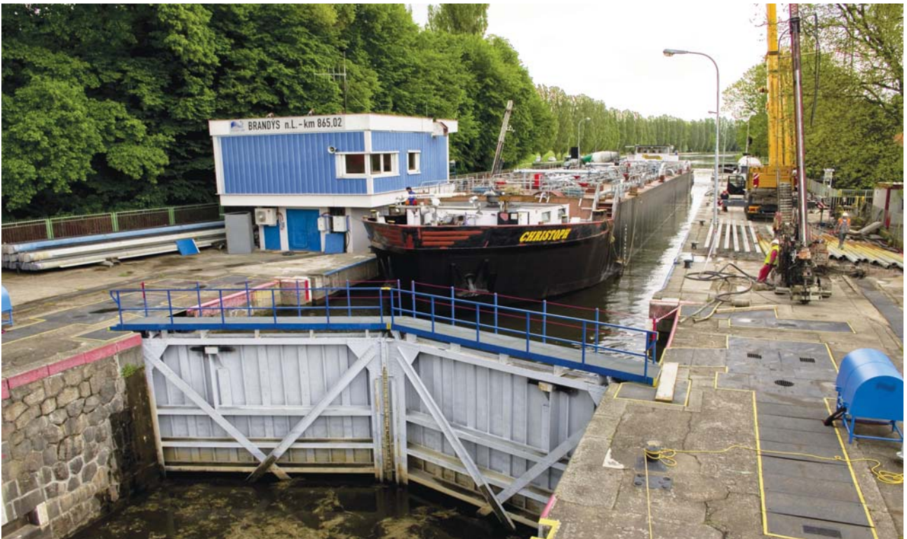
Tanker CHRISTOPH v rekonstruované plavební komoře Brandýs nad Labem
