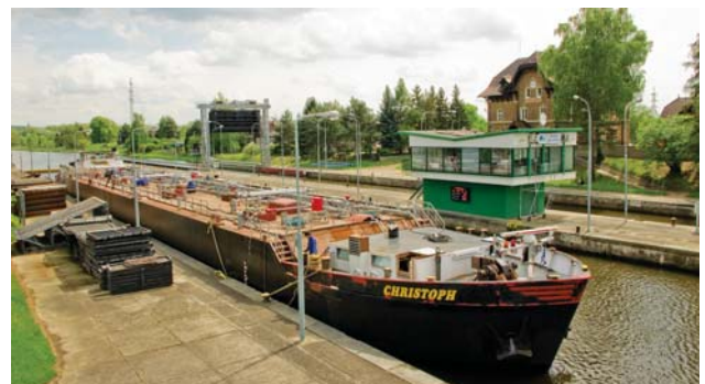
Plavební komora Dolní Beřkovice
