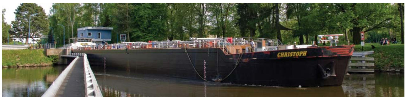
Dolní rejda plavební komory Poděbrady
