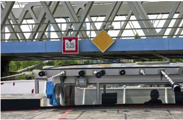
Těsné podplutí kolínského železničního mostu
