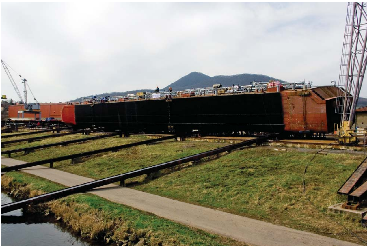
Středová část tankeru připravená ke spuštění v loděnici Barkmet ve Lhotce
