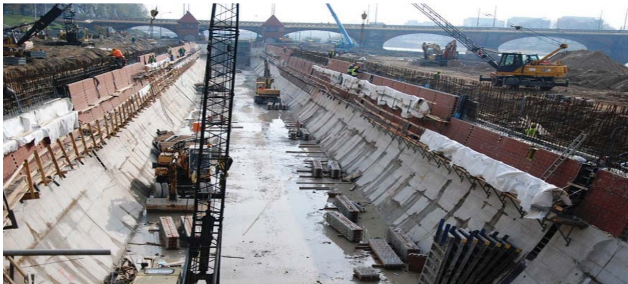
Modernizace plavební komory Różanka na Odře
