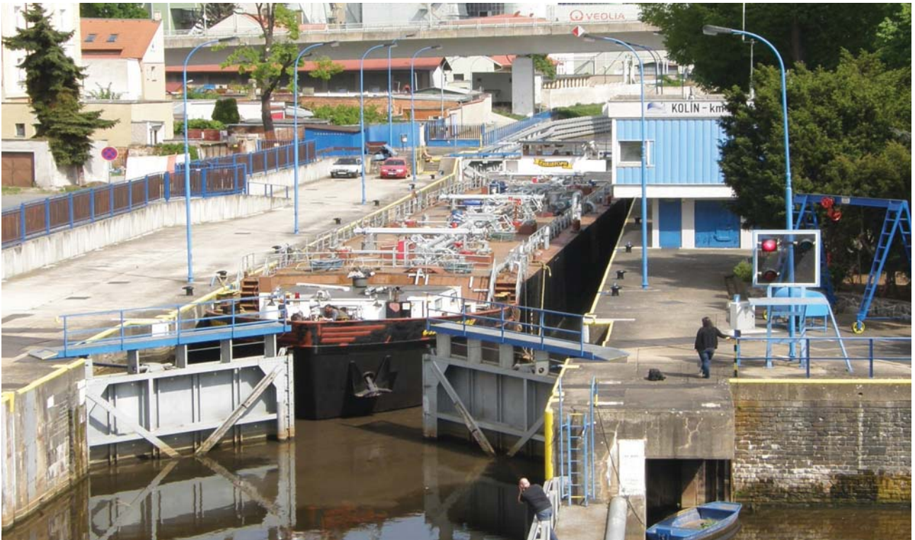
Plavební komora Kolín
