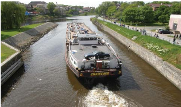
Dolní rejda plavební komory Kolín
