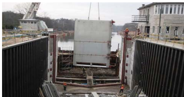
Modernizace plavební komory Rudziniec na Gliwickém průplavu
