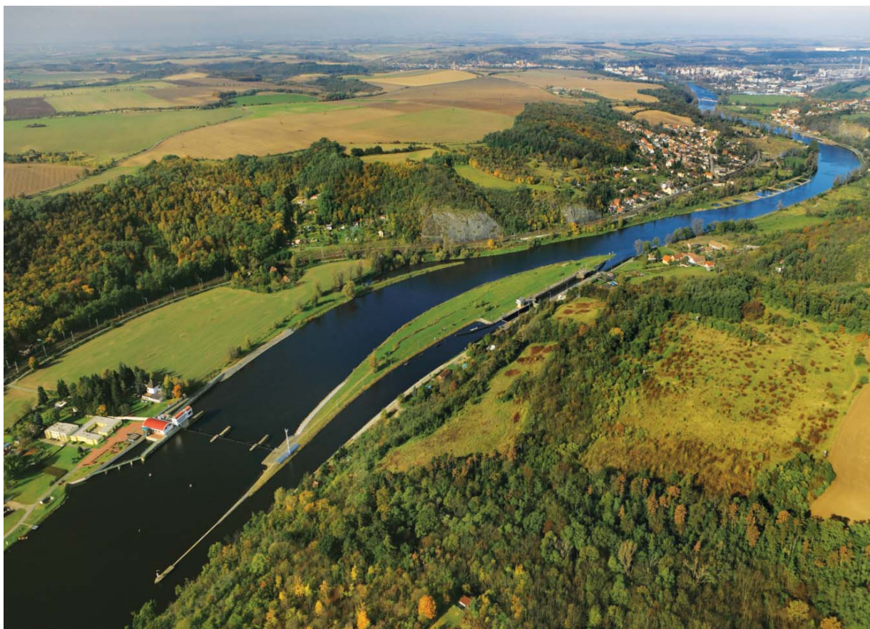
Vltavský kaňon a plavební stupeň u obce Dolany nad Vltavou
