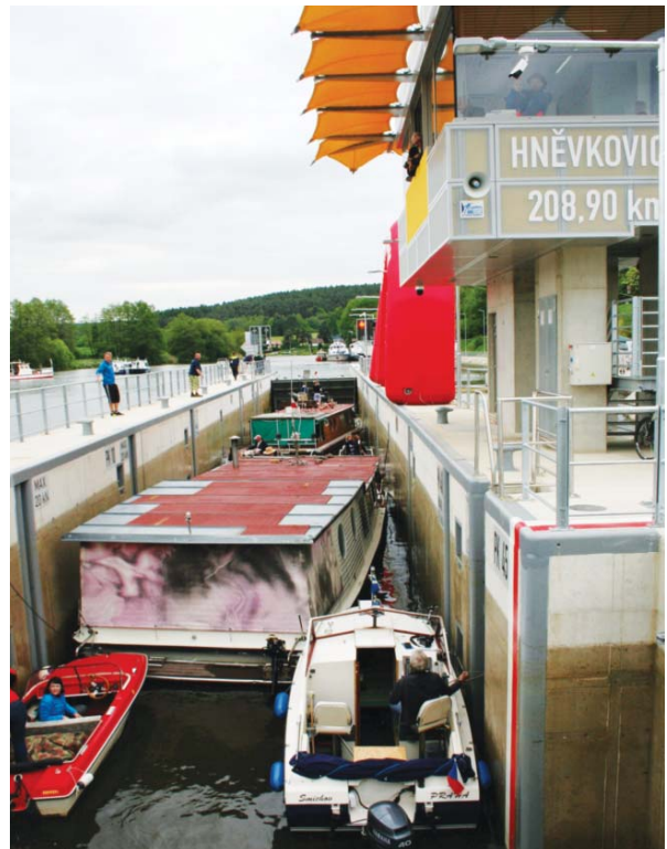
Plavební komora Hněvkovice praská ve švech
