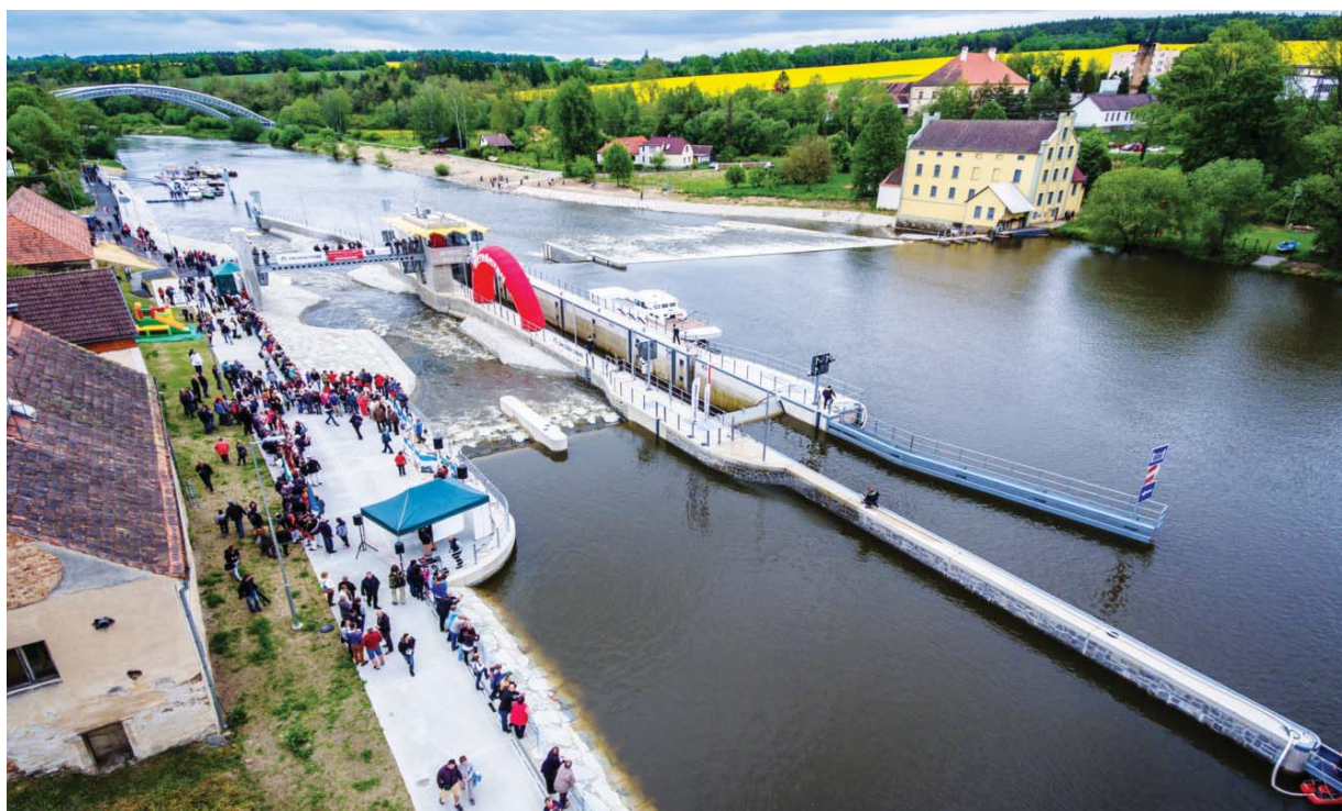
Celkový pohled na plavební komoru na jezu Hněvkovice v den slavnostního otevření
