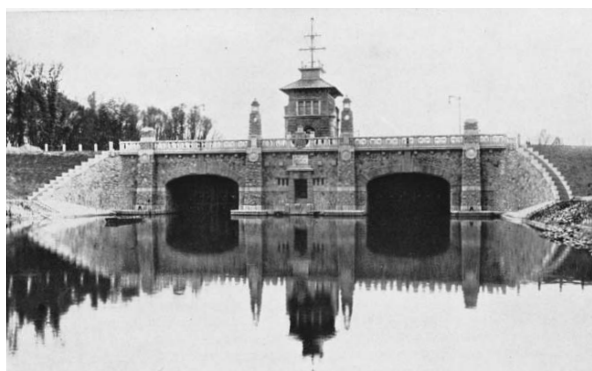
Spodní ohlavi plavebních komor v Hoříně (1905)
