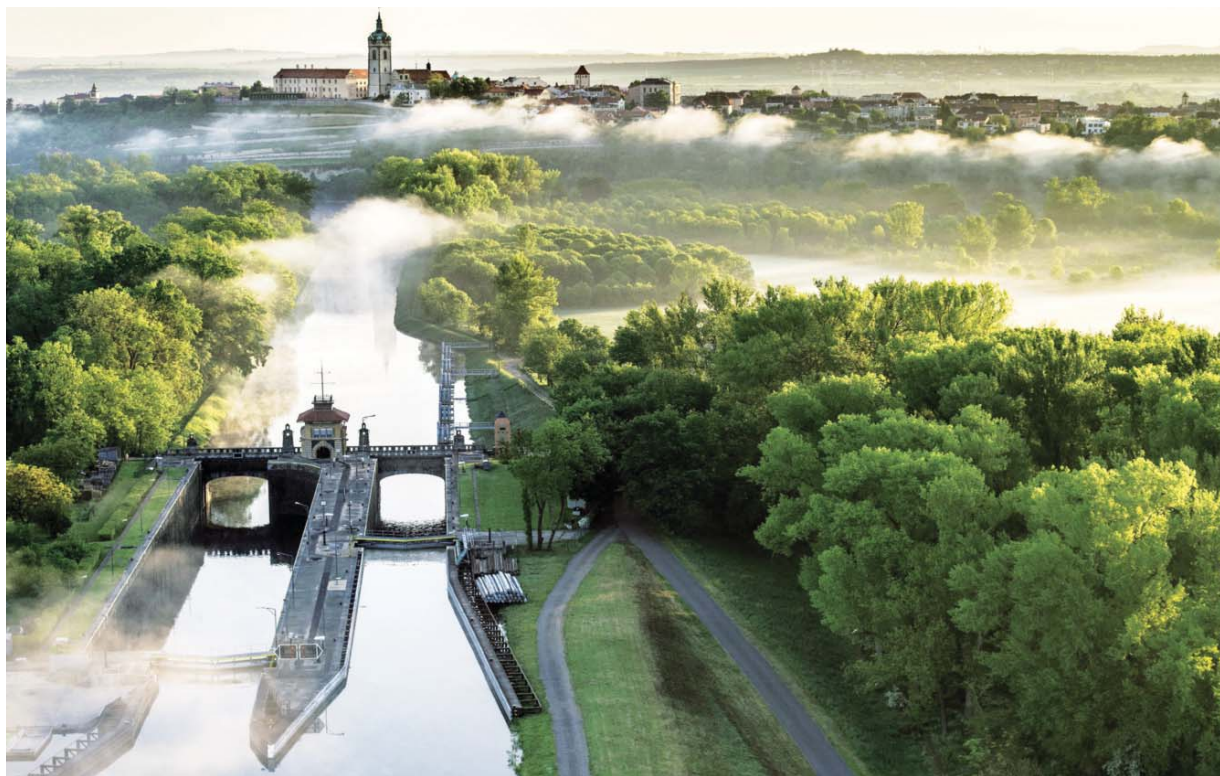
Komory na Hořínském plavebním kanále u Mělníka
