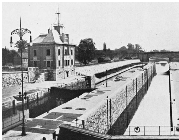
Plavební komory na Vltavě v Praze na Štvanici (1913)
