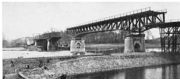
Stavba mostu a jezu v Roudnici na Labem (1909)
