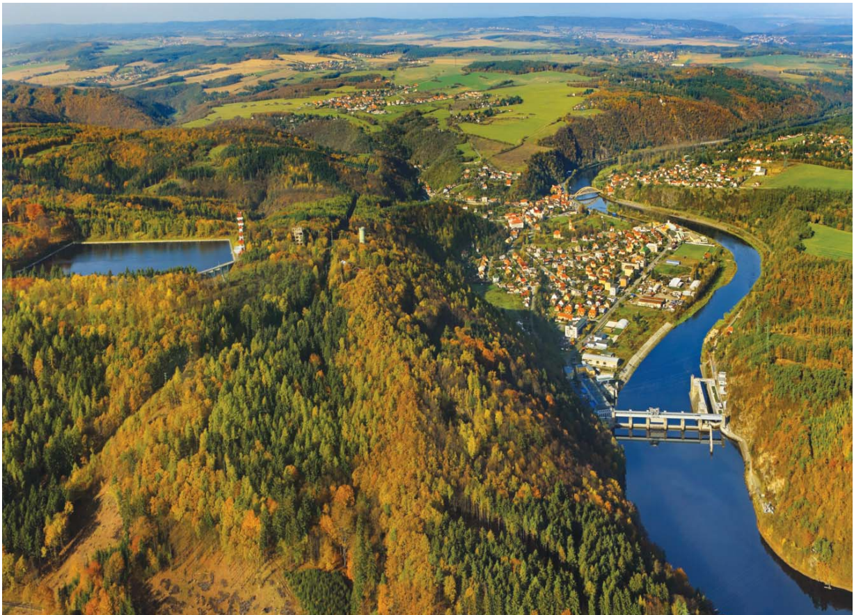
Vodní dílo Štěchovice a přečerpávací elektrárna
