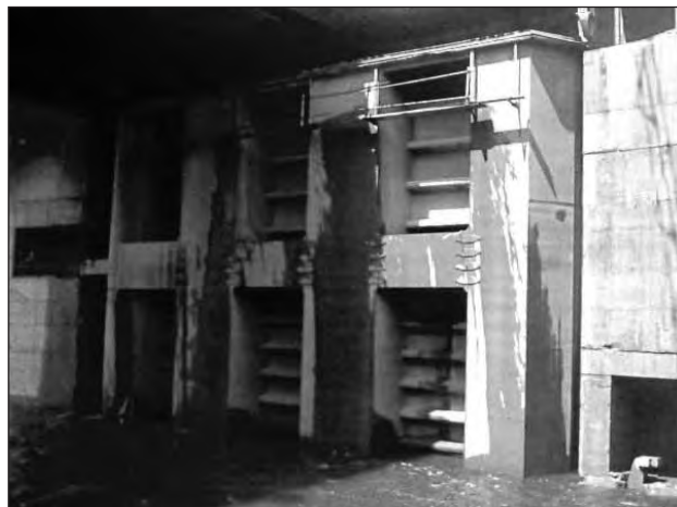
Obr. 2 Původní desková vrata plavebních komor
