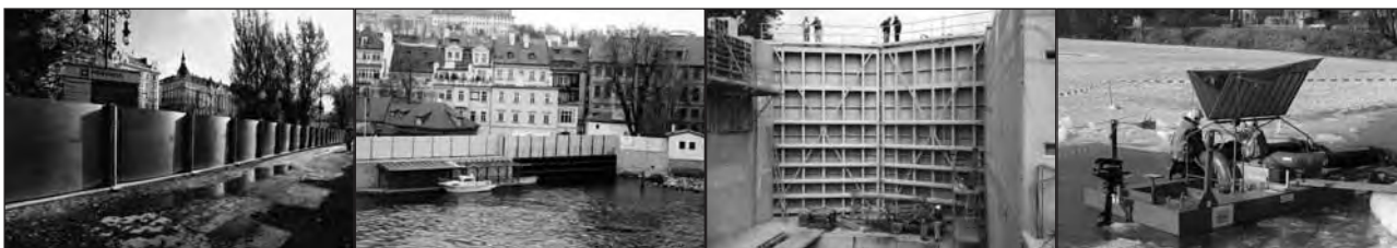
Protipovodňová ochrana paláce Žofín
