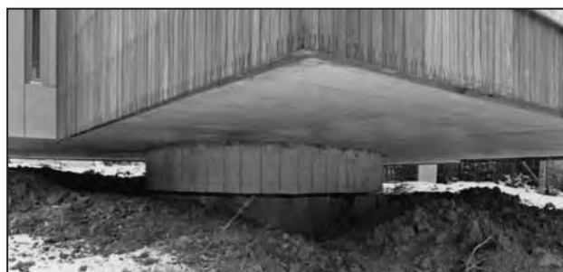
Základ domu u řeky Berounky
