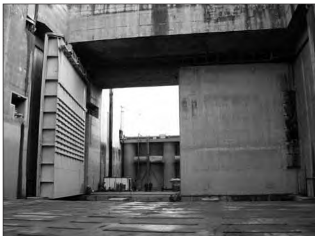
Obr. 4 Současná konstrukce deskových vrat (foto T. Rotter)
