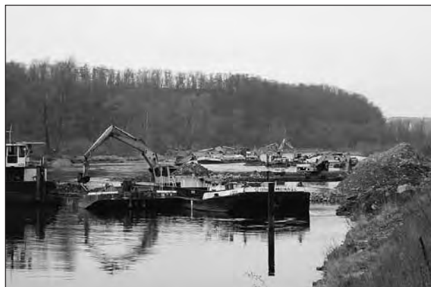
Úprava plavební úžiny Chvatěrubu. Foto: Libor Štěrba - Zakládání staveb a.s.
