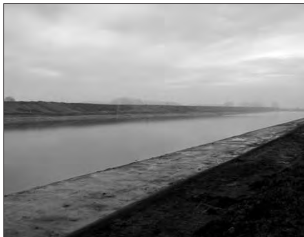
Výstavba 1. fáze průplavu Dunaj-Sáva Zdroj: Agencija za vodne putove
