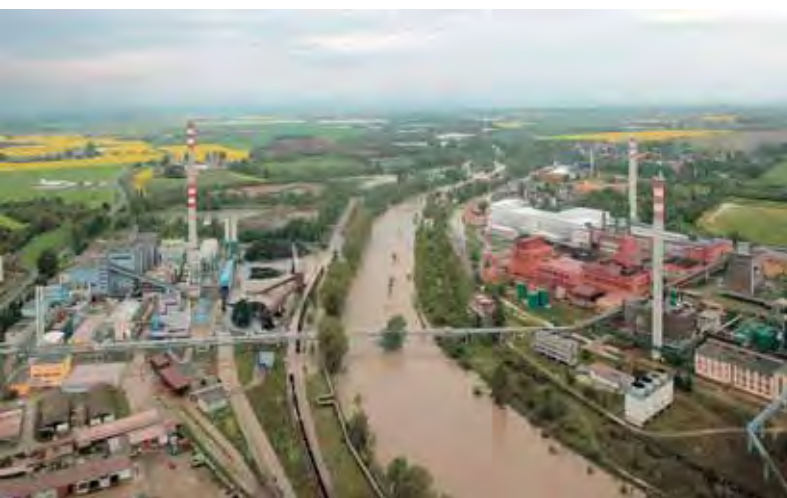
Voda zaplavila v Přerově chemické závody a teplárnu a vyřadila ji z provozu na několik týdnů
