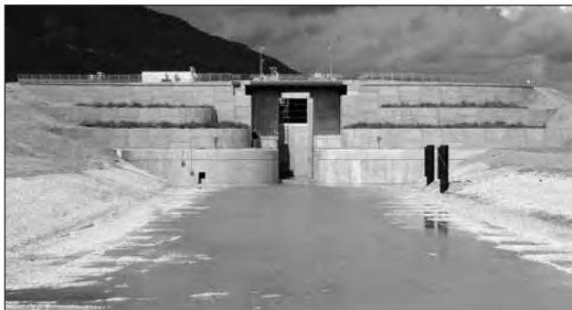
Nová plavební komora Chautagne před uvedením do provozu.
