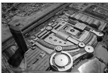
Největší obchodní centrum na světě Dubai Mall, z kterého se vchází do nejvyšší budovy světa Burj Dubai
