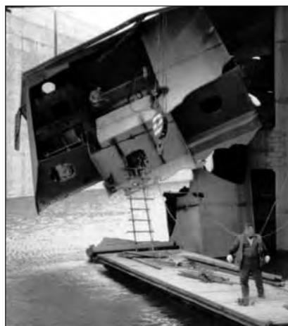
Obr. 3 Demontáž původních poškozených deskových vrat (foto J. Podzimek)
