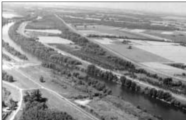
Ilustrační foto: Vážská vodní cesta situovaná v dolním úseku řeky Váh
