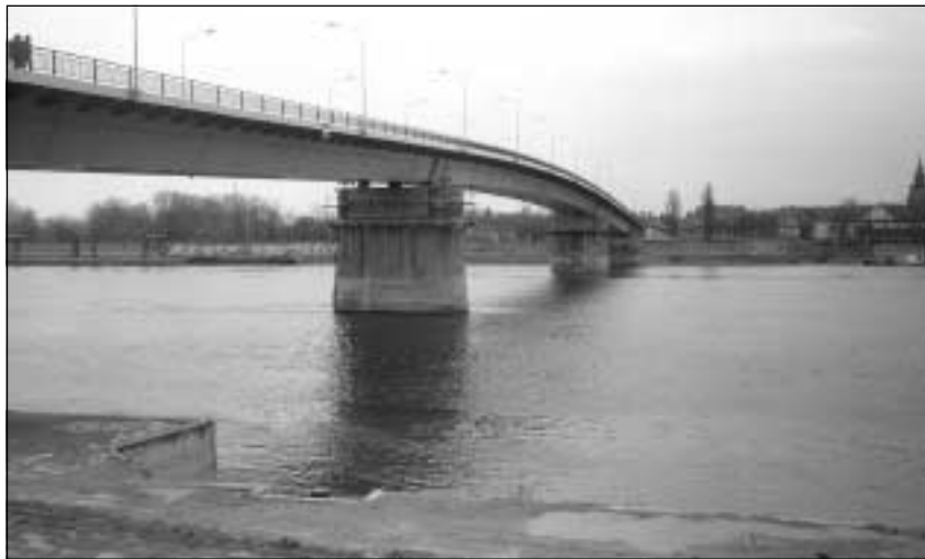
Nový Varadinský most, postavený na pilieroch zbombardovaného mosta
