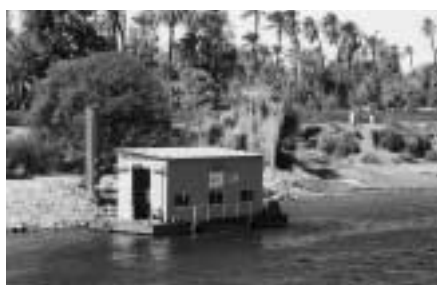
Bez plovoucích přečerpacích stanic pro rozsáhlý zavlažovací systém si nelze představit život podél Nilu.
