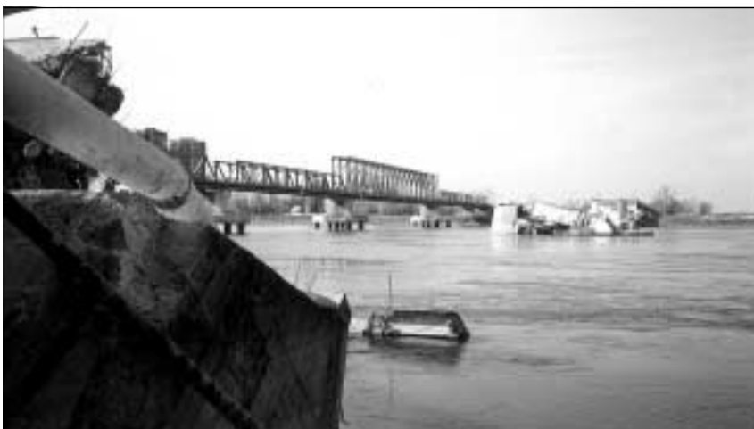
Trosky mosta Žeželj, vľavo železnično-cestný provizorný most
