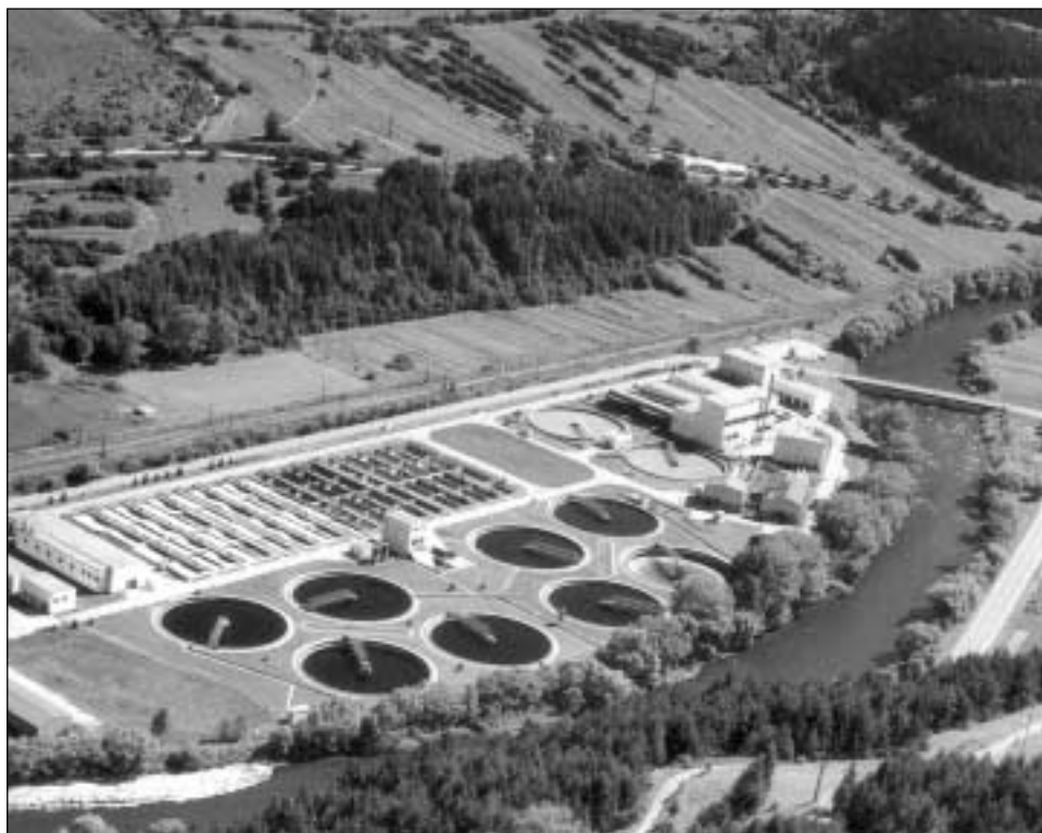
Ilustrační foto: Čistírna odpadních vod (Ružomberok)
